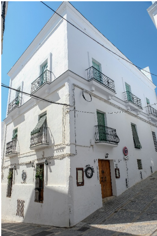
Edificio en cuyos bajos se encuentran los restos de la ermita (Foto de Javi Moreno)
