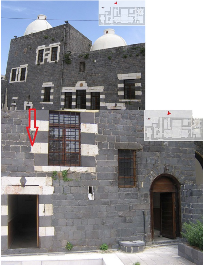
Fig. 13. La demeure Mūfid al-ʿĀmīn: photos montrant la composition de la façade ouest intérieure et des coupoles (I. Fayyad).
