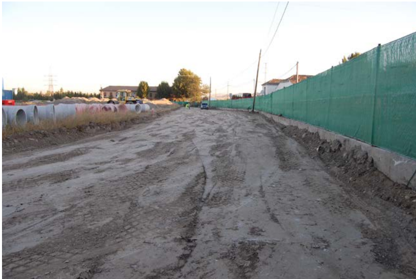
Ilustración 64. Vista del solar una vez cubierta la zanja de excavación del saneamiento. Desde el Sur.
