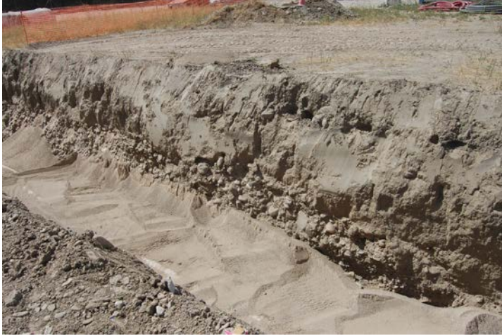
Ilustración 67. Una vez colocados los tubos se vuelve a rellenar completamente la zanja.
