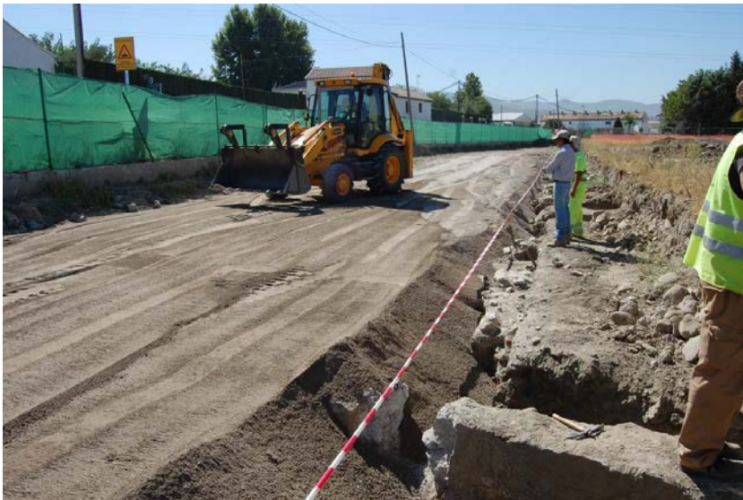
Ilustraciones 58 y 59. Seccionamiento de estructuras para proceder a la extracción de las mismas. Muro correspondiente a la E 17
