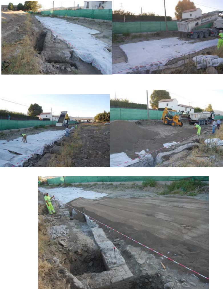
Ilustraciones 51 a 55. Cubrición con geotextil y arena excepto en la zona de zanja de saneamiento.
