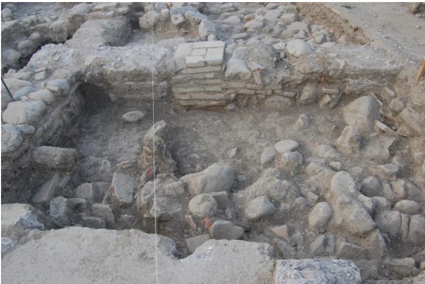
Ilustración 21. Reforma fase III. Muro de hormigón E9, UE 28, reformado con pilar y muro de ladrillo y mampuesto UE 30
