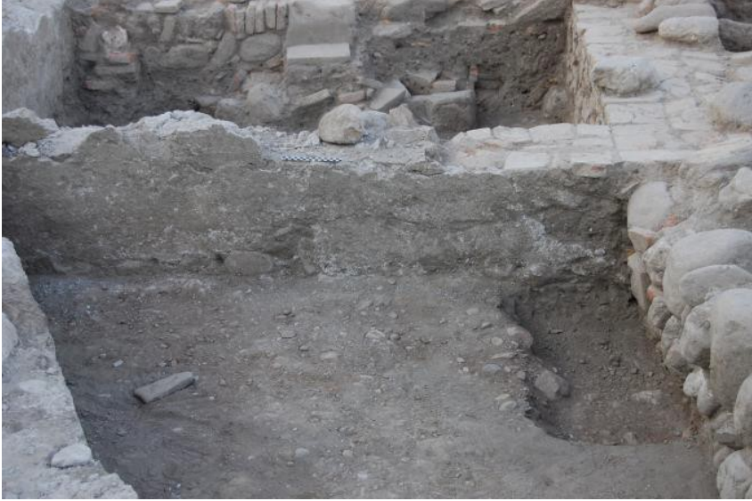
Ilustración 22. E 1, muro de hormigón UE 1037 y reforma de mampuesto y ladrillo UE 1040. Vista desde el Norte.
