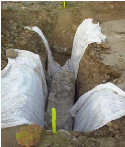
Ilustración 68. Reintegración del muro E 17
