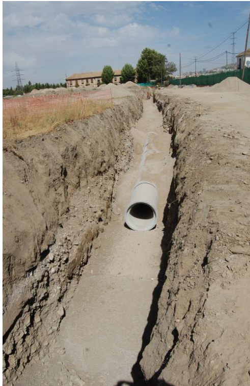
Ilustraciones 65 y 66. Colocación de los tubos para el saneamiento.
