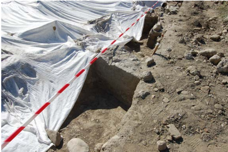
Ilustración 43. Estructura muraria E 17, antes de seccionamiento.
