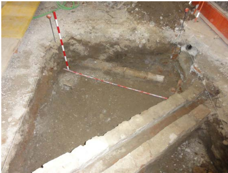
Lam. 5. – Vista general del sector 4, una vez terminadas las labores de rebaje
