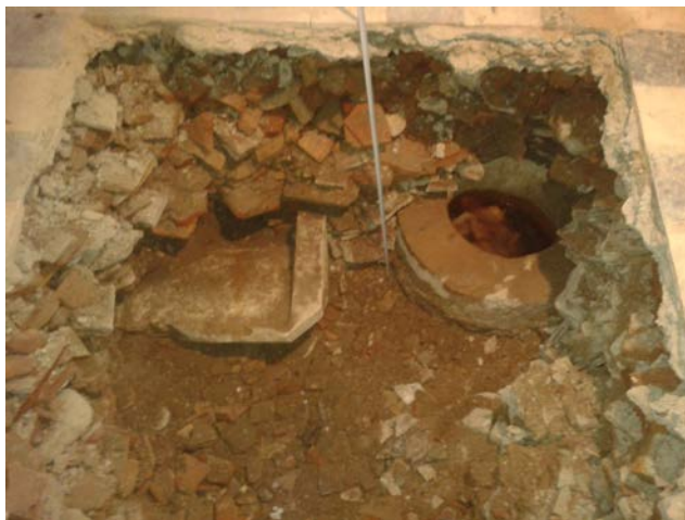
Lam. 4.- Vista de la boca de pozo localizado en el Sector 3.
