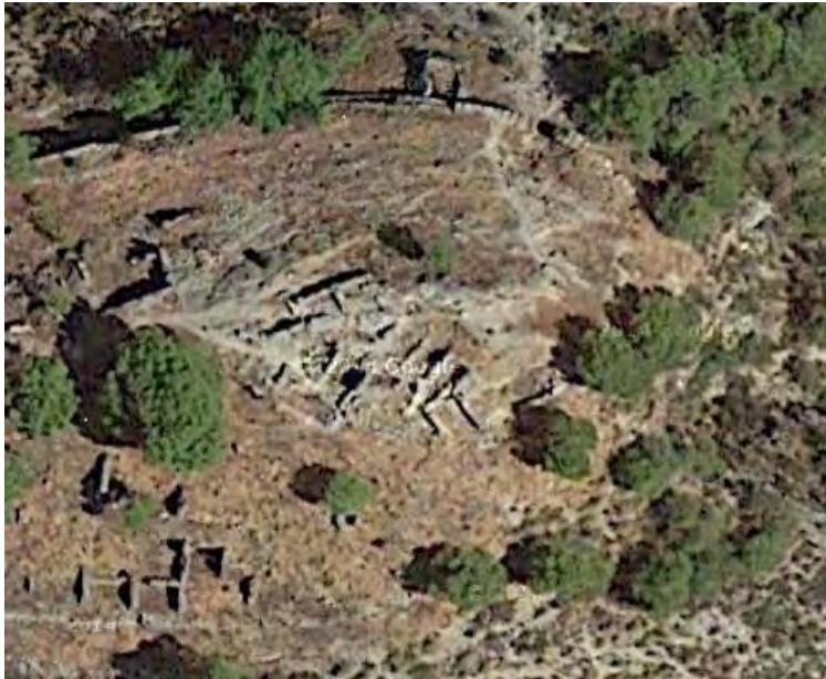
Restos de la zona excavada parcialmente y torre.
