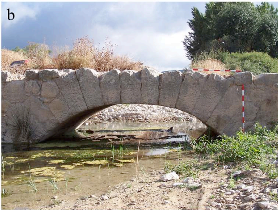
Lámina 4. Estructura del arco aguas abajo se ven las reparaciones y las juntas de las dovelas (4a) y detalle del arco y dovelas aguas abajo (b) (Fuente: Rafael J. Pedregosa Megías)
