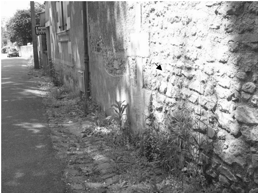
Emplacement de la dalle funéraire
