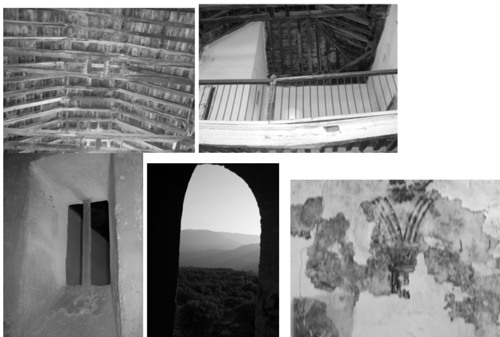
Artesonado, coro, ventana del alminar, campanario y restos de pinturas en el altar mayor.
