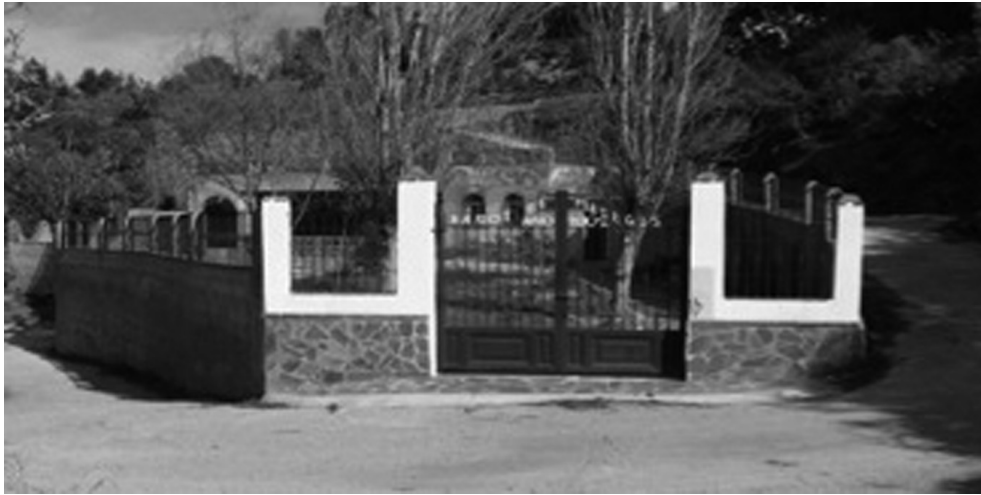
“El Baño” Baños termales en Melegís
