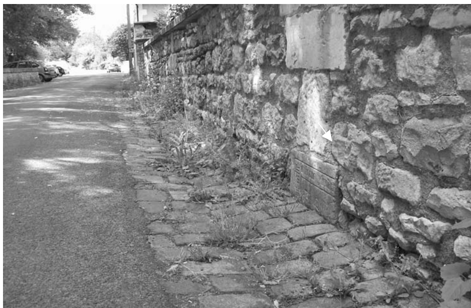
Emplacement de la dalle funéraire.
