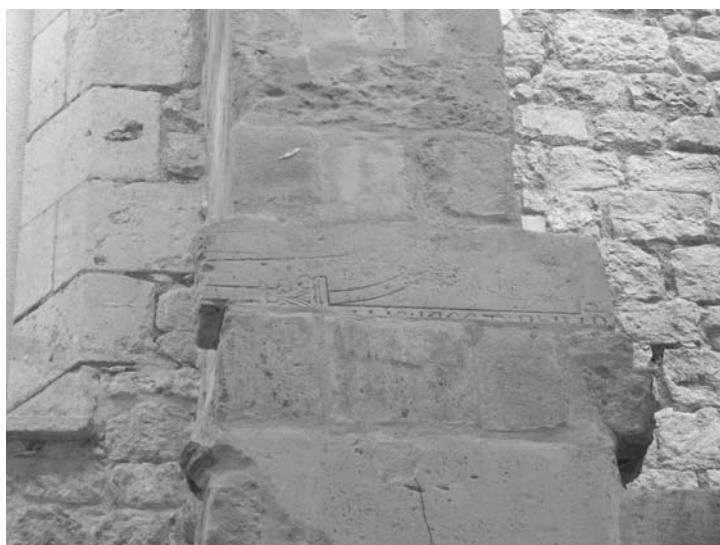
Fragment du centre commercial des Cordeliers
