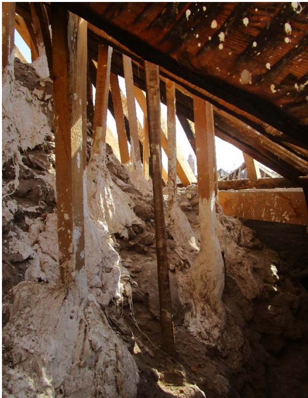
Izquierda. Figura 55. Complejo de al-Muwāssīn. Mezquita. Vista del extradós de una cúpula de mocárabes. Derecha. Figura 56. Complejo de al-Muwāssīn. Mezquita. Vista del extradós de una cúpula de mocárabes con armadura de la cubierta superior.
