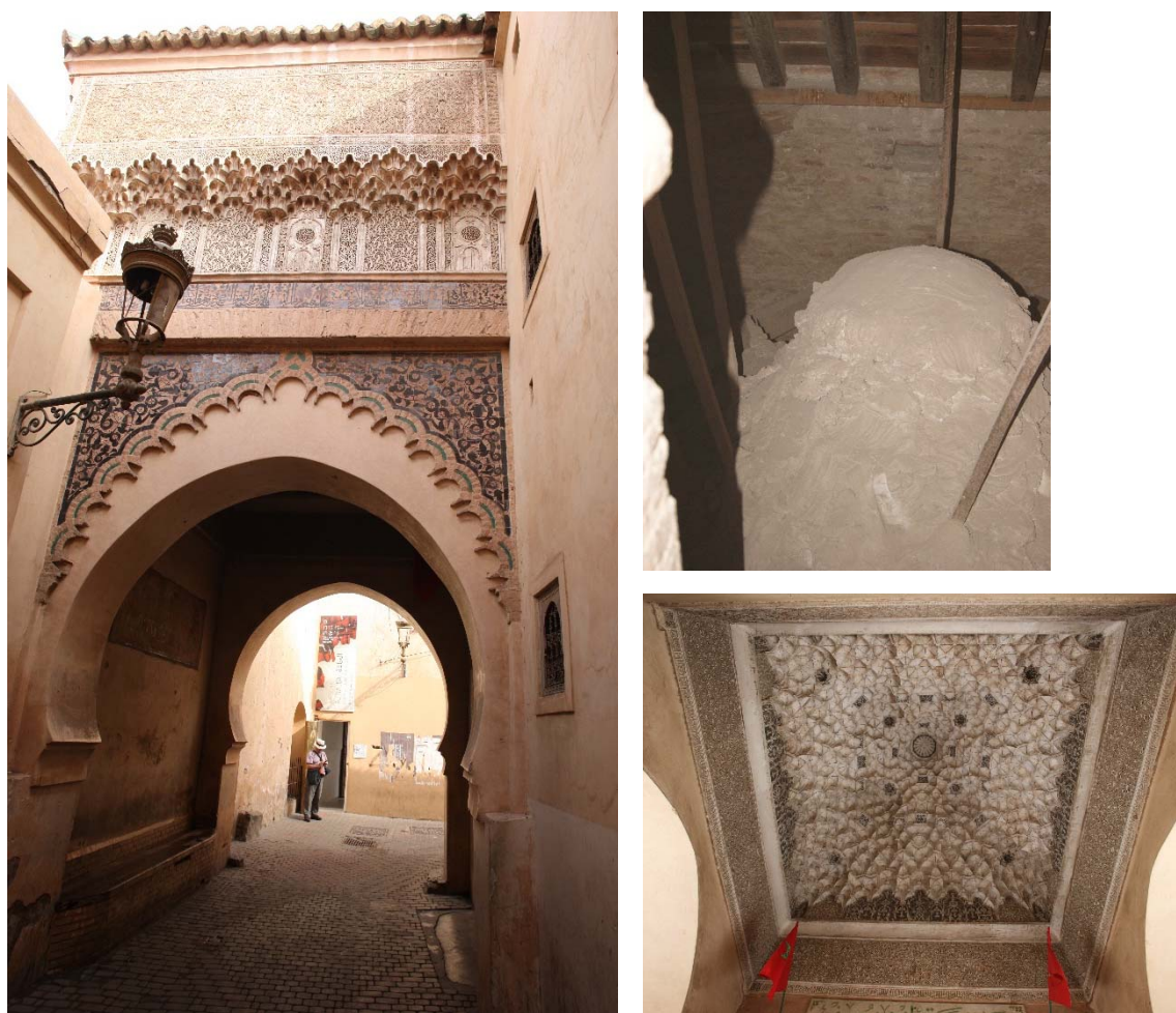
Izquierda. Figura 157 Qubba exterior. Alzado meridional. Abajo a la derecha. Figura 158. Qubba exterior. Cúpula de mocárabes. Arriba a la derecha. Figura 159. Qubba exterior. Cámara sobre la cúpula de mocárabes de yeso.
