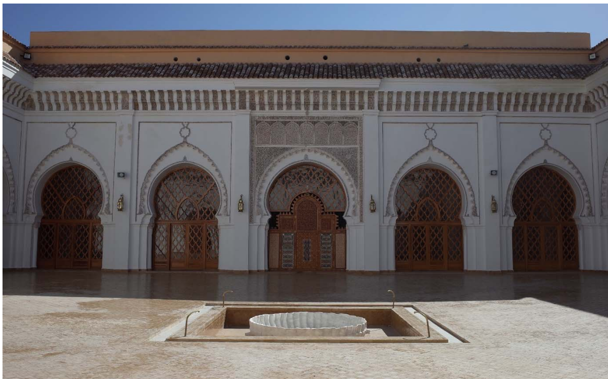
Figura 59. Complejo de al-Muwāssīn. Mezquita. Vista del patio con la taza de mármol en el centro.
