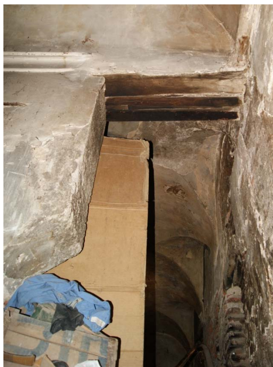
Izquierda. Figura 88. Complejo de al-Muwässīn. Ḥammām . Vista de las bóvedas de arista y la bóveda de espejo relativas a la sala de reposo que quedaron ocultas por la reforma.
