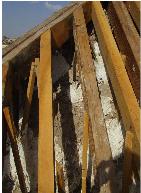
Izquierda. Figura 55. Complejo de al-Muwāssīn. Mezquita. Vista del extradós de una cúpula de mocárabes. Derecha. Figura 56. Complejo de al-Muwāssīn. Mezquita. Vista del extradós de una cúpula de mocárabes con armadura de la cubierta superior.
