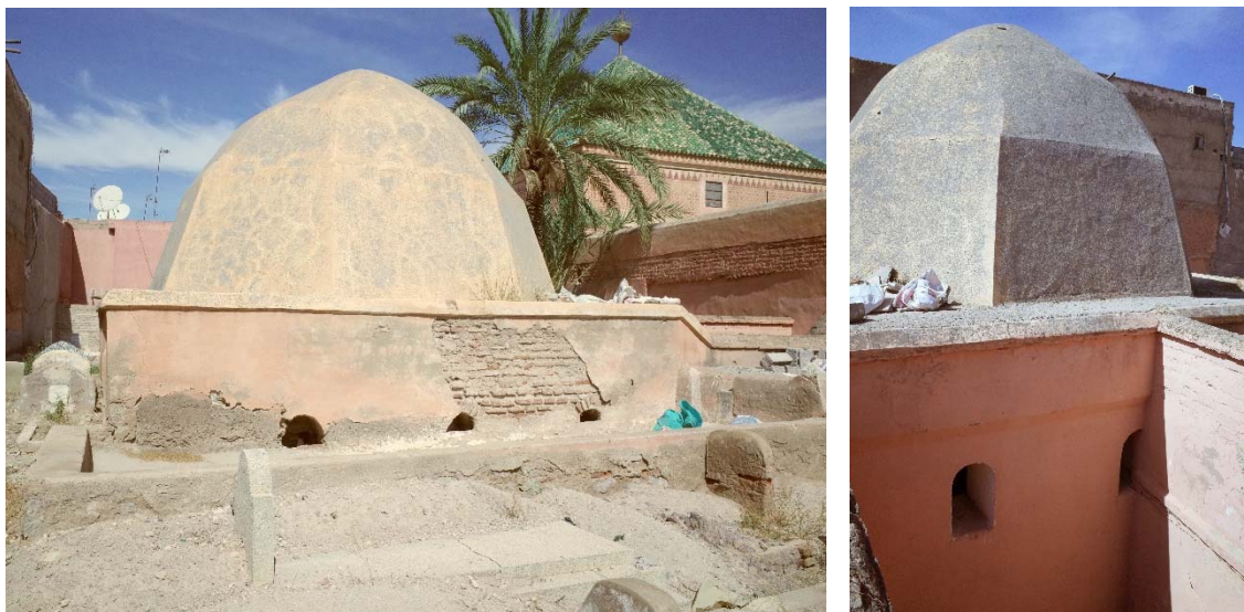
Izquierda. Figura 212. Zawiya de Sīdī al-Ŷazūlī. Vista exterior del mausoleo saadí desde el sur. Derecha. Figura 213. Zawiya de Sīdī al-Ŷazūlī. Vista exterior del mausoleo saadí desde el este.
