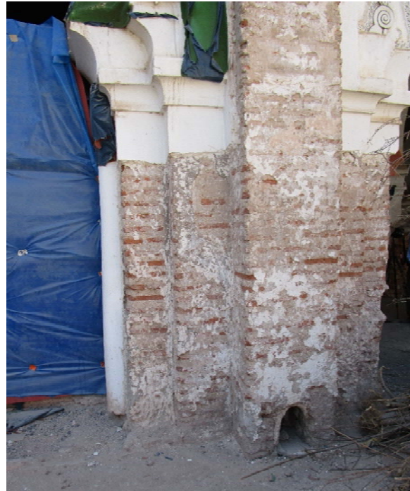
Figura 60. Complejo de al-Muwāssīn. Mezquita. Desagüe de canalón en la parte inferior de las pilastras del patio.
