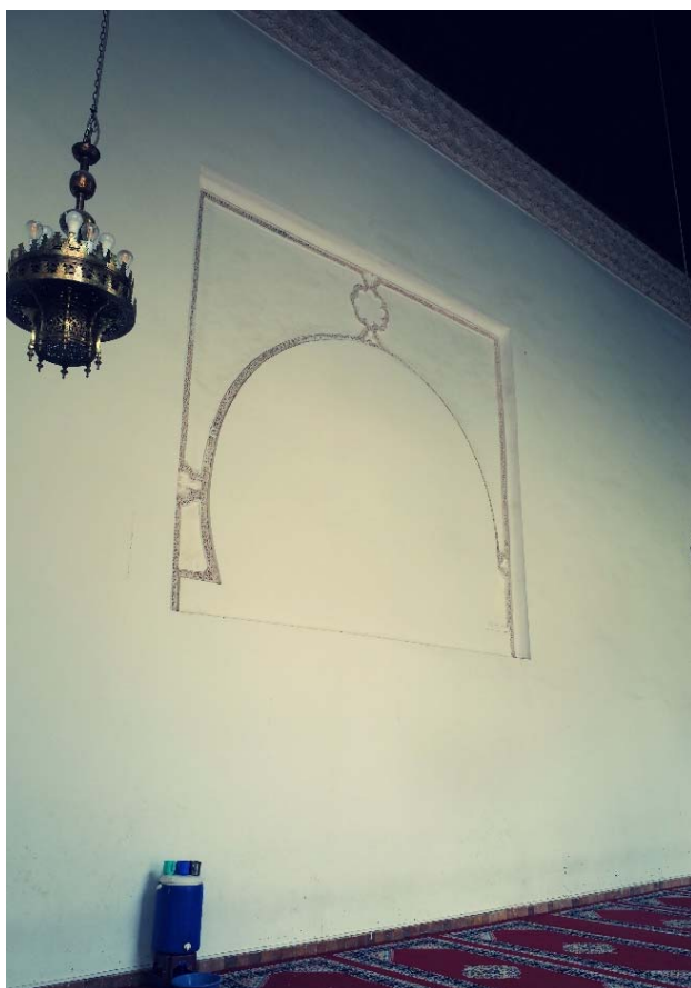
Figura 302. Mezquita de la Qaşba. Puerta cegada en el frente occidental.
