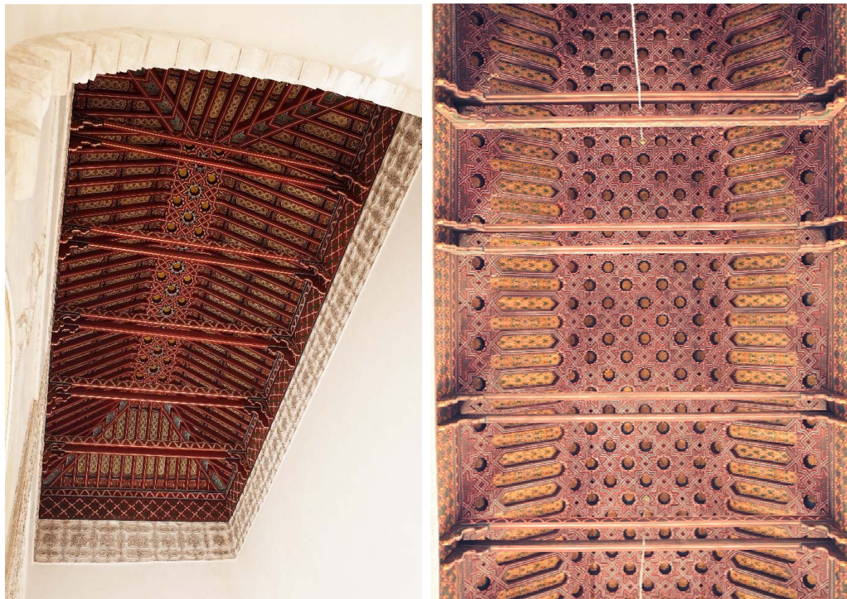
Izquierda. Figura 61. Complejo de al-Muwāssīn. Mezquita. Armadura del pórtico septentrional del patio tras ser repintada. Derecha. Figura 62. Complejo de al-Muwāssīn. Mezquita. Armadura de la nave principal tras ser repintada.
