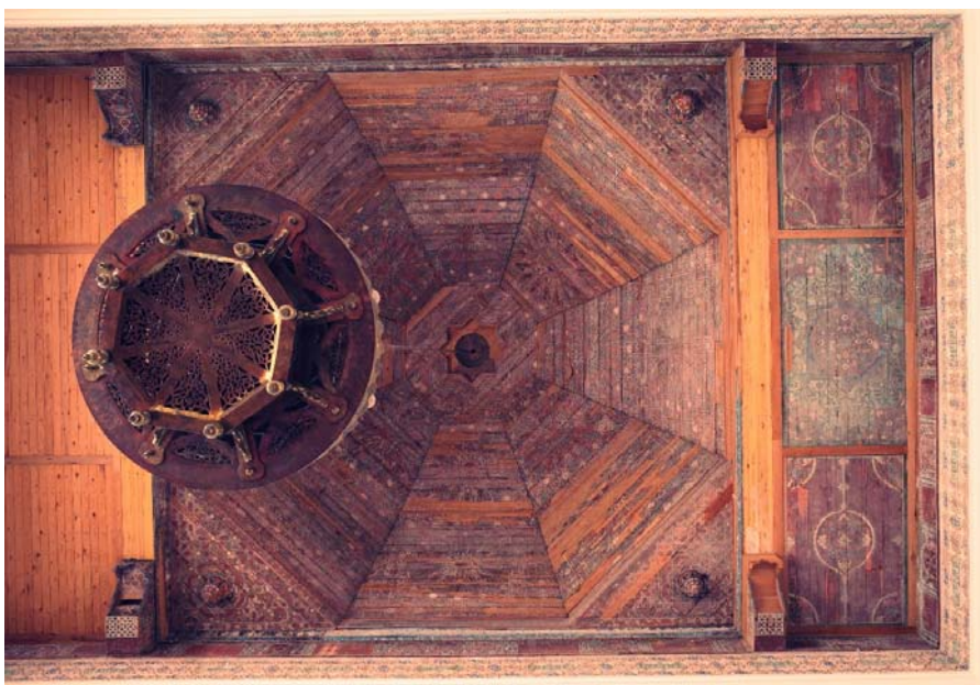
Figura 279. Mezquita de la Qaşba. Vista de la cúpula de madera sobre la nave central.
