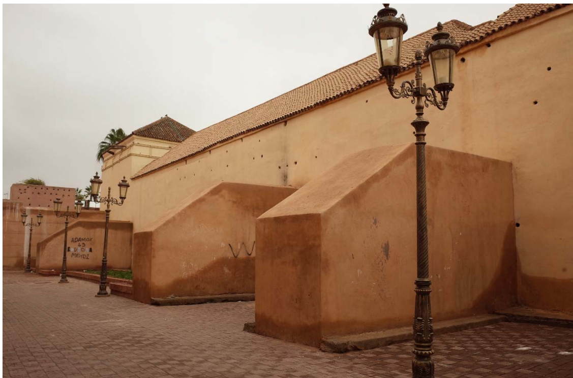
Figura 294. Mezquita de la Qasba. Frente oriental de la mezquita con contrafuertes.
