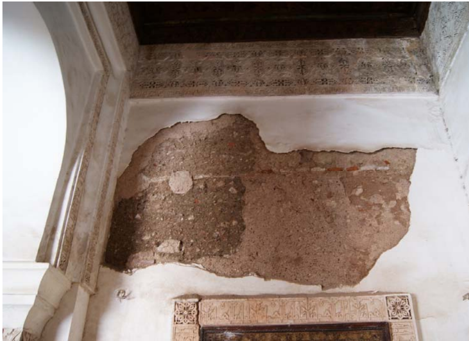
Figura 196. Oratorio. Nave lateral. Vista del muro de tapia original.
