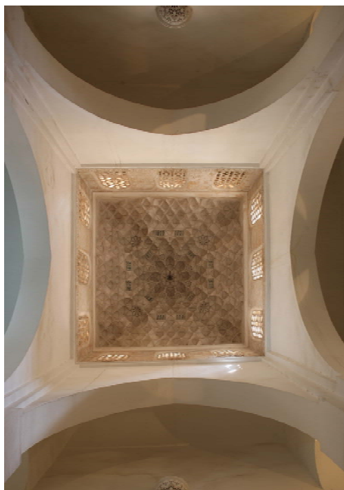
Izquierda. Figura 186. Mīdā'a . Linterna con cúpula de mocárabes.
