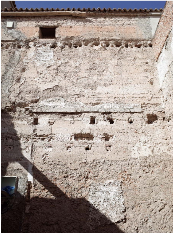
Izquierda. Figura 57. Complejo de al-Muwāssīn. Mezquita. Alzado exterior del muro de la quibla. La ventana superior fue rehecha a una cota más elevada. Derecha. Figura 58. Complejo de al-Muwāssīn. Mezquita. Muro perimetral de la mezquita sin enlucidos visto desde el interior.
