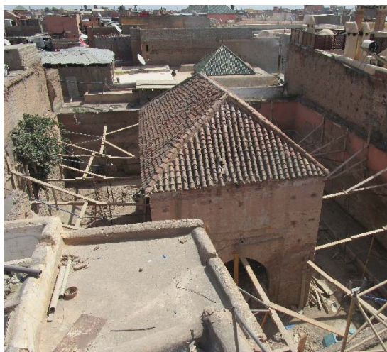
Izquierda. Figura 79. Complejo de al-Muwāssīn. Mīdā'a . Vista superior del pabellón durante la demolición de las crujías perimetrales. Derecha. Figura 80. Complejo de al-Muwāssīn. Mīdā'a . Pabellón central.
