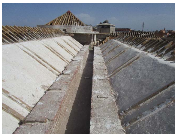
Izquierda. Figura 63. Complejo de al-Muwāssīn. Mezquita. Vista superior de una armadura de la sala de oración. Derecha. Figura 64. Complejo de al-Muwāssīn. Mezquita. Vista superior de un paso entre cubiertas. Las obras de restauración han consolidado las armaduras inferiores y rehecho los muretes que reciben las armaduras superiores.
