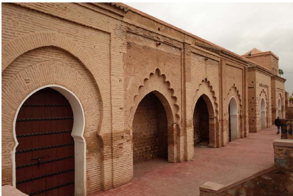
Figura 142. Fachada occidental de la Kutubiyya.
