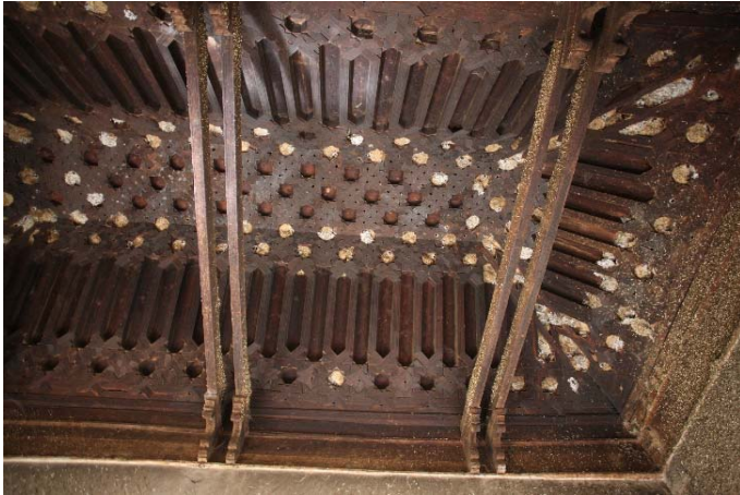
Figura 130. Complejo de Bāb Dukkāla. Mīḍā'a. Carpintería que cubre el pabellón central.
