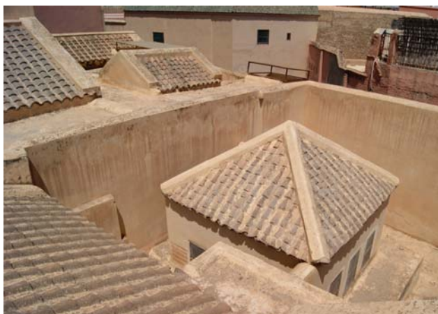
Izquierda. Figura 186. Mīdā'a . Linterna con cúpula de mocárabes.
