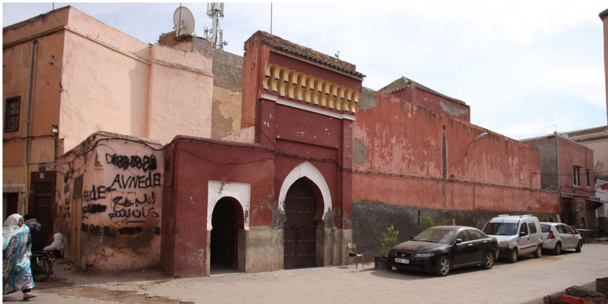
Figura 134. Complejo de Bāb Dukkāla. Baño. Fachada y puertas de acceso.
