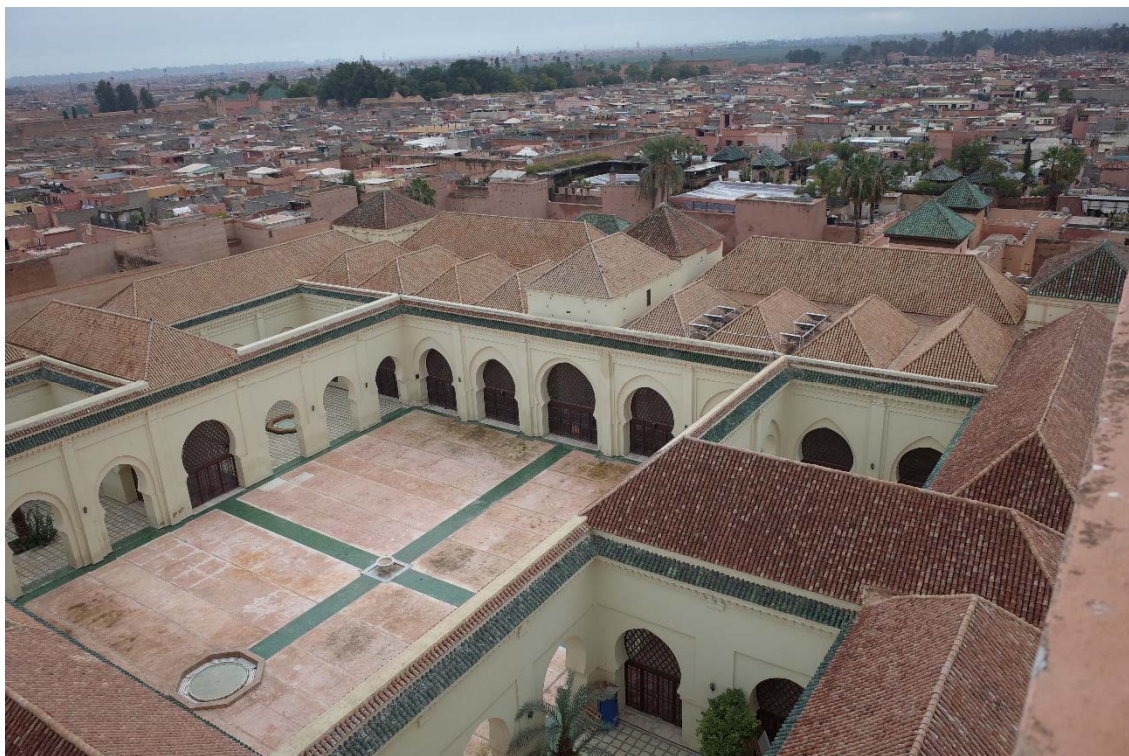
Figura 291. Mezquita de la Qasba. Vista de las cubiertas hacia el sur desde el alminar.
