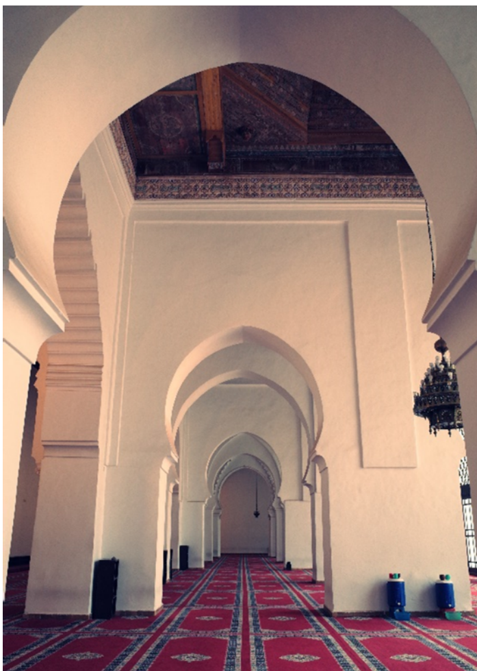
Figura 278. Mezquita de la Qasba. Sala de oración. Secuencia de arcos de distintas tipologías en el primer tramo de las naves y junto a la arquería transversal. En primer plano arquería 6.
