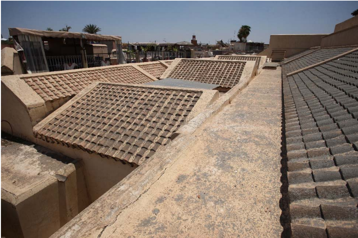
Figura 193. Azotea. A la izquierda, cubiertas de los núcleos residenciales, en el centro, cubierta plana sobre el eje de los corredores, y a la derecha, cubierta de las habitaciones que flanquean el patio principal.
