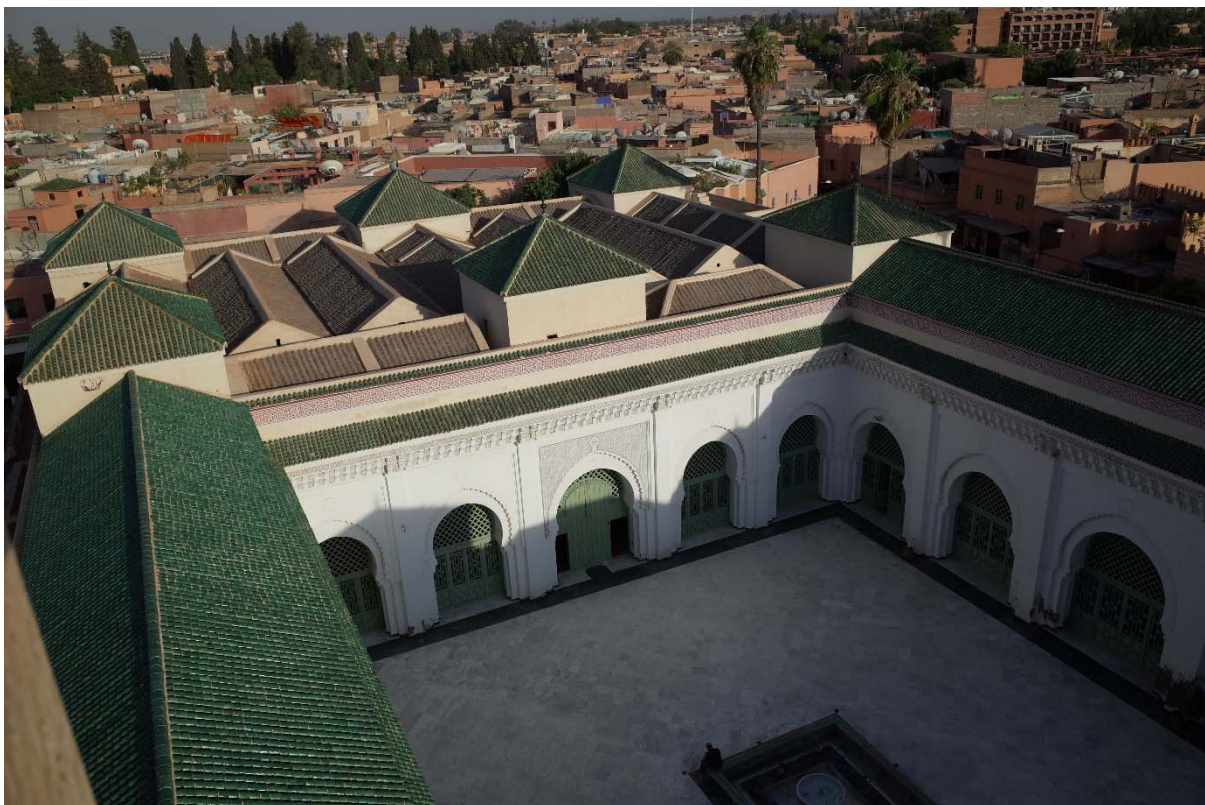
Figura 102. Complejo de Báb Dukkāla. Mezquita. Vista de las cubiertas desde el alminar.
