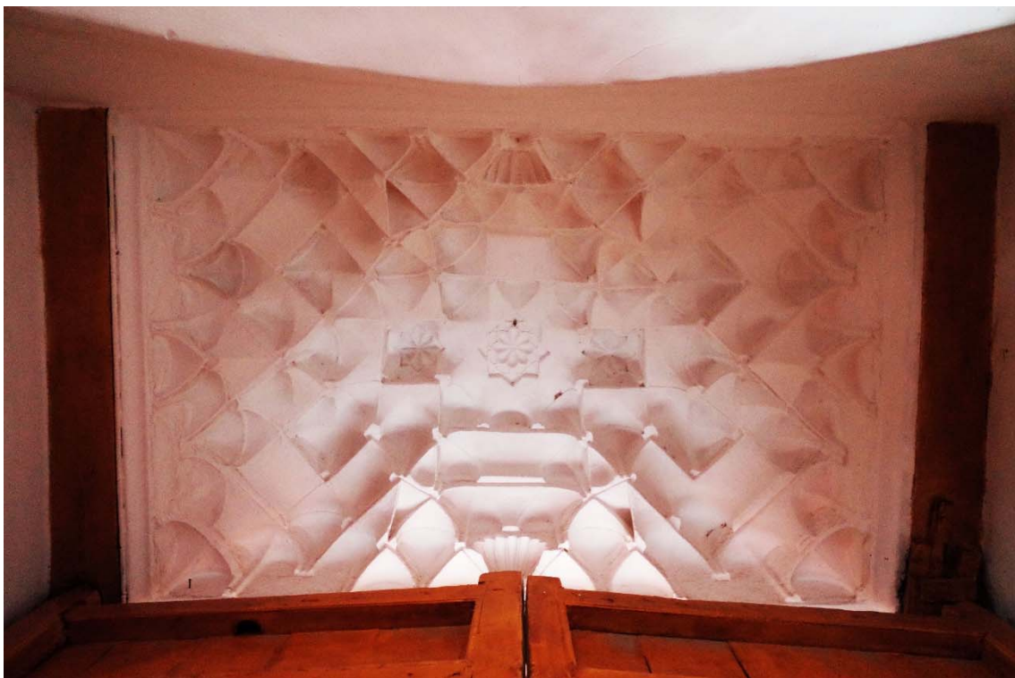
Figura 240. Zawiya de Sīdī Abū al-'Abbās. Cúpula de mocárabes sobre el vestíbulo de la puerta oriental.
