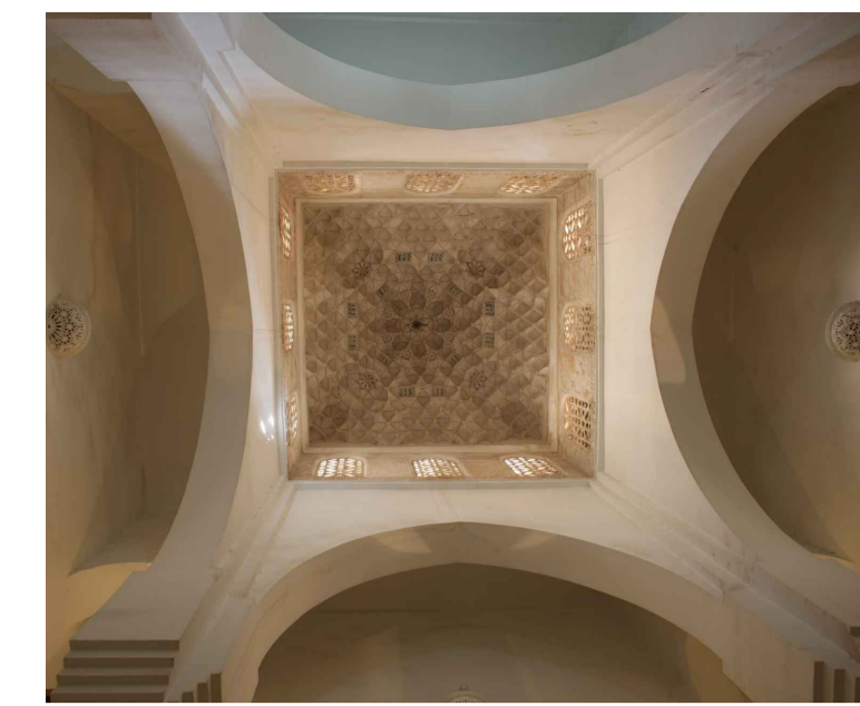
CÚPULA DE MOCÁRABES QUE CUBRE EL ESPACIO CENTRAL DE LA MIDA
