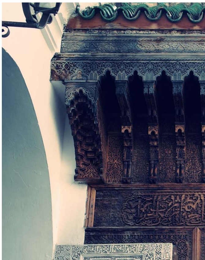
Figura 250. Mezquita al-Qarawiyyīn. Pabellón oriental. Detalle del encuentro del alero con el muro.
