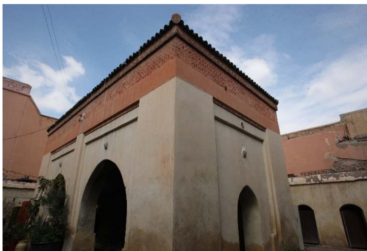
Figura 129. Complejo de Bāb Dukkāla. Mīḍā'a. Vista del pabellón central.
