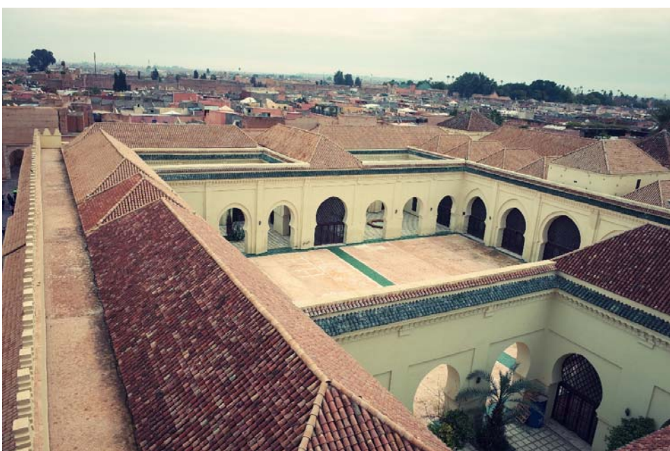
Figura 313. Mezquita de la Qasba. Vista de las cubiertas hacia el este desde el alminar.
