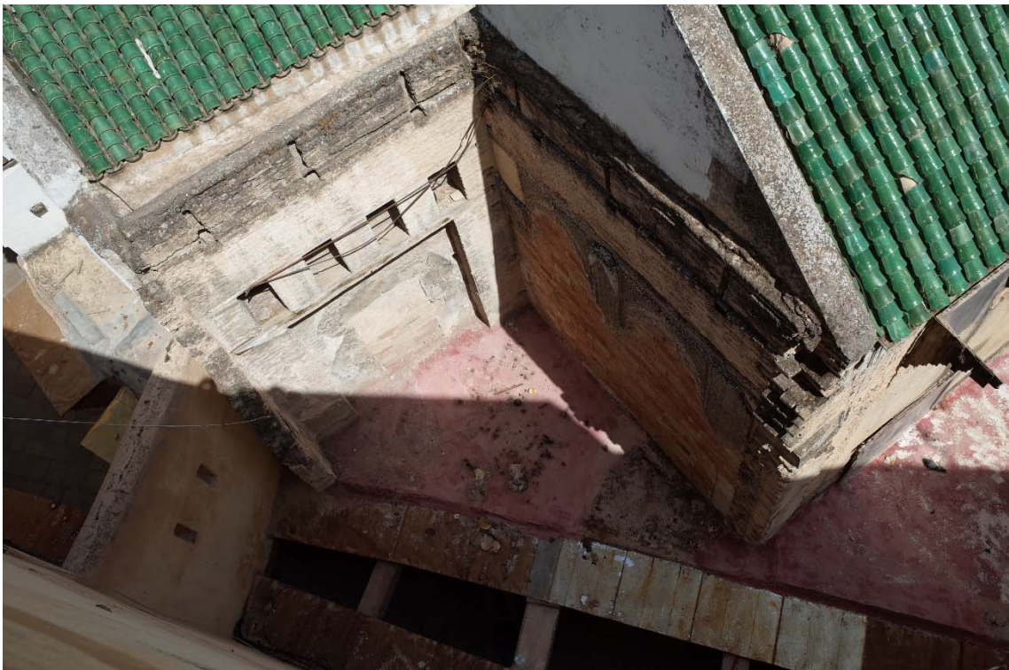
Figura 264. Mezquita al-Qarawiyyīn. Sala de retiro. Vista desde el exterior.
