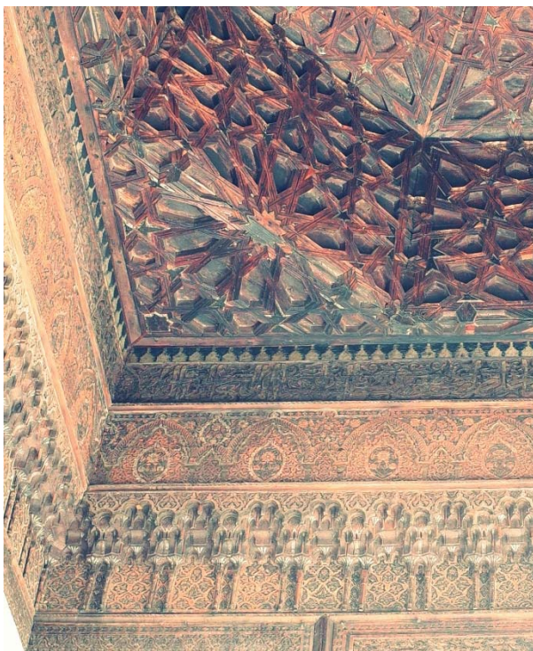
Figura 256. Mezquita al-Qarawiyyīn. Pabellón occidental. Detalle del arrocabe y arranque de los paneles ataujerados del techo.
