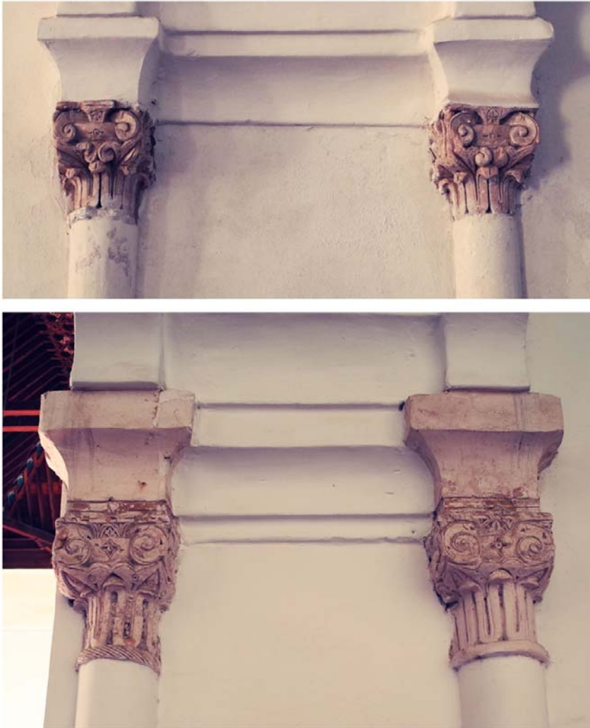
Figura 320. Mezquita de la Qaşba. Parejas de capiteles en los arcos de lambrequines A y P.
