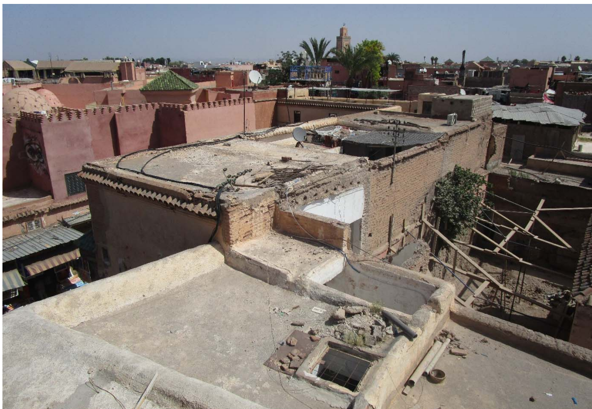
Figura 94. Complejo de al-Muwāssīn. Cuartos altos sobre la fuente-abrevadero.
