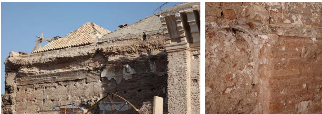
Figura 305. Mezquita de la Qasba. Frente septentrional durante las obras de 2012. Módulos derribados en el extremo oriental y restos de bóvedas (A. Almagro).
