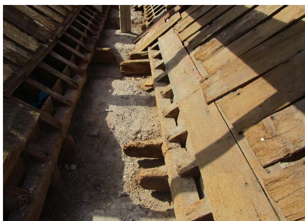
Izquierda. Figura 63. Complejo de al-Muwāssīn. Mezquita. Vista superior de una armadura de la sala de oración. Derecha. Figura 64. Complejo de al-Muwāssīn. Mezquita. Vista superior de un paso entre cubiertas. Las obras de restauración han consolidado las armaduras inferiores y rehecho los muretes que reciben las armaduras superiores.
