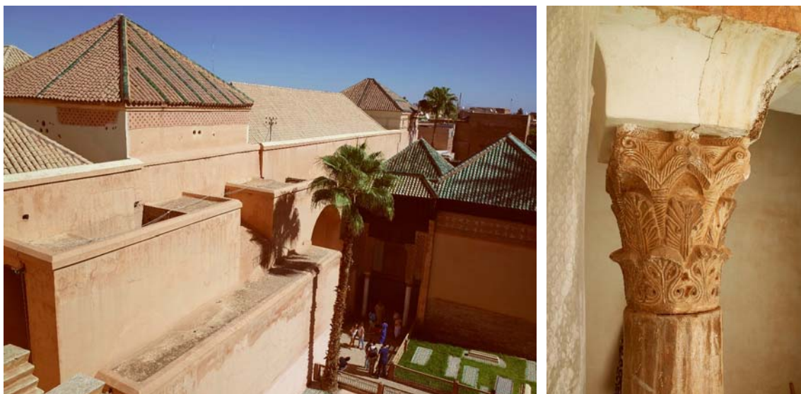
Izquierda. Figura 289. Mezquita de la Qaşba. Vista exterior del mihrab y las salas laterales. Derecha. Figura 290. Mezquita de la Qaşba. Capitel de la península ibérica reutilizado en el pórtico que conecta la mezquita con las Tumbas Saadíes.
