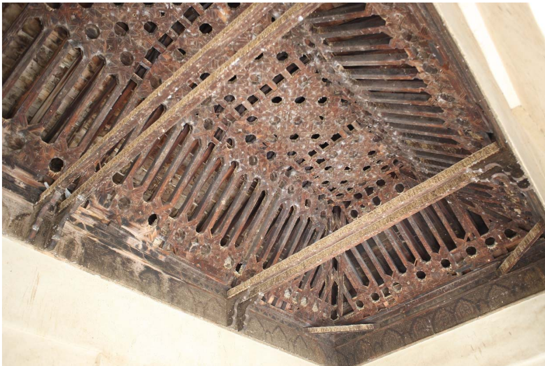
Figura 82. Complejo de al-Muwāssīn. Mīḍā'a . Armadura del pabellón.
