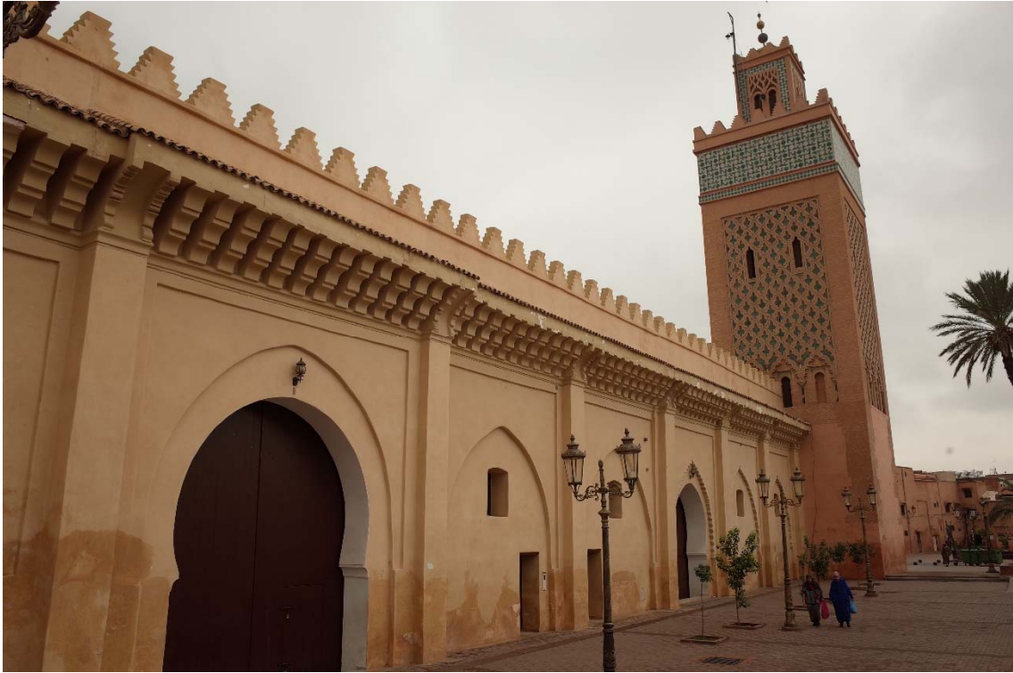
Figura 303. Mezquita de la Qaşba. Fachada septentrional y alminar. En primer plano se halla la puerta principal.
