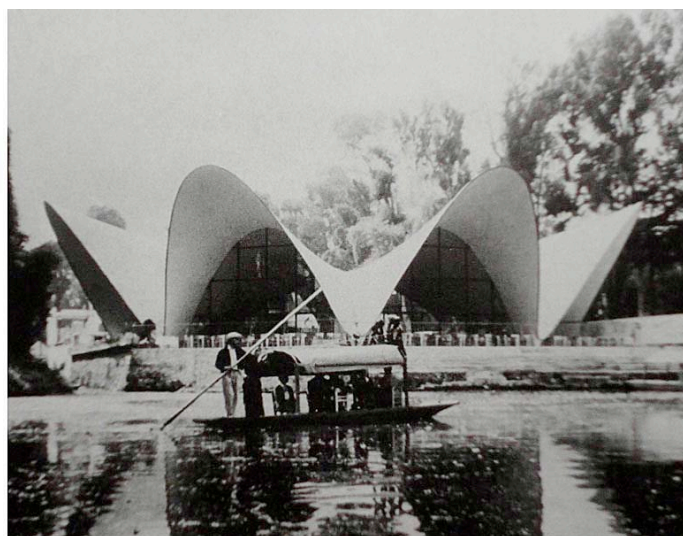
Link 11. Cubierta en forma de paraboloido del restaurante “Los Manatiales” en Xochimilco (México DF), obra de Félix Candela y Joaquín Álvarez Ordóñez, 1957-1958.
