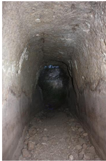
Link 14. Galería en la que se localizó una lumbrera durante su recorrido interior (Almería).
