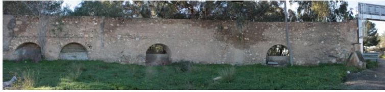
Link 4. Acequia secundaria realizada en altura para mantener el nivel de cota necesario hasta su destino (Huércal de Almería). Nótese que algunos de los arcos de su parte inferior han sido cegados.
