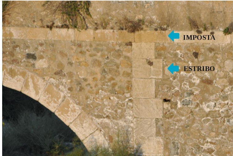
Link 15. Acueducto realizado en mampostería, y sillería localizada en el intradós del arco y jambas del vano central (Almería).
