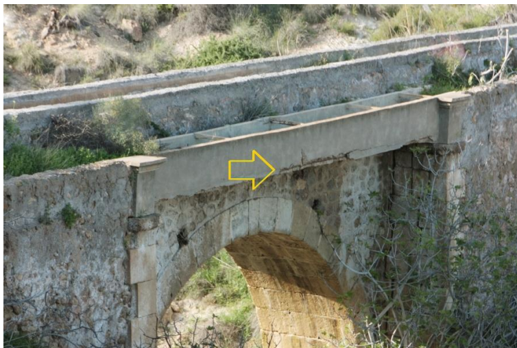
Link 19. Acueducto con canal metálico (Benahadux).
