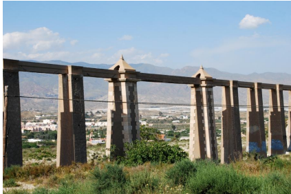
Link 20. Acueducto de Zamarula (Benahadux).
