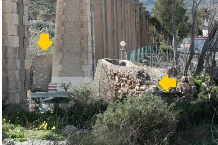
Link 21. Sifón invertido cruzando la carretera de Granada a la misma altura que el acueducto de Zamarula (Benahadux).
