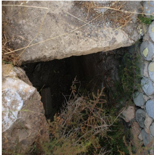
Link 5. Detalle de un canal excavado y cubierto con una losa de piedra labrada (Almería).
