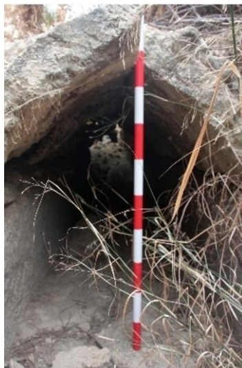
Link 13. Galería con sillería en su parte superior formando una bóveda ojival (Benahadux).
