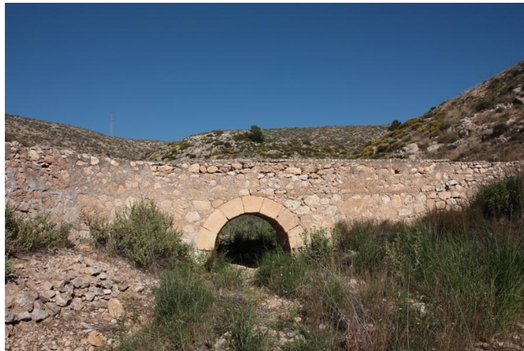
Link 16. Detalle de un acueducto de altura superior a 4,50 m en el que se realizaron elementos constructivos como una línea de imposta y estribos (Benahadux).
