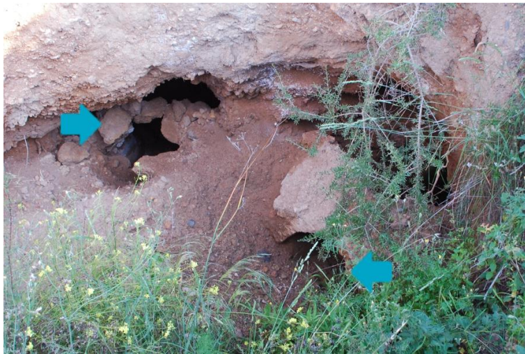
Link 10. Vista cenital de un partidor situado por debajo del nivel del terreno. Actualmente se encuentra derrumbada su parte superior, dejando a la vista las dos galerías (señaladas en la imagen con flechas) en las que se escindía en este punto el Canal de San Indalecio (Huércal de Almería).
