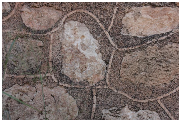
Link 17. Detalle de un muro de mampostería careada en un acueducto, con revestimiento parcial de mortero decorado con un sutil encintado (Almería).
