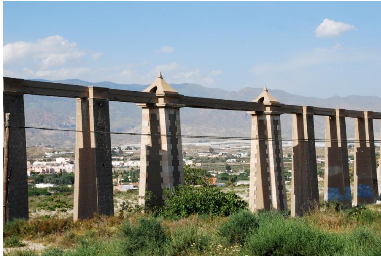
Link 20. Acueducto de Zamarula (Benahadux).
