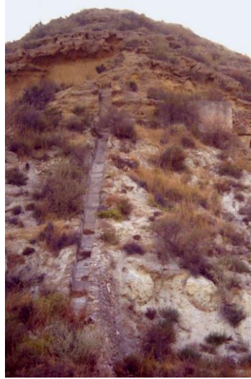
Link 7. Caedero con fuerte pendiente en una acequia secundaria (Huércal de Almería).
