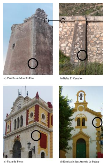
Ilustración 7. Arriba: Localización del cordón y de los sillares de refuerzo en las esquinas en un castillo de la costa almeriense, y su comparación con los mismos elementos en una balsa del Canal de San Indalecio. Abajo: Dos obras del arquitecto Enrique López Rull en las que nuevamente se emplean los realces en las esquinas (Fotografía c: Juan José Hernández Lorenzo; fotografía d: Google Street View).
