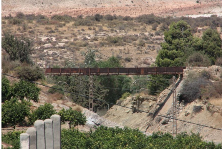
Link 18. Detalle de un acueducto cuyo canal se encuentra realizado en hormigón armado con estructura de hierro (Benahadux).
