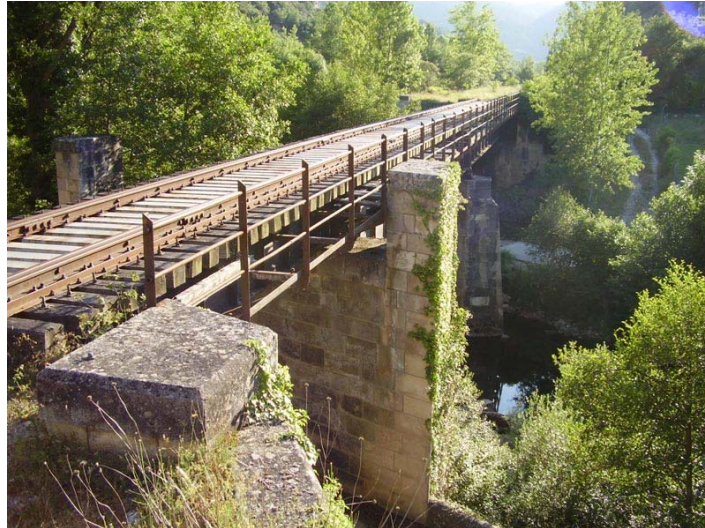
Link 9. Perspectiva lateral del puente de la línea Santander Mediterráneo sobre el río Nela
