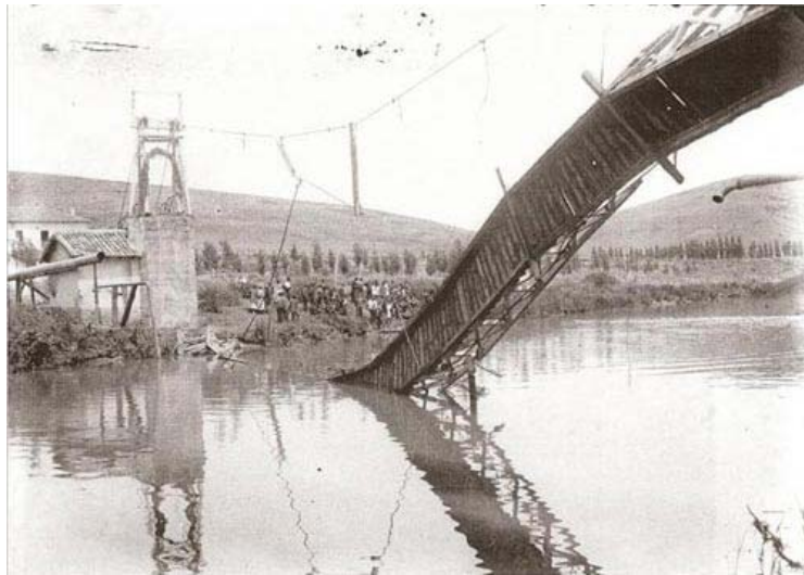
Ilustración 3. Imagen de la pasarela sobre el río Pisuerga tras su colapso en 1927
