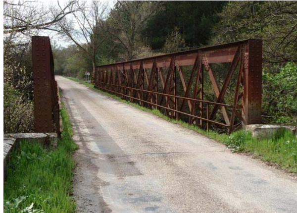
Ilustración 7. Imagen del puente desde la margen derecha del río Arlanza
