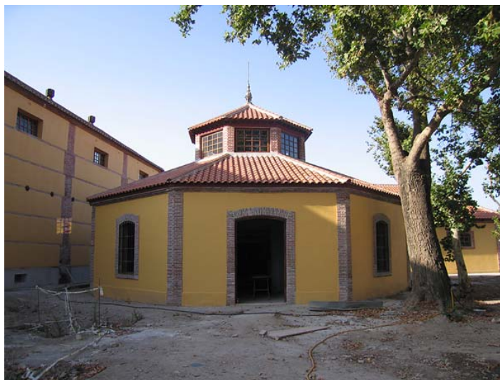
Ilustración 6. Fábrica del Pilar de Motril. Almacén de efectos. Restauración actual
