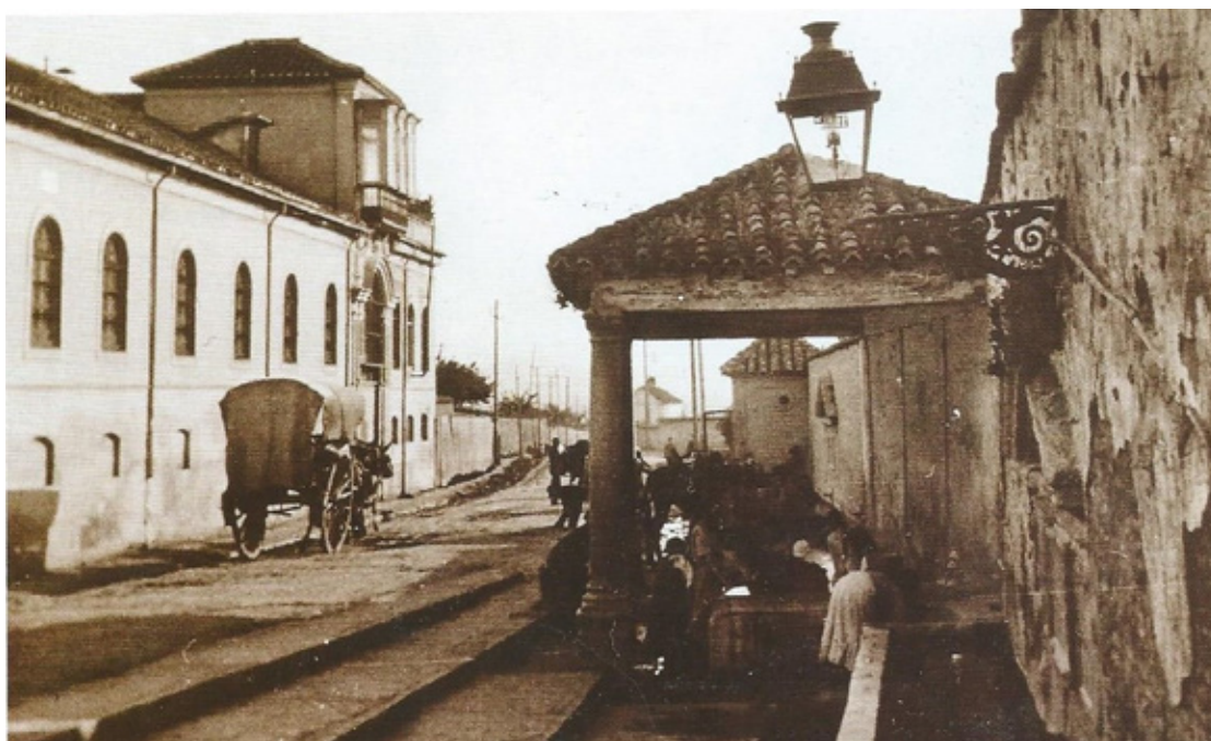
Ilustración 6. Lavadero público de Fuente Nueva y Fábrica de pólvoras El Refino, h. 1890-1900. Autoría desconocida. [Archivo Histórico Municipal del Ayuntamiento de Granada. Fondo fotográfico. Signatura: 00.015.14].
