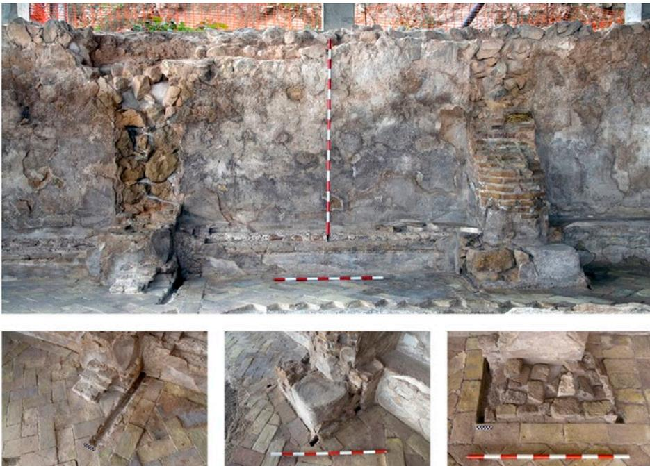
Figura 5. Detalle de las diferentes técnicas constructivas de mampostería, albañilería de ladrillo y elementos de madera.
