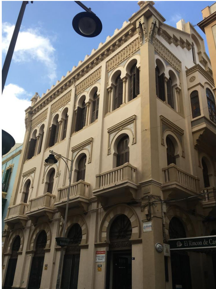
Fachada sur de la Sinagoga Tefilá Or Zaruah. A la derecha de la fotografía apreciamos el pasadizo “David Melul”, donde el mirador que encierra el Hejal sobresale del frente de fachada.
