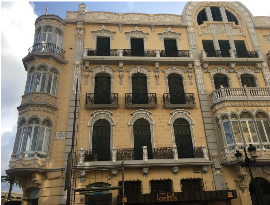
b. Fachada a la Avenida Juan Carlos del Edificio Melul en la actualidad. Elaboración propia.
