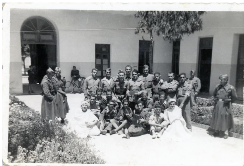
z. La Falange en el interior del Edificio Comunitario.
