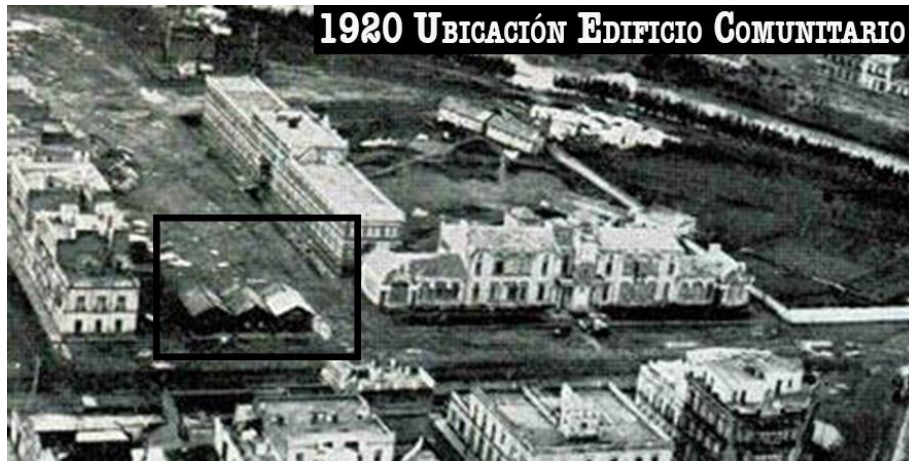
w. Ubicación espacial del Edificio Comunitario, junto al antiguo Hospital de la Cruz Roja.
