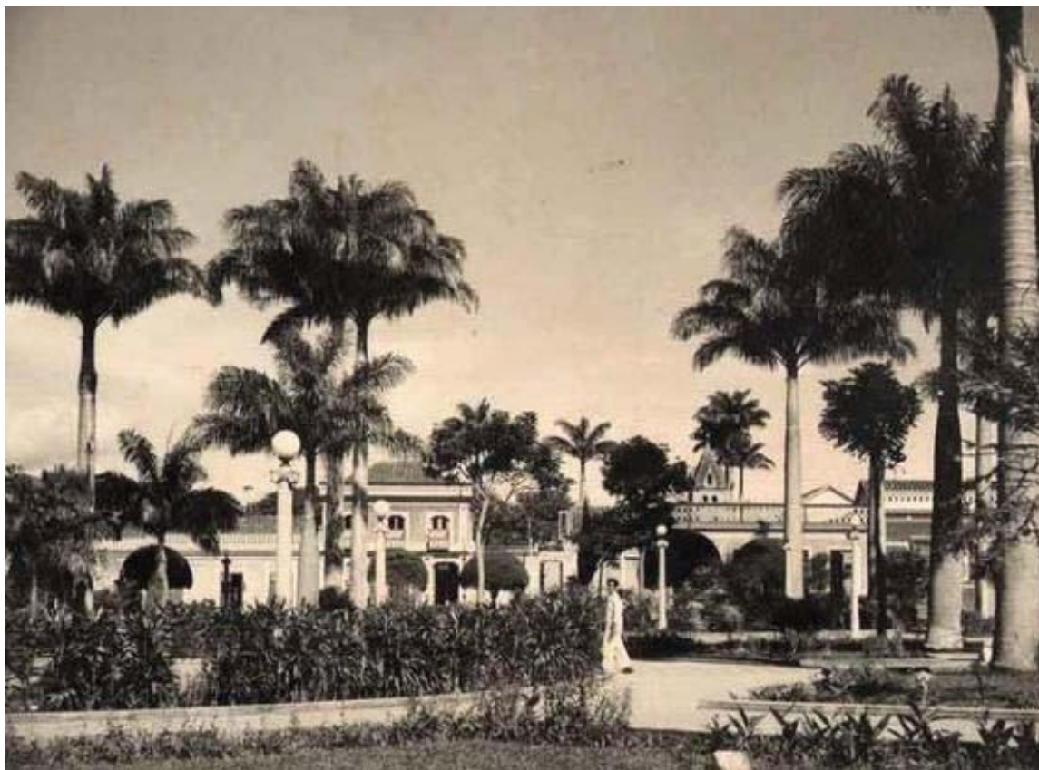
Fig. 147. Vista de la plaza Bolívar, hacia el Este. Ca. 1940.
