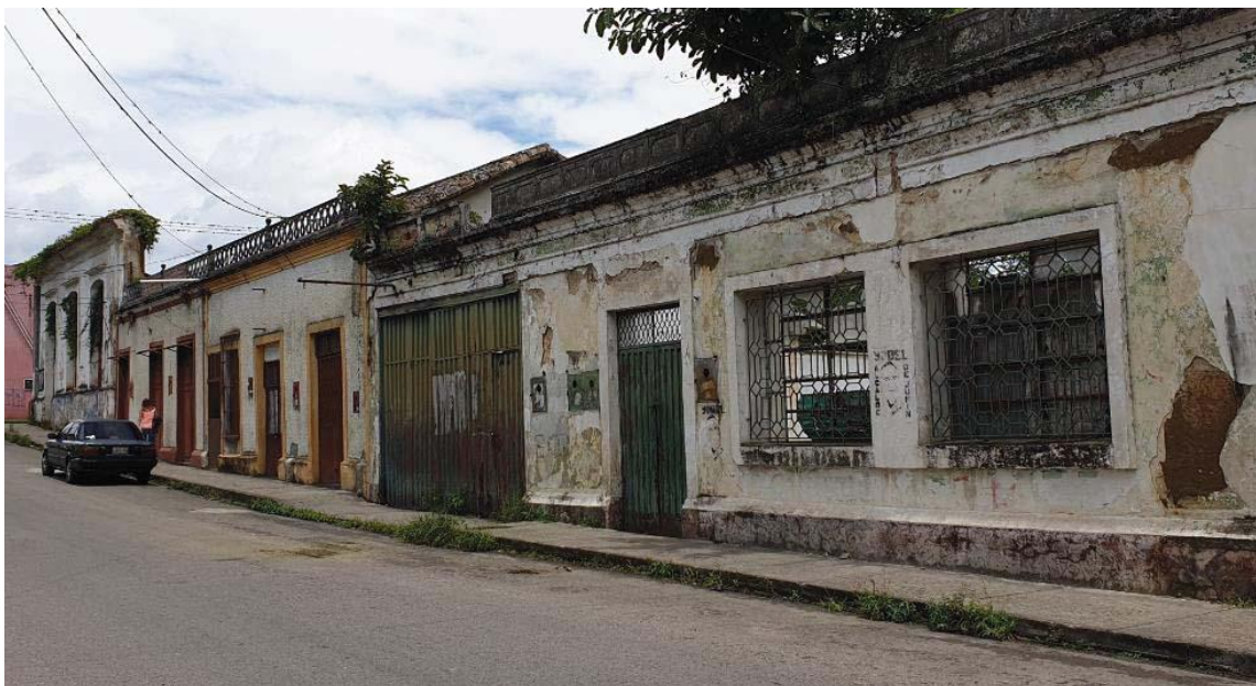
Fig. 1. Fachada Oeste de la avenida 11 entre calles 8 y 9, barrio La Pesa. Casas abandonadas, antes habitadas por familias vinculadas al negocio cafetalero. Fuente: la autora, 2015.
