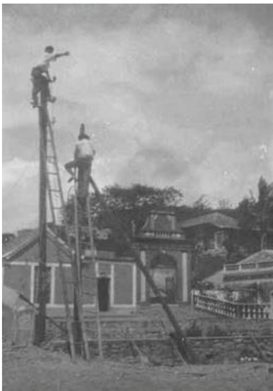
Fig. 77. Primeras instalaciones eléctricas en el sector puente Azul en el barrio La Palmita Fuente: www.desdeRubio.com Descarga 29 de mayo 2018.
