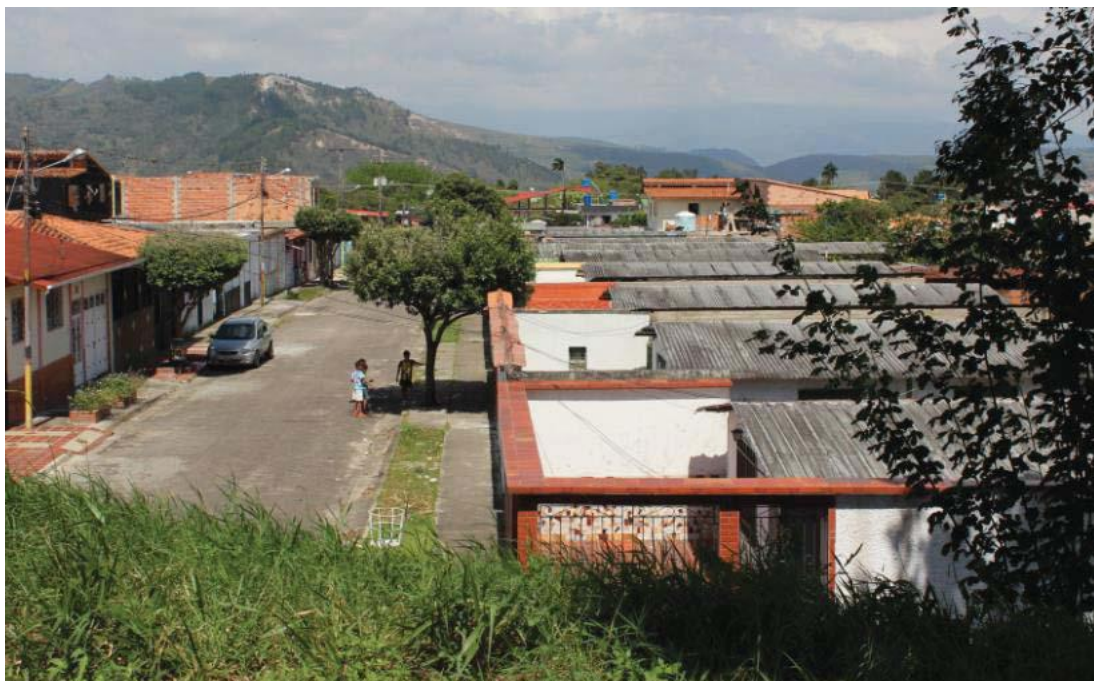
Fig. 114. Casas en serie, del tipo de construcción de vivienda rural, barrio La Azucena, Rubio. Fuente: fotografía de la autora, julio 2018.
