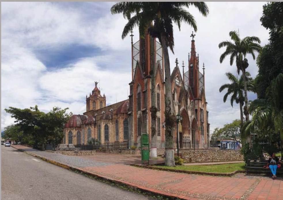
Iglesia Santa Bárbara vista desde el ángulo Noreste. Fuente: fotografía de la autora, 2015
