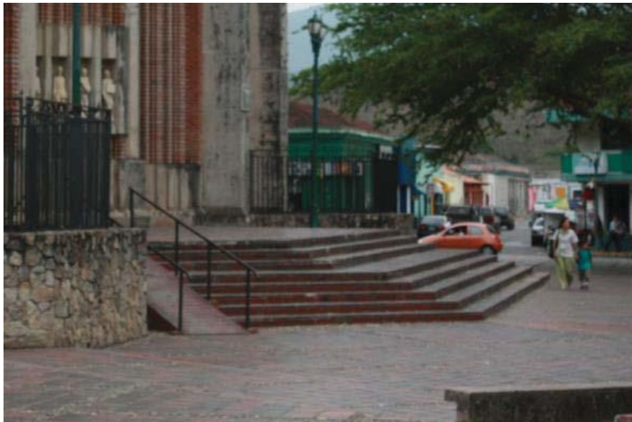
Fig.149. Vista de la escalinata y el espacio que sirve como atrio, en el área que antiguamente ocupaba la calle 11. Fuente: Fotografía de la autora, julio 2015.
