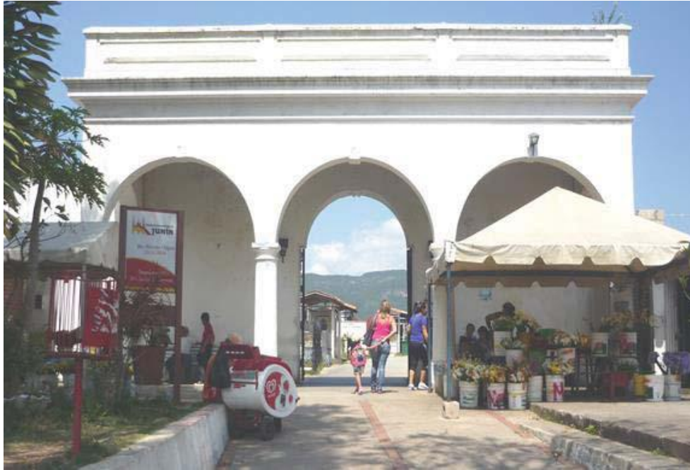
Fig. 160. Portal de acceso al área de enterramientos. Fuente: Álvarez, Gómez, Moncada, Vega y Zambrano. Propuesta de conservación del Cementerio Municipal de Rubio. Archivo de Historia. UNET.
