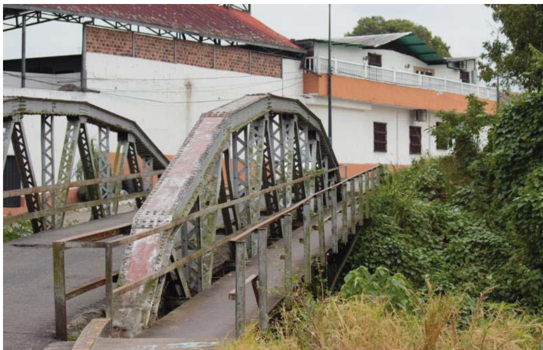
Fig. 57. Puente general Zea, sector Las Termópilas, Rubio. Fuente: fotografía de la autora, agosto 2015.
