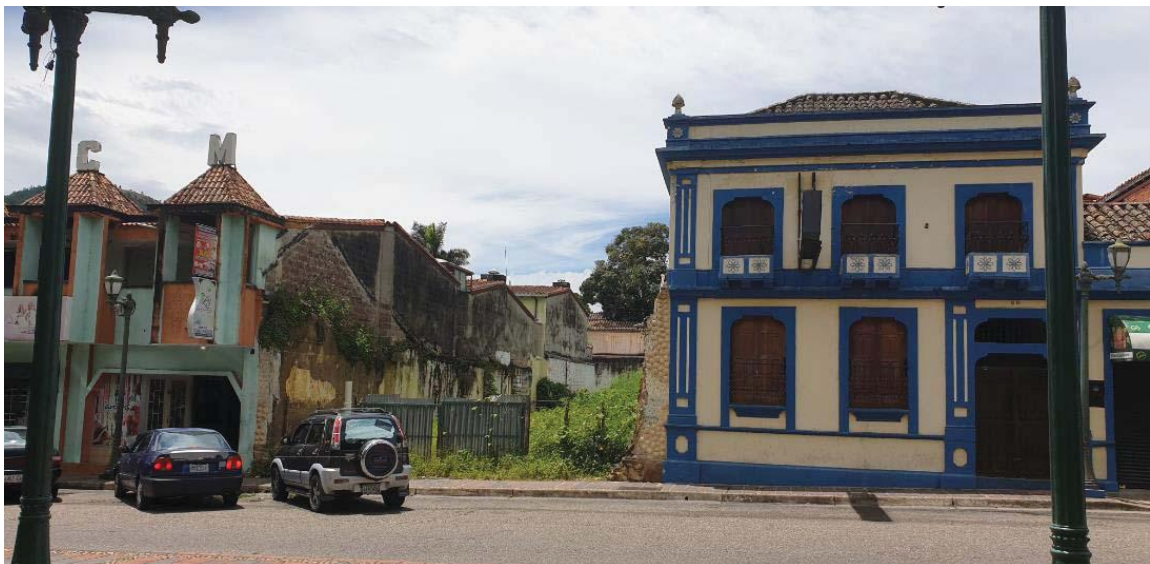
Fig. 5. Fachada Este de la plaza Bolívar. Lote vacío donde antes funcionó una tienda de artesanías tachirenses. Nótese como en el lado izquierdo la propiedad anterior fue sustituida por una nueva construcción de dudosa calidad estética y de formas alejadas al paisaje urbano tradicional, que observamos en la casa de la derecha. Fuente: la autora, 2015.
