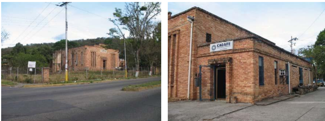
Figs. 79 y 80. Vista general antigua Planta Eléctrica y del costado sur de la edificación. Fuente: fotografías de la autora, julio 2015.
