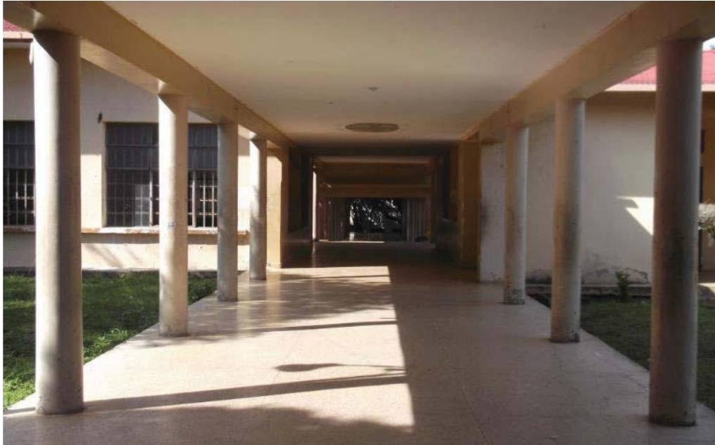
Fig. 181. Pasillos conectores entre edificios de la UPEL. Fuente: fotografía de la autora. Septiembre 2016.
