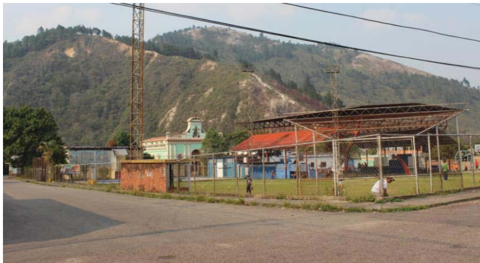
Fig. 144. Instalaciones deportivas del Parque Recreación. Fuente: fotografía de la autora, agosto 2018.
