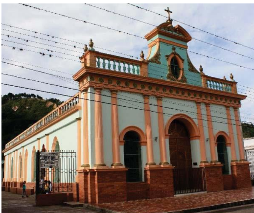
Fig. 25. Capilla Ancianato San Martín de Porres. Fuente: fotografía de la autora, 2015.
