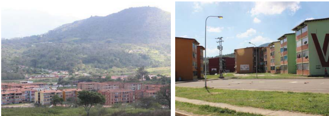
Figs. 123 y 124. La urbanización “La Quiracha” y su modelo tipológico de vivienda multifamiliar en bloques de cuatro pisos. Fuente: fotografía de la autora, julio 2018.
