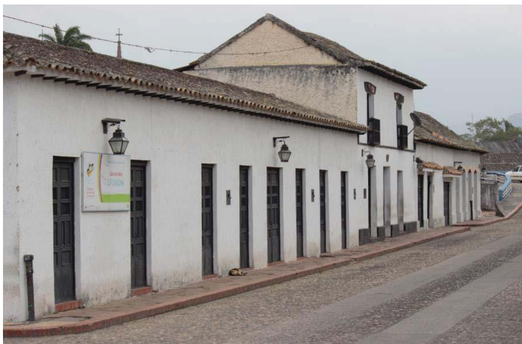
Fig. 205. Fachada Este del área de Los corredores de La Palmita. Fuente: fotografía de la autora, agosto 2017.
