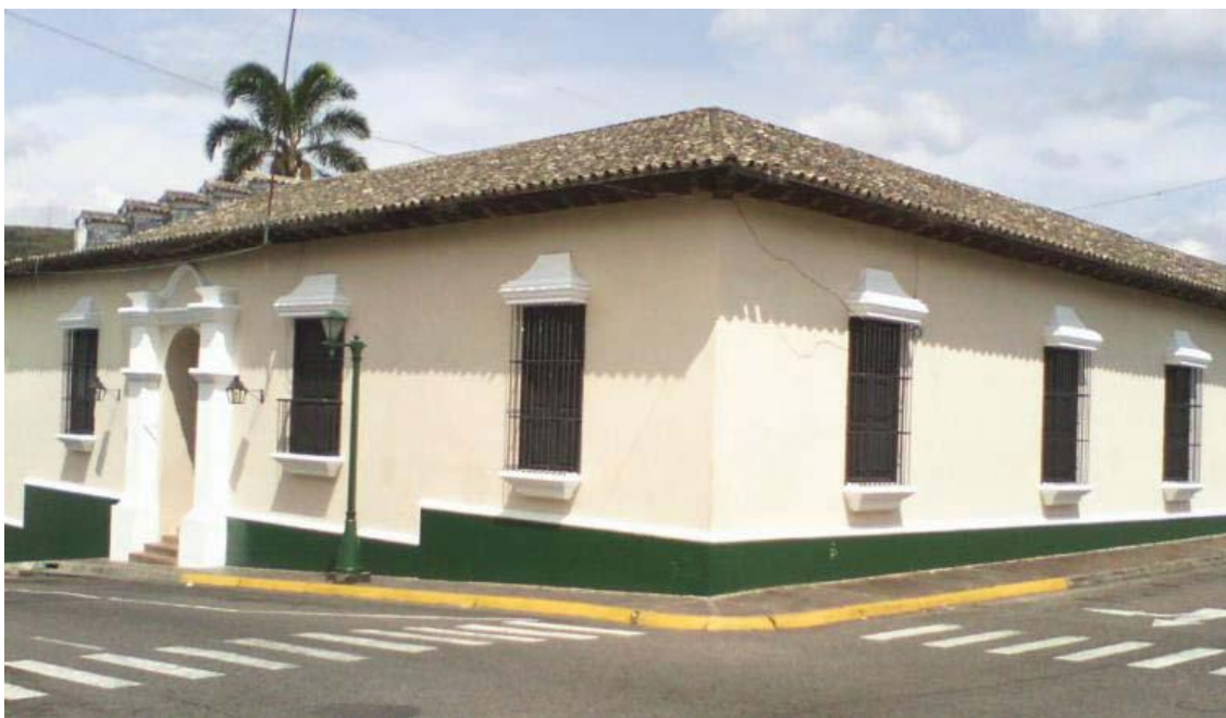
Fig. 174. Alcaldía del municipio Junín, calle 10 con avenida 9. Fuente: fotografía de la autora, agosto 2016.
