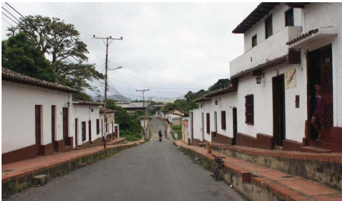
Fig. 158. Perspectiva de la calle principal del barrio La Palmita Fuente: Fotografía de la autora, febrero 2015.
