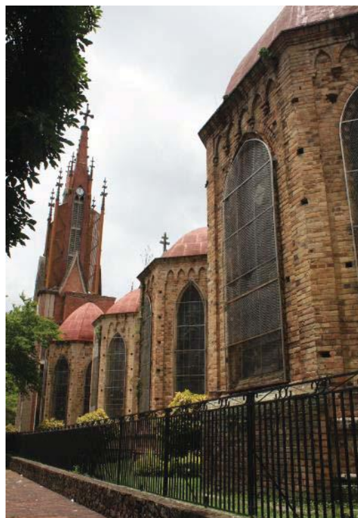
Fig. 194. Vista de fachada Oeste. Fuente: fotografía de la autora, febrero 2015.
