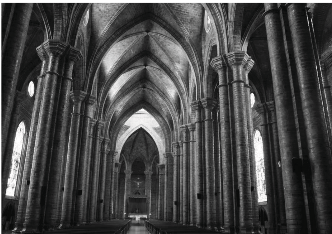
Fig. 195. Nave central y pilares laterales de la iglesia Santa Bárbara Fuente: fotografía de la autora, febrero 2015.
