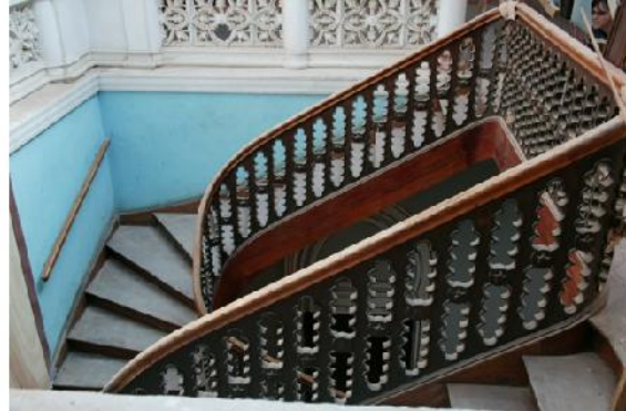
Vista del acceso a la segunda planta
