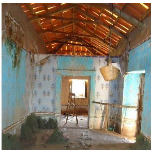
VISTA INTERIOR PLANTA ALTA
