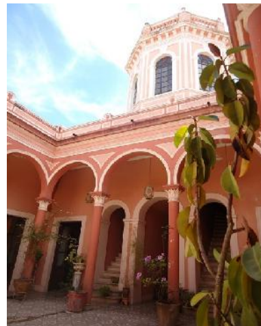
VISTA DE LA TORRE
