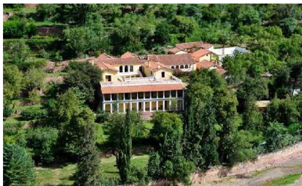
VISTA GENERAL DEL CONJUNTO
