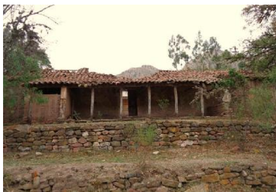
VISTA CORREDOR Y GALERIA POSTERIOR
