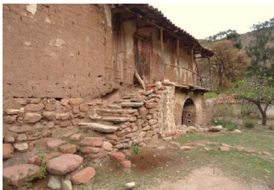
VISTA ESCALERAS PRINCIPALES
