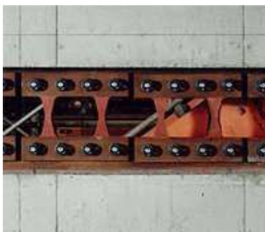
Figura 2.4. Disipador tipo HDS de la empresa Kajima Corporation instalado en muro de hormigón. Fuente: http://www.kobori-takken.co.jp
