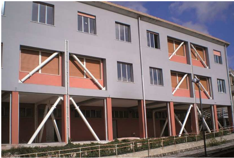
Figura 2.8. Disipador BRAD de la casa comercial FIP Industriale instalado en la fachada de un edificio de estructura porticada. Fuente: https://www.archiproducts.com/es
