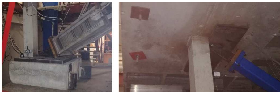
Figura 4.25. Anclaje de disipadores a la estructura. Izq.: Disipador C1 anclado a la base de P1. Der.: Disipador C3 anclado al ábaco de P2.
