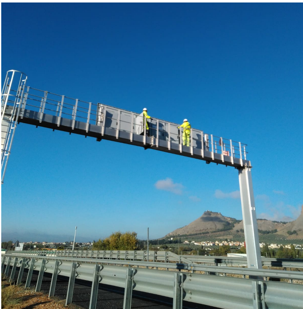
Figura 5.41 Emplazamiento de un nodo de monitorización en carretera por parte del personal de la DGT.
