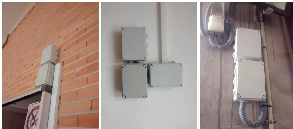
Figura 5.37 Instalación de los nodos de monitorización en interiores, empleando cajas estancas ubicadas cerca de otras cajas similares para camuflarlas.
