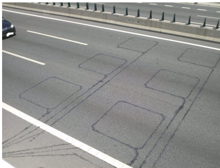
Figura 3.9 Fotografía de seis bobinas de inducción magnética o espiras instaladas bajo la calzada. Fuente: NOSMAN, Chubastrah.net.
