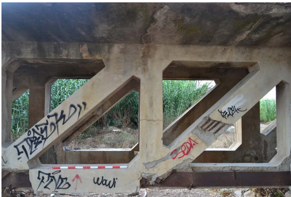
Figura 10. Elementos de la estructura del puente, visibles por los desperfectos. Fotografía del autor.
