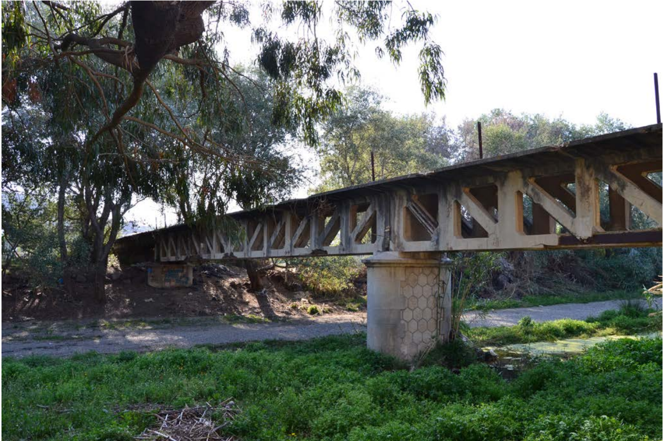
Figura 11. El puente sobre el río Vélez en la actualidad. Se encuentra en avanzado estado de deterioro y en peligro de desaparición. Fotografía del autor.
