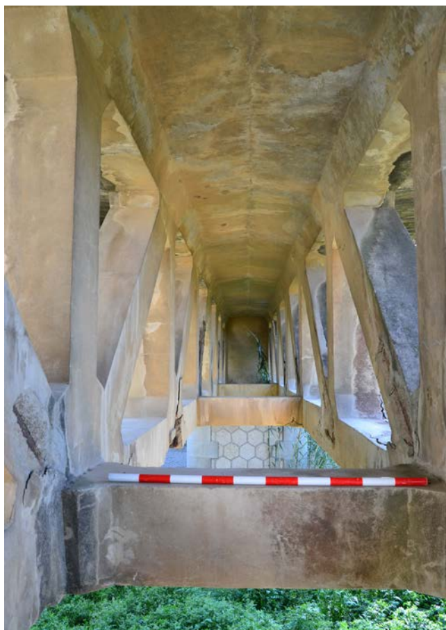
Figura 8. Riostras inferiores de unión de los cuchillos. Fotografía del autor.
