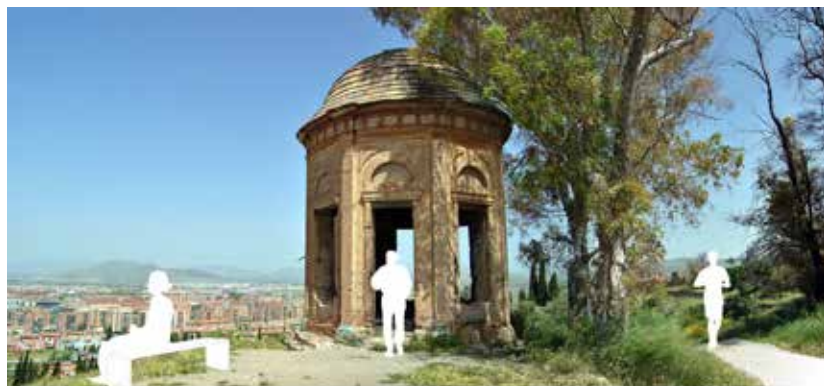
Fig. 3. Templete mirador, en torno al que se propone una nueva zona de esparcimiento.
