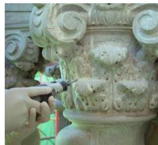
Figura 3. Proceso de limpieza de la Portada de la Facultad de derecho. Eliminación de suciedad y cementos mediante microtorno.
