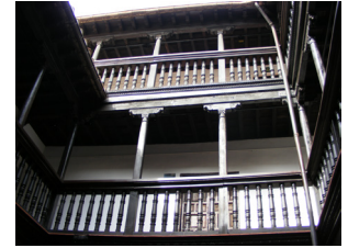
Figura 12. Patio interior de la casa. En la imagen se observa la galería añadida como consecuencia de la reforma de inicios del siglo XVII llevada a cabo por Ana de Contreras y Miguel Porras. La intervención aumentó la altura del edificio y lo dotó de vistas a la Alhambra. Fotografía de M a Encarnación Hernández López.
