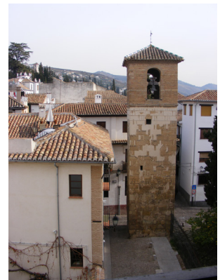
Figura 4. Alminar-campanario de la iglesia de San José visto desde el balcón principal de la casa de Leonor Manrique. En la imagen se puede observar la cercanía de ambas construcciones. Fotografía de M a Encarnación Hernández López.
