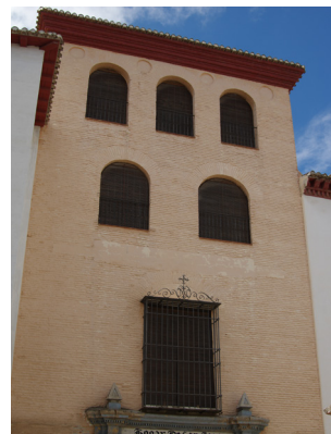
Figura 5. Fachada principal de la casa. Fotografía de M a Encarnación Hernández López.
