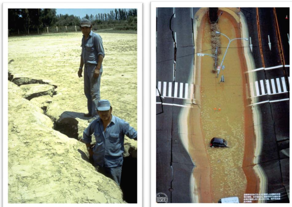
Fig. 75.- Izquierda: grieta causada por licuefacción inducida por el sismo de Caucete (Argentina) el 23 de Noviembre de 1977 –  $M=7,4$ - (Bertero y Vitelmo). Derecha: daños causados por licuefacción y flujo lateral en una red viaria de Kobe (Japón) durante el terremoto del 17 de Enero de 1995 –  $M=6,9$ - (Clark, 1995)
