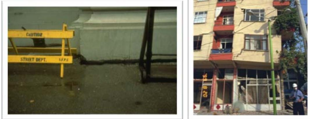
**Fig. 65.- Daños causados por densificación. Izquierda: Pequeño asiento inducido durante el terremoto de Loma Prieta, California el 17 de Octubre de 1989 –  $M=7,09$ - (Seed, 1989). Derecha: Asiento diferencial en un bloque de viviendas inducido por el terremoto de Izmit, Turquía el 17 de Agosto de 1999 – $M=7,4$ - (Sezen, H)**
