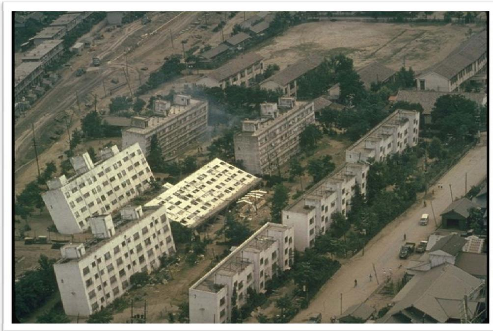
Fig. 74.- Vuelco de bloques de viviendas por la licuación del substrato, inducida por el sismo de Niigata (Japón) el 16 de Junio de 1964 –  $M=7,4$ - (Penzien 1964)
