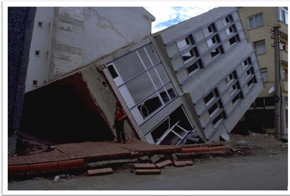
Fig. 76.- Vuelco de un bloque de viviendas por la licuación del suelo inducida por el terremoto de Izmit, Turquía el 17 de Agosto de 1999 –M=7,4- (Elwood, 1999)
