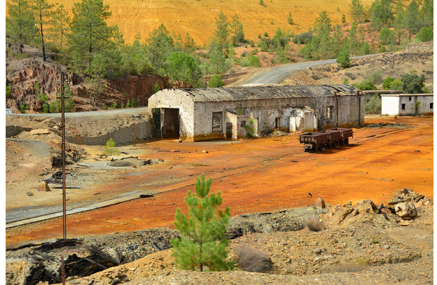
Imagen 142: Instalaciones auxiliares del antiguo ferrocarril minero visibles desde el nuevo ferrocarril turístico. Autoría propia.
