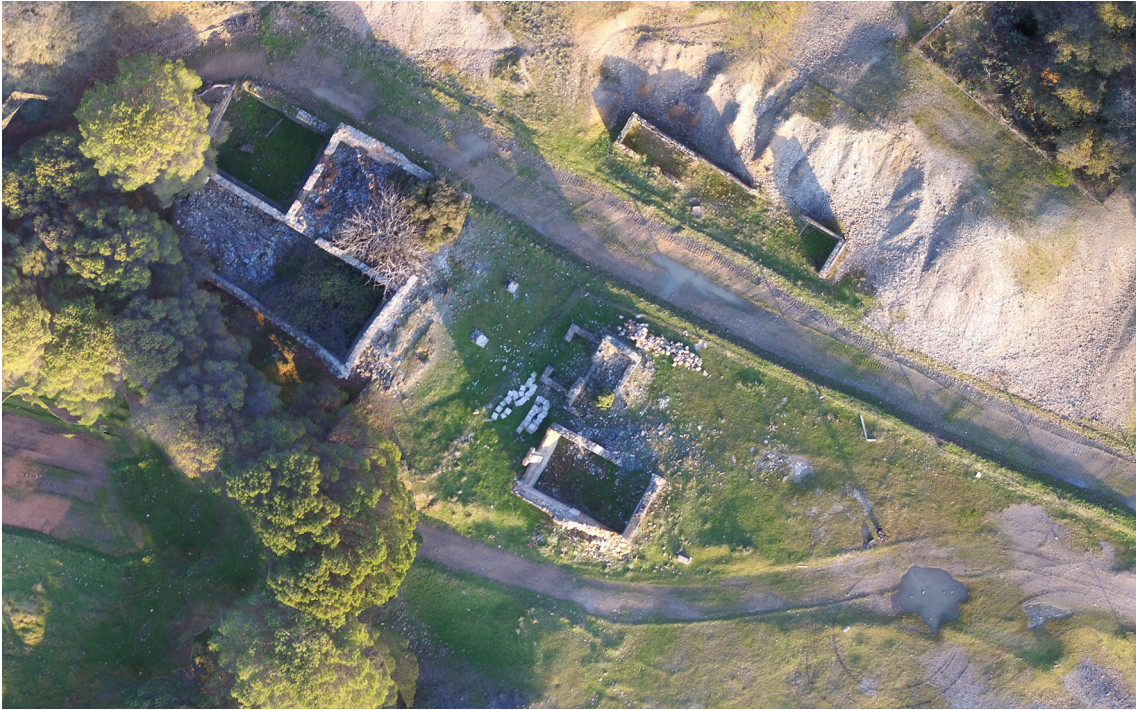
Imagen 336: Vista aérea de la mina El Águila obtenida con Phantom Drone II – Fuente: AJRU.
