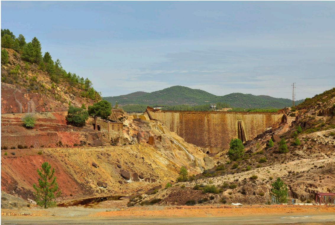
Imagen 123: Salida del túnel 16 de Corta Atalaya al entorno de Talleres Mina. Este túnel, igual que ocurre con la galería Santa María es un elemento auxiliar de trabajo en la corta. Debido a las dimensiones de esta es casi imperceptible a la vista en la imagen anterior. Autoría propia.
