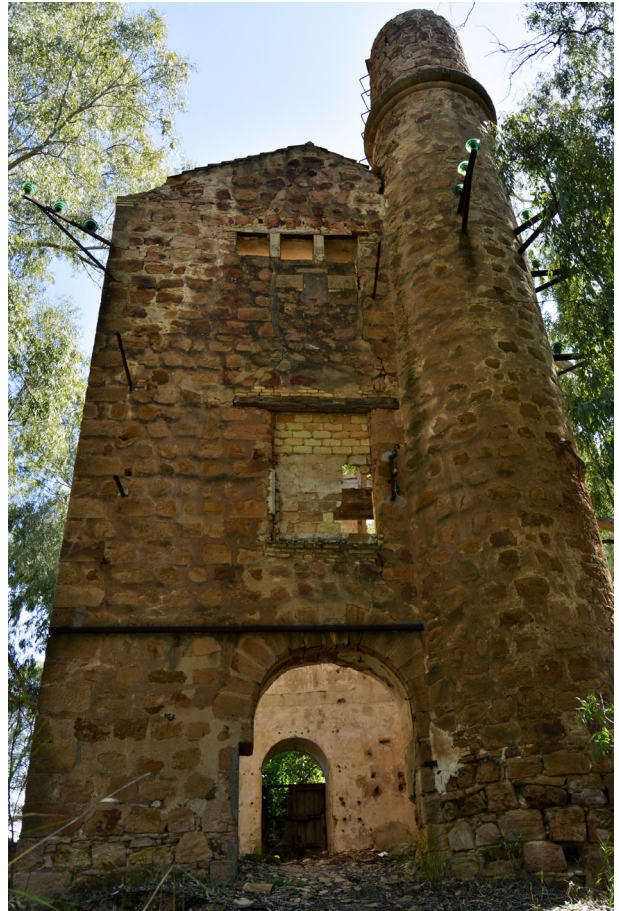
Imagen 172: Casa Cornish de San Antonio de Las Cadenas. Un ejemplo de esta tipología que cuenta con la chimenea adosada a la fachada principal. Autoría propia.
