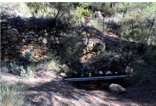
Imagen 33: Cubierta de seguridad instalada sobre un pozo vertical existente en las inmediaciones de la mina La Memoria. Autoría propia.
