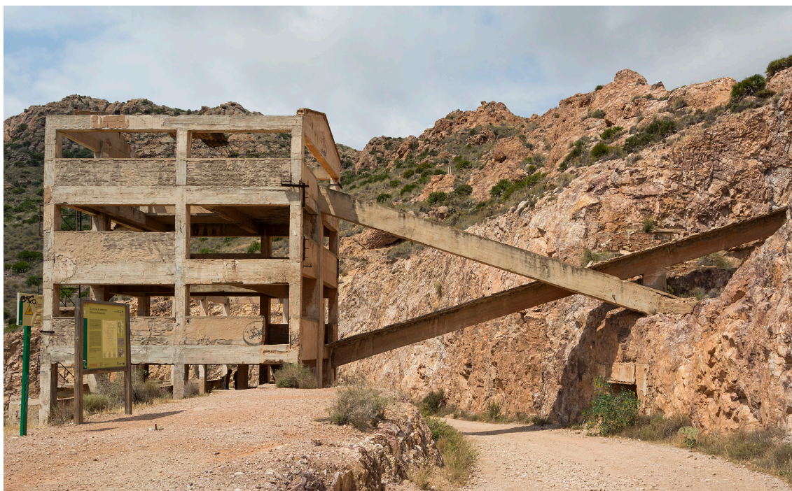
Imagen 63: Casa de trituración y molienda de la Planta Denver. Autoría propia.
