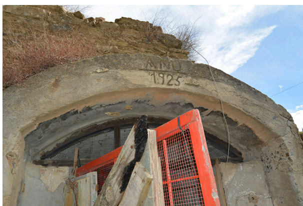
Imagen 358: Arco de acceso al polvorín en el que se registra la fecha de su construcción. Autoría propia.
