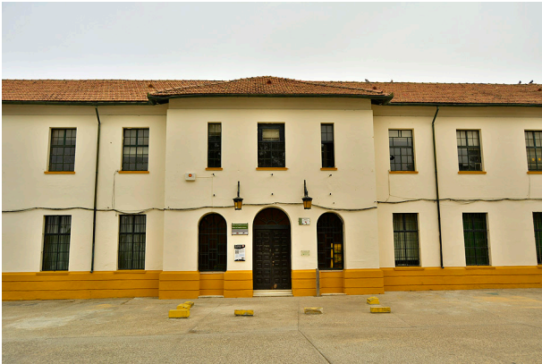
Imagen 145: Casa de Dirección, actual sede de la RTCL. Autoría propia.
