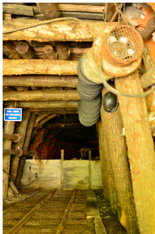
Imagen 14 : Socavón de la Rebaldana. Asturias. Autoría Propia.
