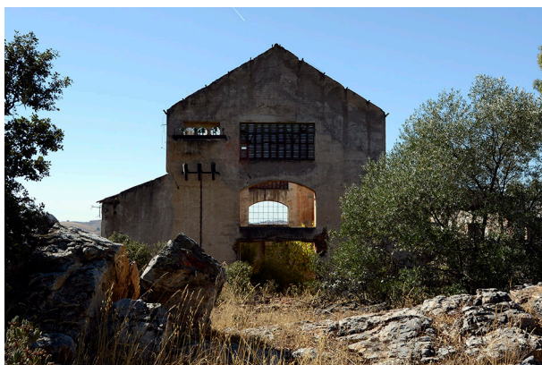
Imagen 212: Casa de máquinas del Pozo Federico. Autoría propia.
