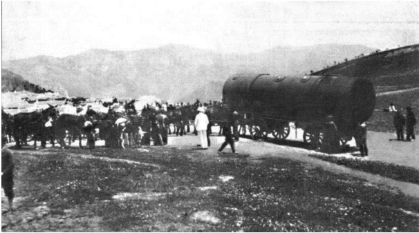
Imágenes 321 y 322: Transporte de una caldera de vapor y su llegada a El Centenillo. Fuente: fotografía digitalizada, cortesía del Colectivo Proyecto Arrayanes.
