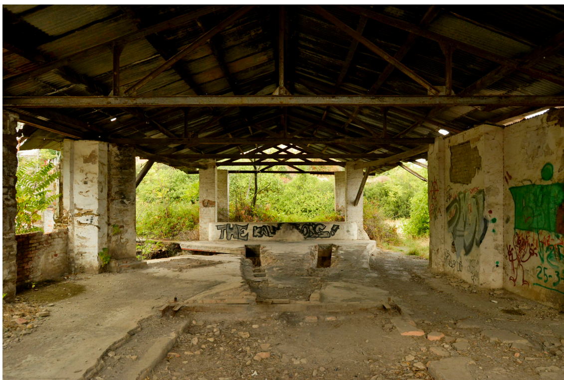
Imagen 357: El hangar de la estación del cable aéreo es la única construcción que permanece en pie de entre las habilitadas en la estación. La vegetación se ha adueñado del entorno e impide observar los restos, dificultando el acceso. Autoría propia.
