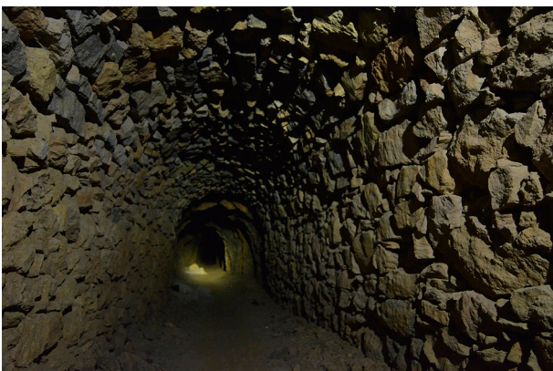
Imagen 112: Galería con entibación a piedra seca. Autoría propia.
