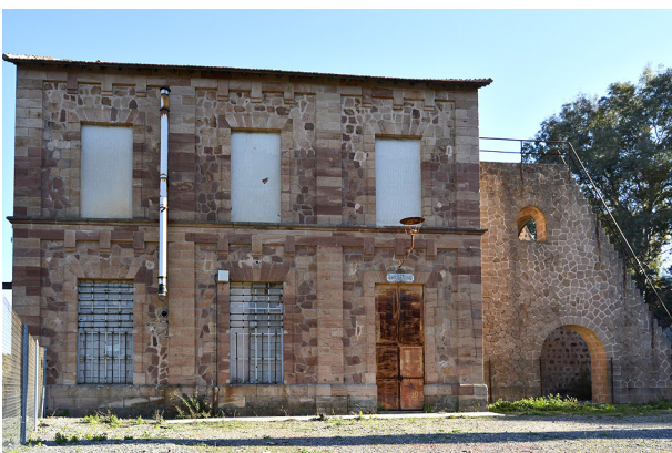
Imagen 178: Casa de bombeo alemana para el desagüe del Pozo B, marcado por la cabria de mampostería anexa. Ubicados sobre el filón Siles, la edificación fue transformada en Laboratorio. Autoría propia.
