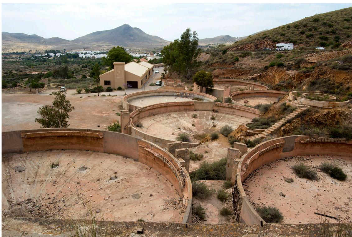
Imagen 66: Estructuras de los tanques de procesamiento de mineral de la Planta Denver y reconstrucción de la Casa PAF, actual Centro Geoturístico Casa de los Volcanes. Autoría propia.
