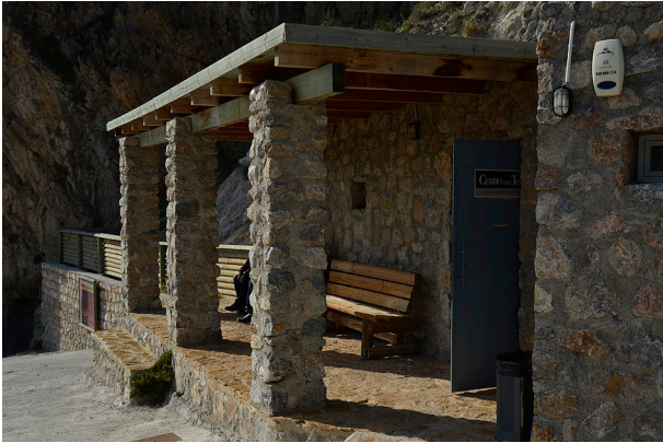
Imagen 90: Acceso principal al Museo Geominero del Cerro del Toro. Autoría propia.
