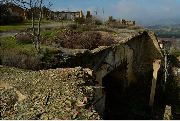
Imagen 354: Tolva que conecta el área minera de El Mirador y el lavadero del Cerro Lorente, rellena de escombros y restos de vegetación. Autoría propia.
