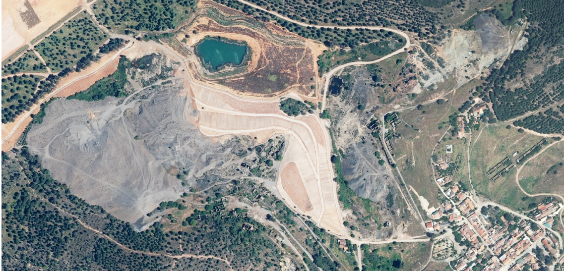
Imagen 285: Estado del depósito de lodos del lavadero del Cerro Lorente en 2013. Fuente: Visor de información REDIAM. Ortofotografía rigurosa color de Andalucía 2013.
