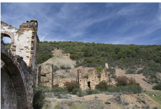
Imagen 350: Vista general de las instalaciones del Pozo El Macho. En el área superior, una rafa romana. Autoría propia.
