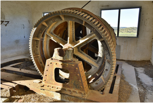
Imagen 168: Detalle de la bobina de cable en Pozo Número 3 o Cobo Nuevo. Autoría propia.
