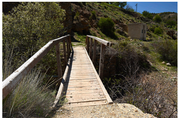
Imagen 60: Puente de acceso a La Jota. Autoría propia.
