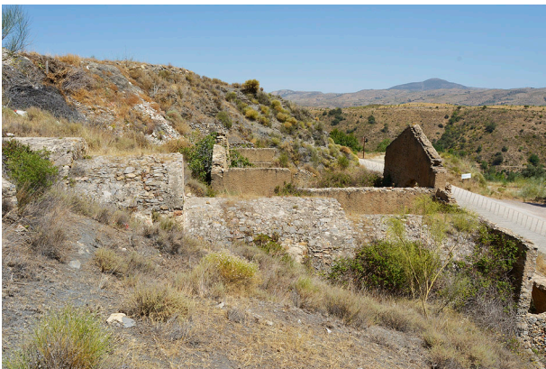
Imagen 103: restos de la fábrica de beneficio de mercurio. En la imagen se observa el cañón de salida de gases de la chimenea y las particiones que permiten la condensación del mercurio. Autoría propia.
