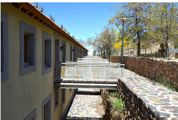
Imagen 49: Fachada trasera de la antigua residencia de obreros Santa Bárbara, rehabilitada como conjunto de apartamentos turísticos. Autoría propia.
