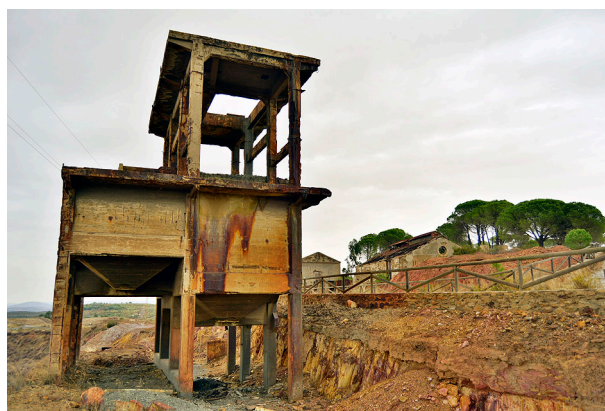
Imagen 163: Tolva de mineral junto a la corta Sierra Bullones en estado de abandono. Autoría propia.
