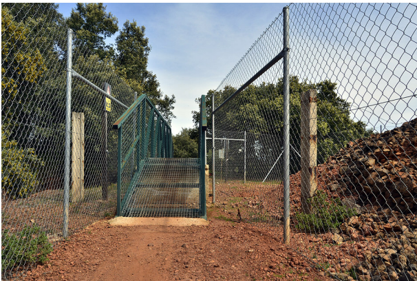
Imagen 218: Puente metálico sobre una rafa y vallado de un pozo en el sendero de Paño Pico. Autoría propia.
