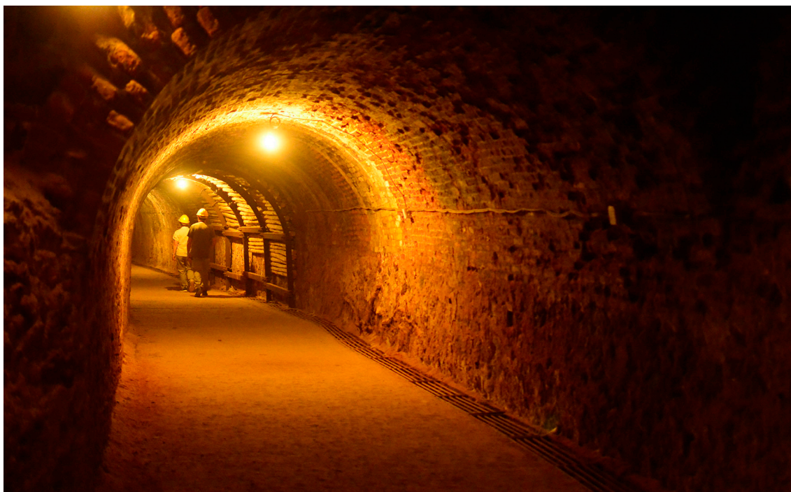
Imagen 137: Galería de Santa María. En la imagen podemos observar la intervención realizada en materia de seguridad a través de entibaciones metálicas sobre las que descansan troncos de eucalipto para evitar desprendimientos. Autoría propia.
