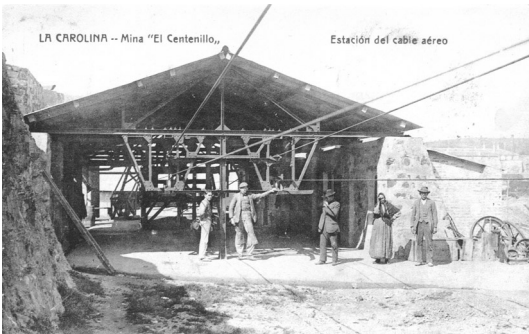
Imagen 326: Estación del cable aéreo de El Centenillo. Fuente: Imagen digitalizada, cortesía del Colectivo Proyecto Arrayanes.
