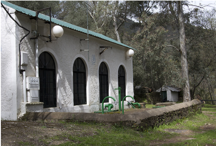
Imagen 235: Casa de bombeo construida para abastecer de agua a El Centenillo. El servicio inaugurado en 1909 se estableció junto al Arroyo de los Camarenes y en la actualidad alberga maquinaria utilizada para la dotación de agua al poblado. Autoría propia.
