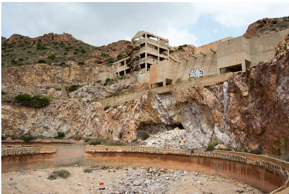
Imagen 65: Tanque de tratamiento de mineral y área de trituración de la Planta Denver. Autoría propia.
