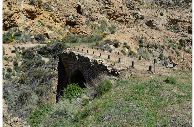
Imagen 58: Camino hacia La Jota. Sobre el puente se puede ver que se están realizando obras de acondicionamiento para instalar una baranda en ambos laterales. Autoría propia.
