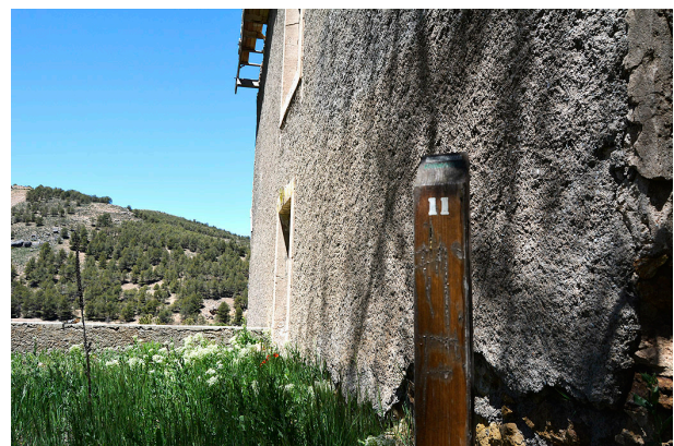
Imagen 57: Señalización del inmueble número 11 del plano, la casa cuartel de la Guardia Civil, en la fachada del edificio. Autoría propia.
