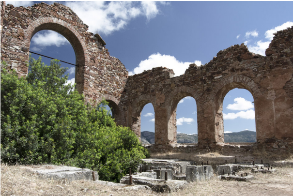
Imagen 355: Interior de la casa de máquinas de la cabria de Pozo Nuevo. La vegetación crece en el área que la conecta con el espacio de calderas. Autoría propia.
