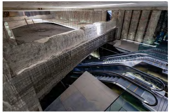
Construcción de la bóveda, muro de argamasa original (en 1er término). Autor: Antonio Luis Martínez Cano.
