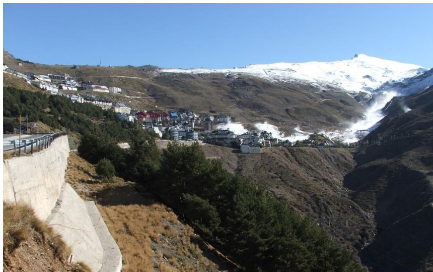
Estación de esquí de Sierra Nevada (carretera de acceso, urbanización y pista del Río). Foto propia, tomada el 3 de diciembre de 2017.
