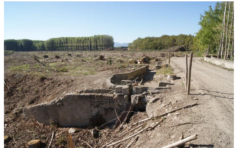
Antiguo partidor, ya no funcional, cercano a la acequia de Gamboa (sistema de riego de la acequia Gorda) localizado en el pago de El Rau (término de Granada). Foto propia, toma el 8 de octubre de 2012.
