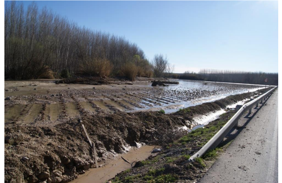
Desbordamiento del río Genil aguas abajo de Fuente Vaqueros, junto a la carretera que comunica este núcleo con el de Valderrubio (en las inmediaciones de Casa Real). Foto propia, tomada el 14 de marzo de 2013.
