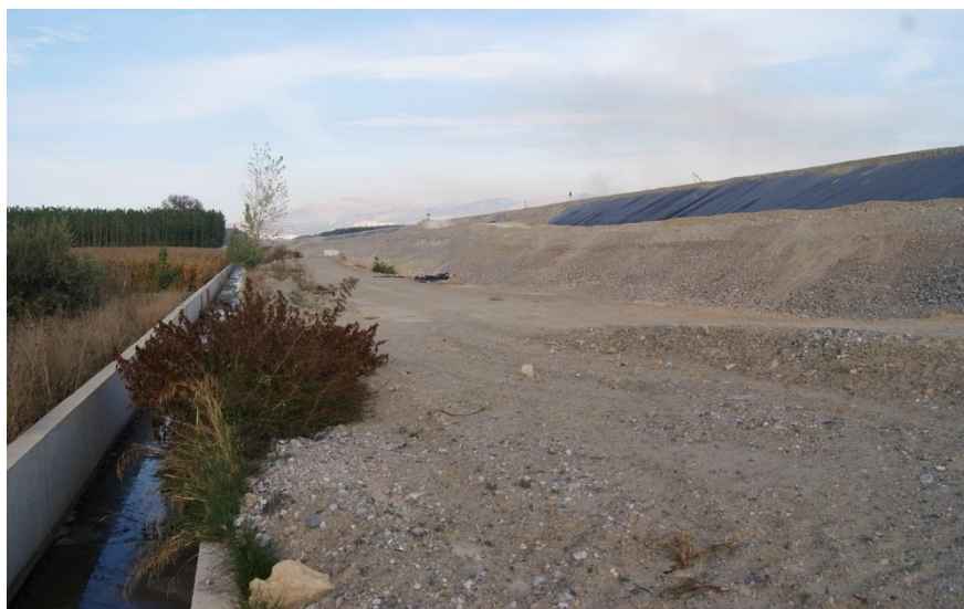
Las obras de las grandes infraestructuras viarias que discurren por el ámbito han generado enormes taludes (longitudinal y verticalmente) que requieren un adecuado tratamiento vegetal. Foto propia, tomada el 1 de noviembre de 2016.
