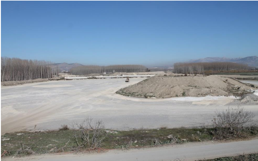
El consustancial impacto de las grandes infraestructuras alcanza una de sus máximas expresiones en la A-44 (momento de la explanación, en la imagen) a su paso por el espacio de vega. Foto de A. Sánchez Baca, tomada el 21 de diciembre de 2015.
