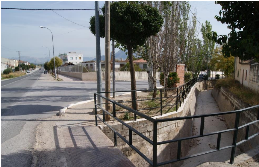
Una de las pocas canalizaciones de la red menor de drenaje acometidas hasta la fecha es la del arroyo del Cascojar a su paso por Casanueva (Pinos Puente) y la carretera A-336. Foto propia, tomada el 1 de noviembre de 2016.
