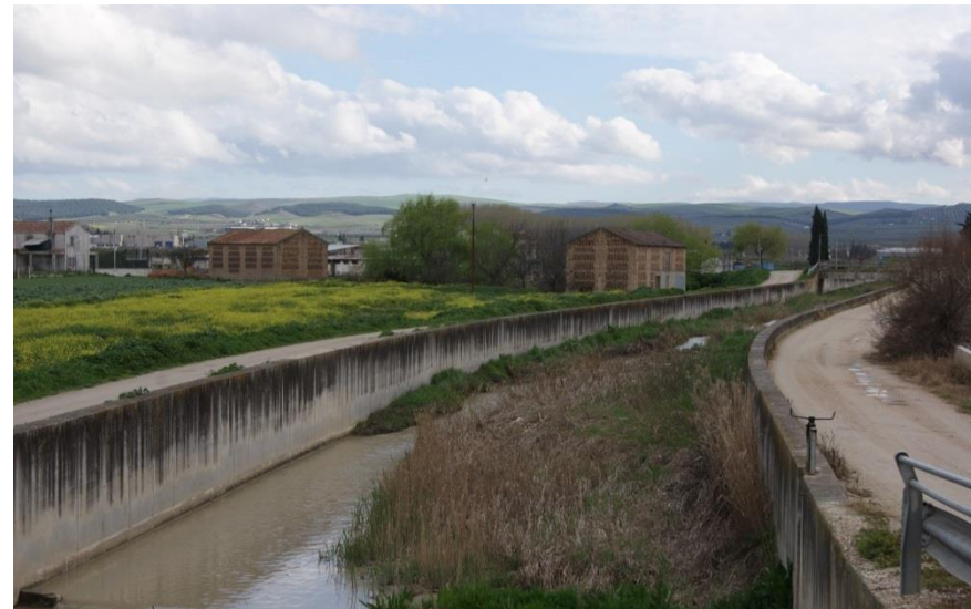
Encauzamiento del arroyo Saldo en las inmediaciones de Chauchina. Foto propia, tomada el 26 de marzo de 2013.
