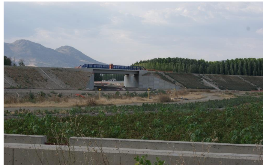
Entre las grandes infraestructuras que atraviesan el espacio de vega, alcanza máxima expresión como elemento perturbador, ambiental y paisajísticamente, la segunda ronda de la autovía A-44. Foto propia, tomada el 17 de junio de 2017.
