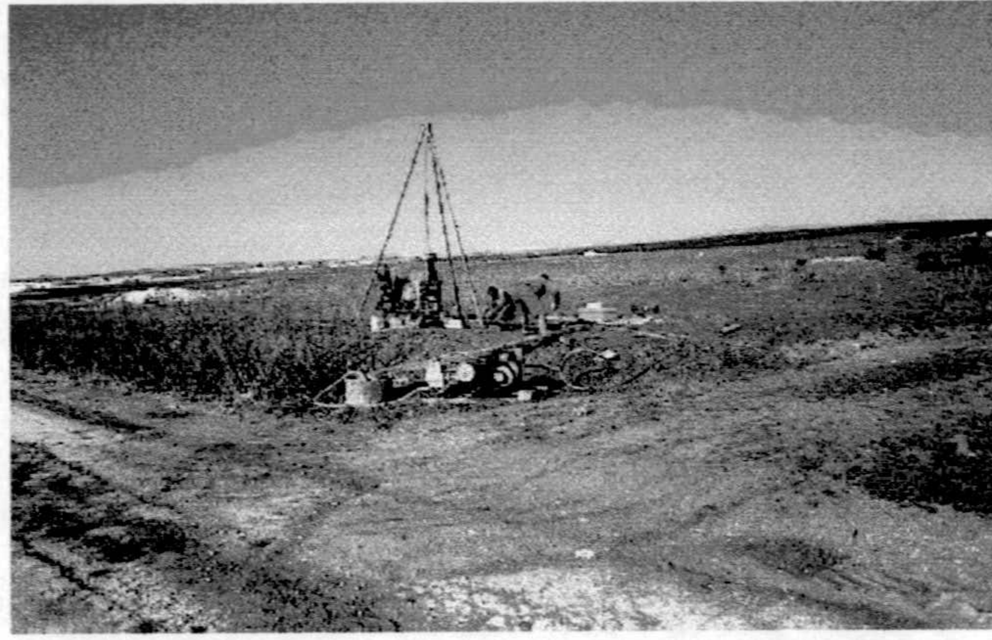
Figura 2.1. Realización del piezómetro "Dulce SW" (UTM 30S UG 36380210), mayo 1999
