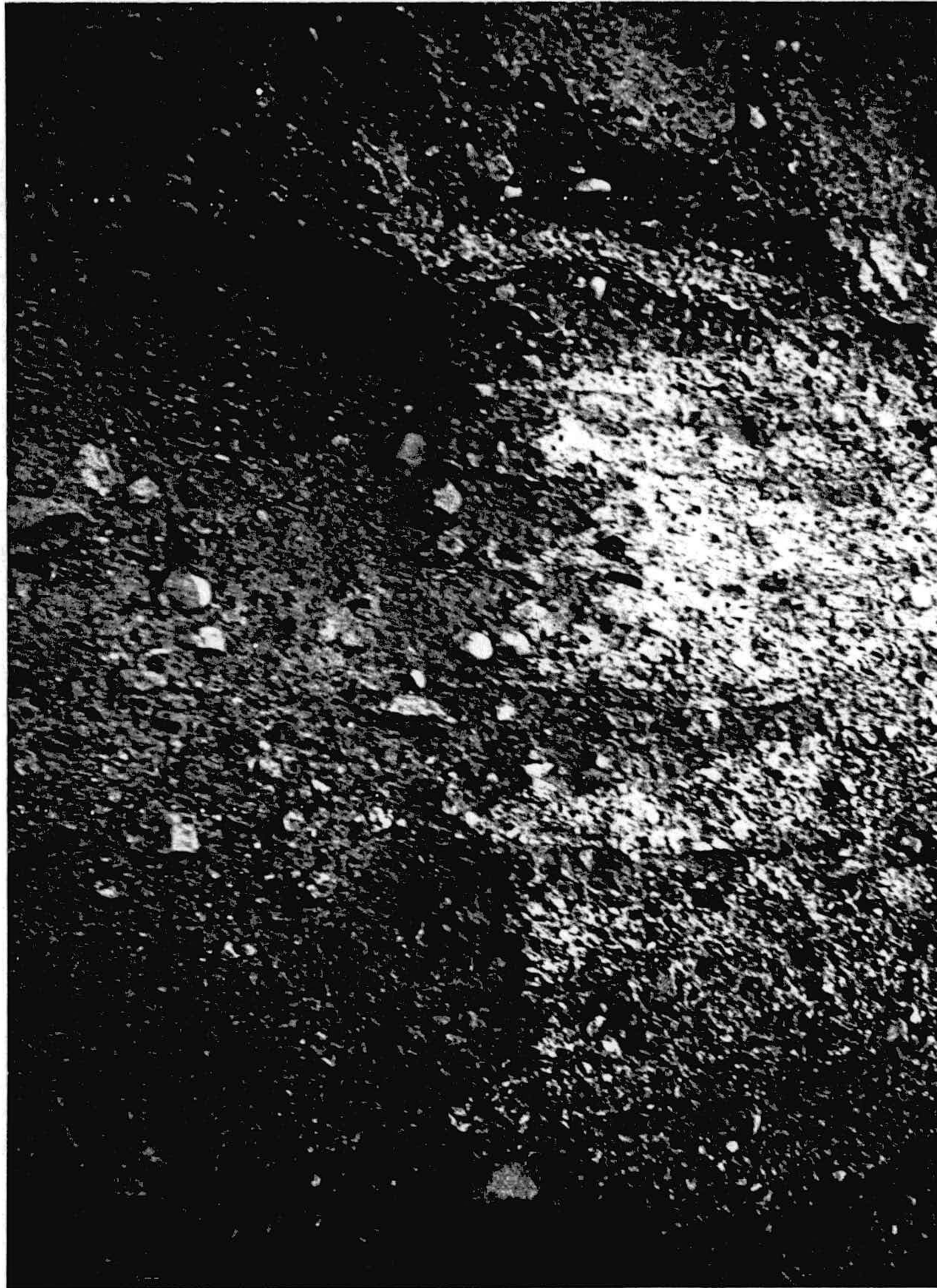
Fig. 10.2. Acuñaamiento del mortero de cal hacia el interior del muro.
