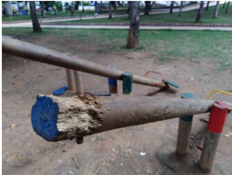
Imagen 62. Deterioro juegos infantiles en Parque San Francisco. Bucaramanga. 2017. Fuente: El autor.
