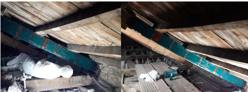
Figura 5.8. Imágenes del último repaso de resina y del estado final del refuerzo.
