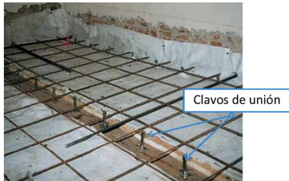
Figura 2.2. Imagen de una actuación de losa de hormigón sobre un forjado de viguetas de madera. Fuente: http://reotec.es/reparraciones-y-refuerzos-estructurales/reparraciones-en-construcciones-antiguas .
