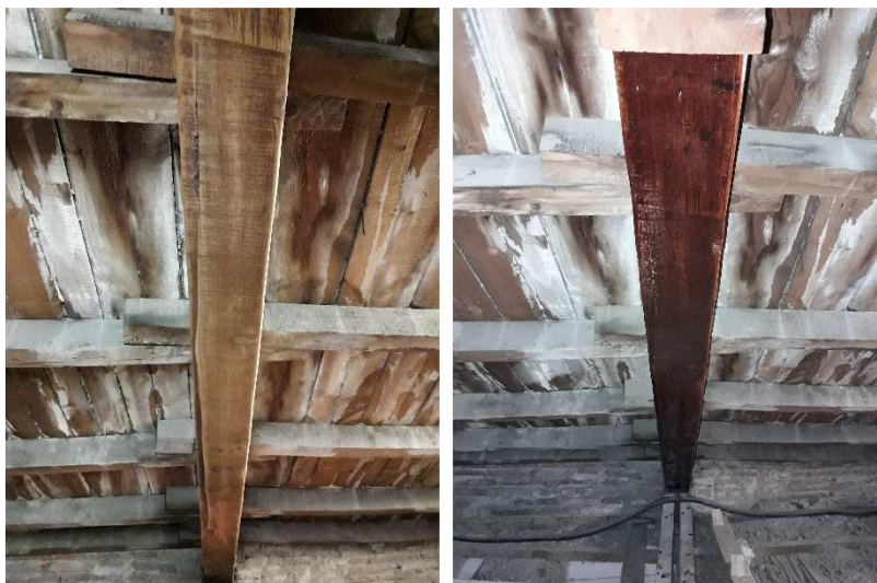
Figura 5.6. Imágenes del par antes y después de aplicar la capa de imprimación.
