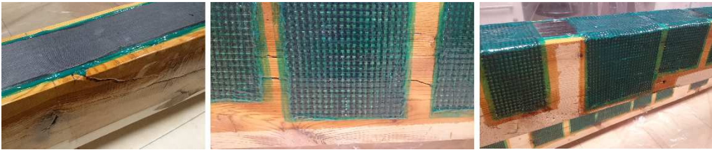
Figura 3.28. Fotografías de las vigas reparadas en la Fase 2. Izq.: Viga reparada con refuerzo LR-r. Centro: detalle de grietas existentes en una viga BR-r. Der.: Adaptación de la posición y dimensión del tejido a cada viga.
