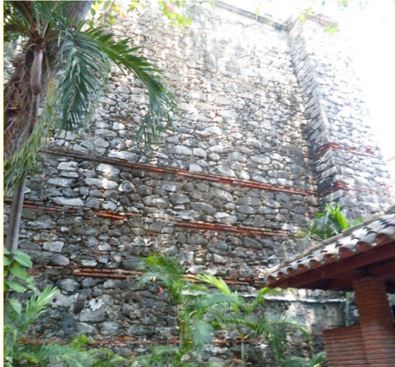
Ilustración 44. Muro posterior de antigua capilla construida en la colonia en lo que ahora se conoce como antiguo Teatro Colon. Aunque está compuesto principalmente por fragmentos de roca caliza, en él se usan ladrillo para confinar y nivelar el muro. Berrocal, Al. (2016) [Fotografía].
