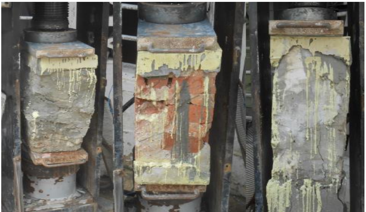
Ilustración 37. Muretes extraídos del Claustro San Francisco, muretes de ladrillo y fragmentos de piedra coralina. 10. Berrocal, A. (2017) [Fotografía e Ilustración]
