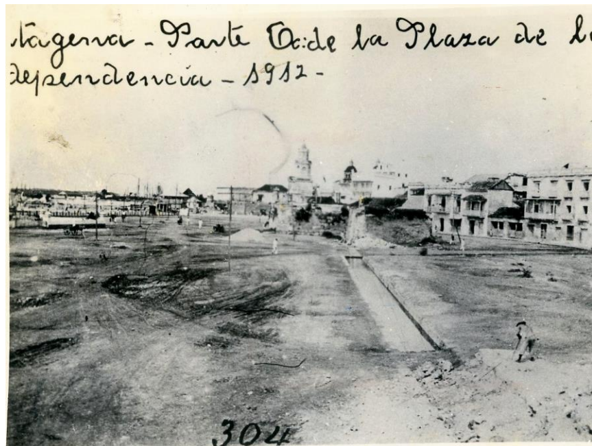
Imagen 21: Demolición de murallas. sf. Fuente: Fototeca Histórica de Cartagena
