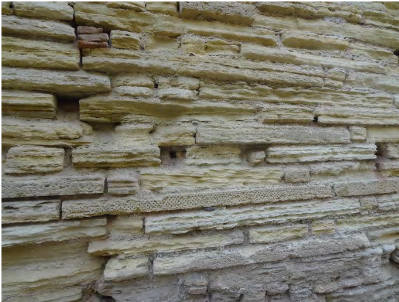
Fig. 16. Bordillos de sepultura de arenisca reutilizados en el foso de acceso desde la puerta de la Justicia a la puerta del Vino en la Alhambra. (Foto C. Vílchez. 2018)
