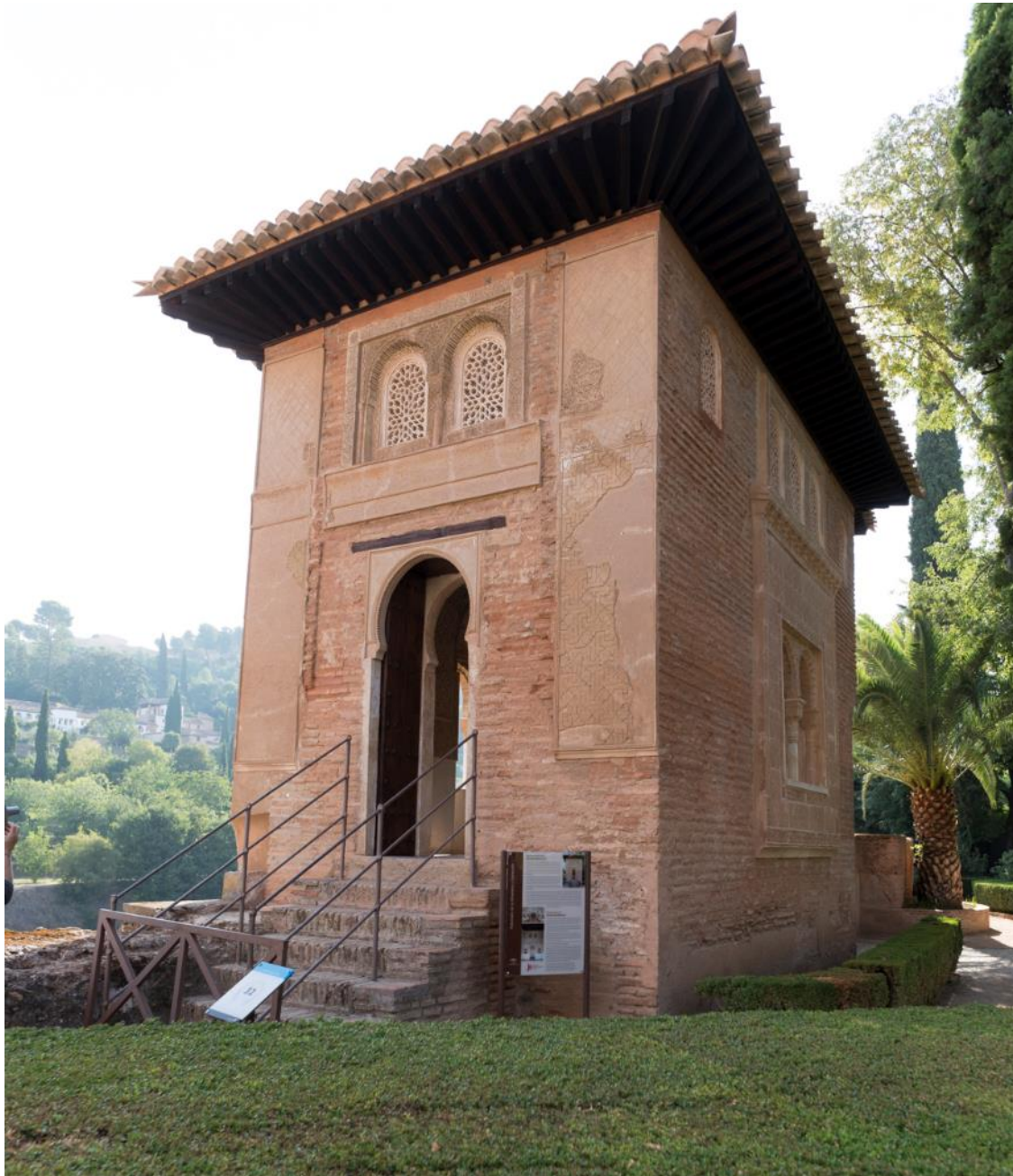
Ilustración 134 Oratorio del Partal. Exterior
