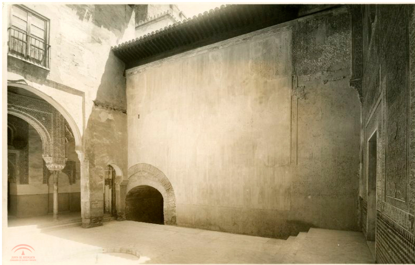
Ilustración 95 Foto de Torres Molina, de fecha desconocida en la que se aprecia parte del muro añadido para construir encima y la escalera que desciende hacia los sótanos de la
