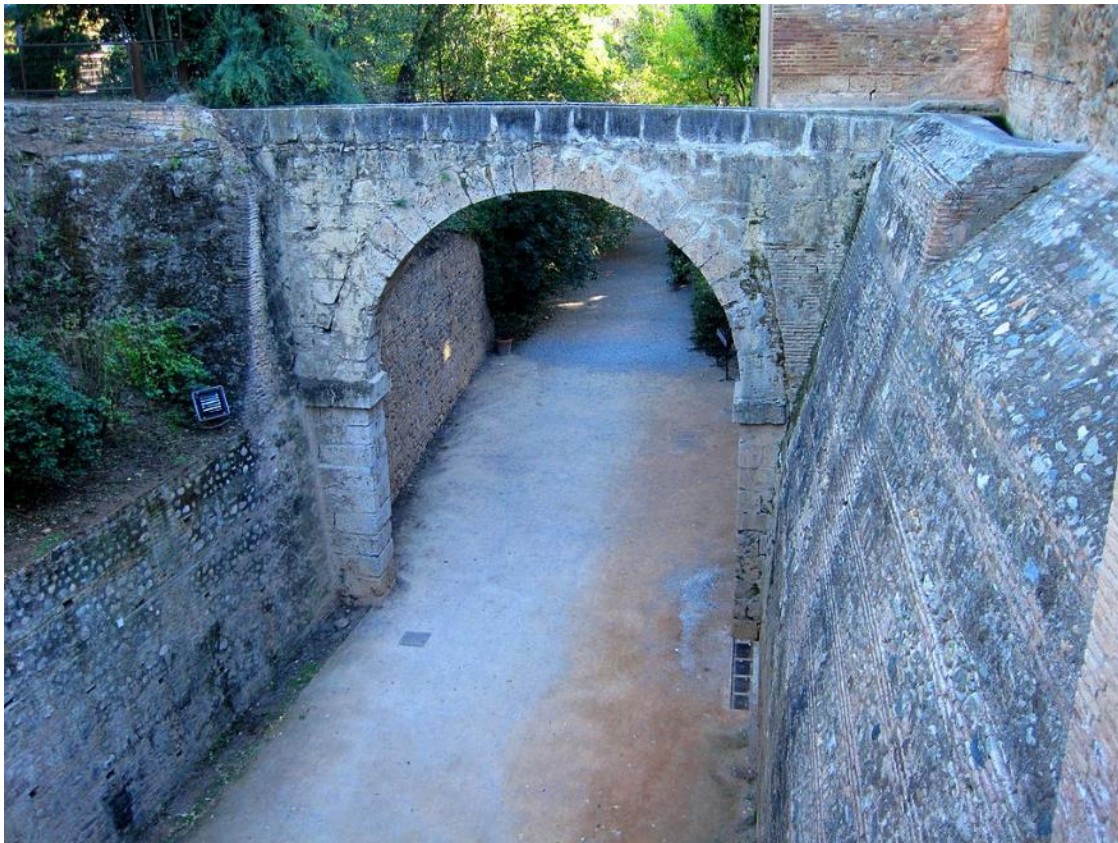
Ilustración 76 Acueducto actual de entrada del agua en la Alhambra
