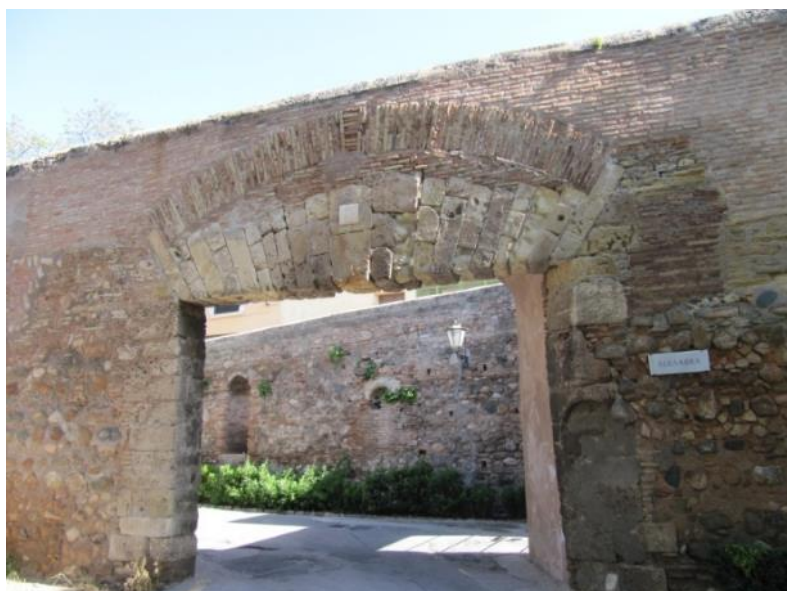
Ilustración 53 Puerta de los Carros (II) Acceso peatonal
