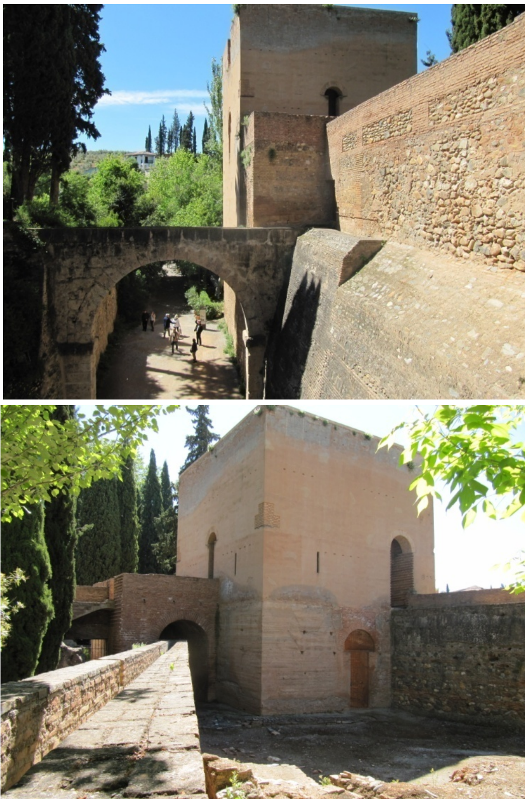
Ilustración 42 Torre del agua, vista interior y exterior con el acueducto
