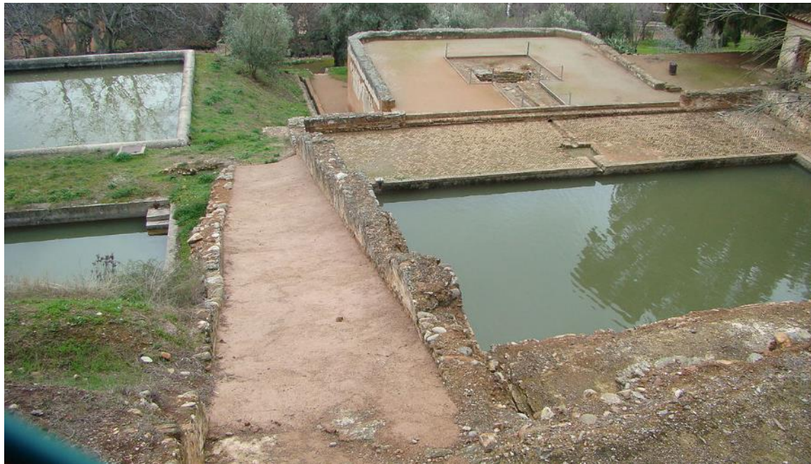
Ilustración 74 Vista general del Albercón de las Damas (a la derecha) junto con los dos depósitos construidos por Torre Balbás (junto a él) y por Prieto Moreno (más abajo)
