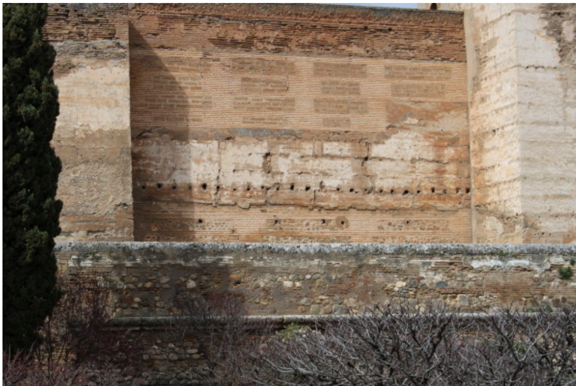
Ilustración 4 Huecos dejados por los mechinales en la alcazaba de la Alhambra
