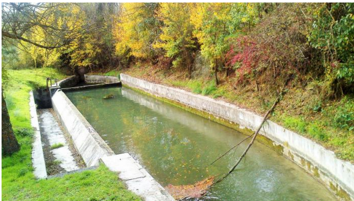
Ilustración 73 Decantador tras el desvío del caudal en la presa Real
