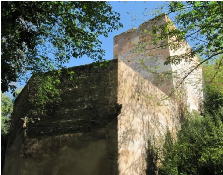
Ilustración 47 Torre de las Cabezas y Baluarte del Olivo
