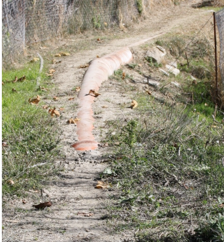
Figura 3: Acequia de La Solana. Tramo entubado.
