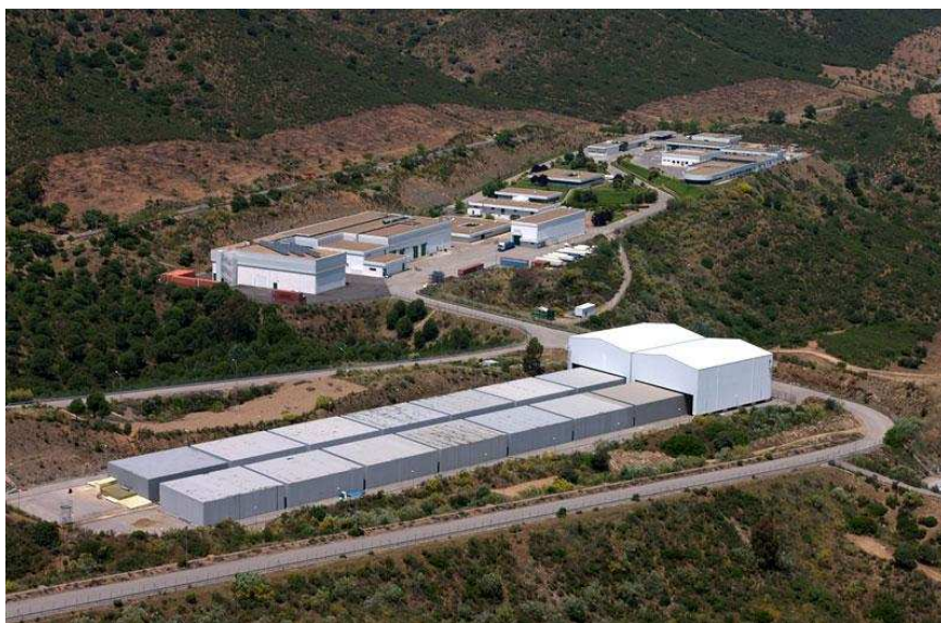
Figura 2: Instalaciones del almacén de residuos de baja y media actividad de El Cabril ( www.enresa.es ).
