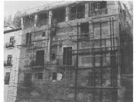
Vista del edificio a la Carrera del Darro antes y después del inicio de las obras.
