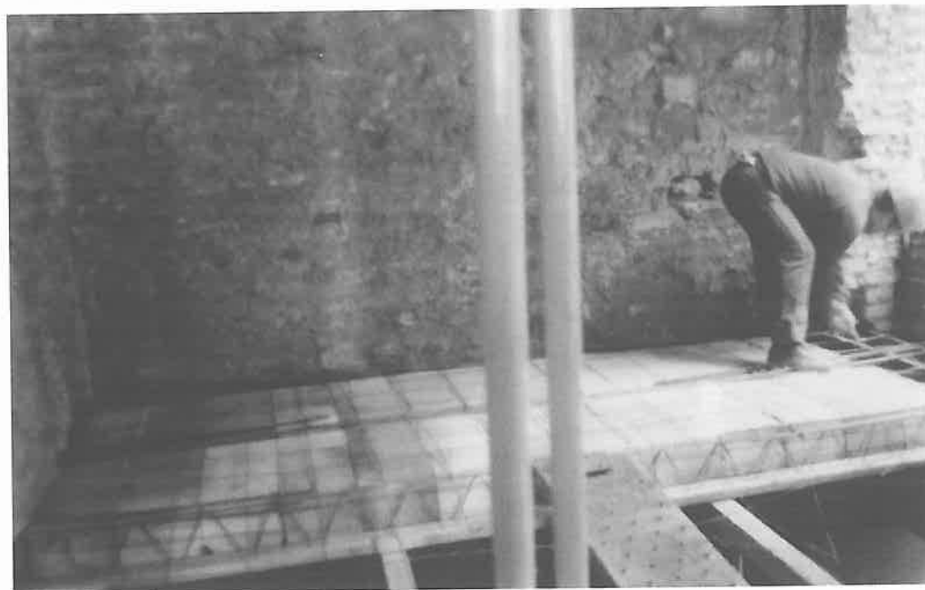
Ejecución del primer forjado en techo de planta baja.
