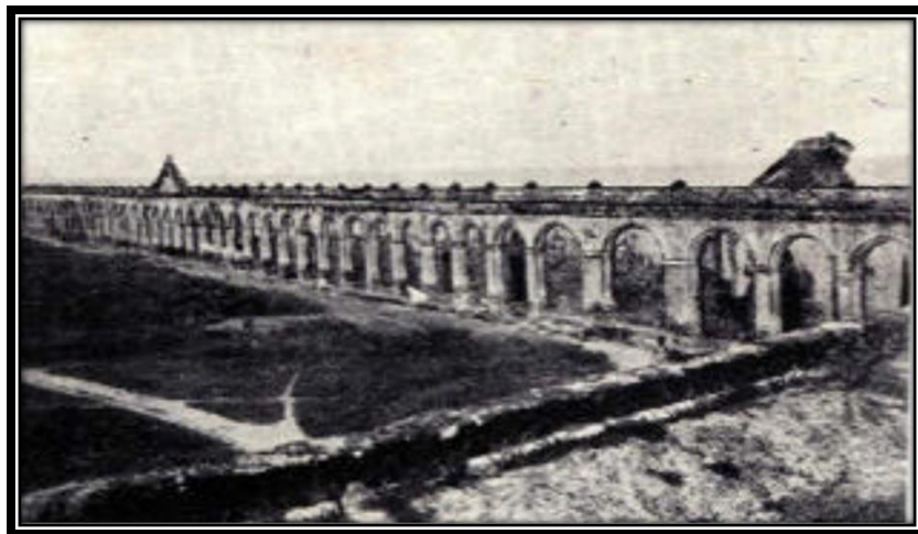
Ilustración 24. Estado de las bóvedas sin cubierta en el porticado, finales del siglo XIX 106
