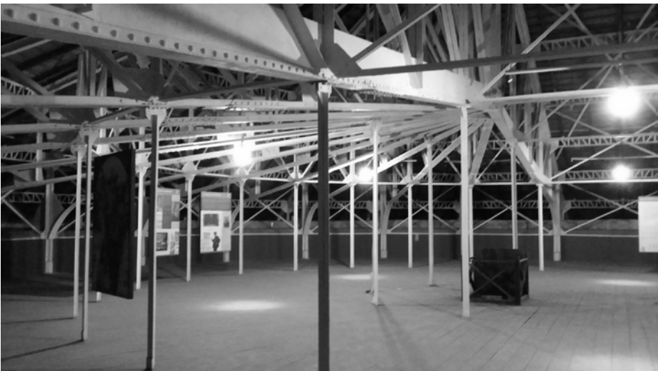
Fig. 2.- Gran Teatro Falla, Cádiz; estructura bajo cubierta sobre el patio de butacas. Fuente propia
