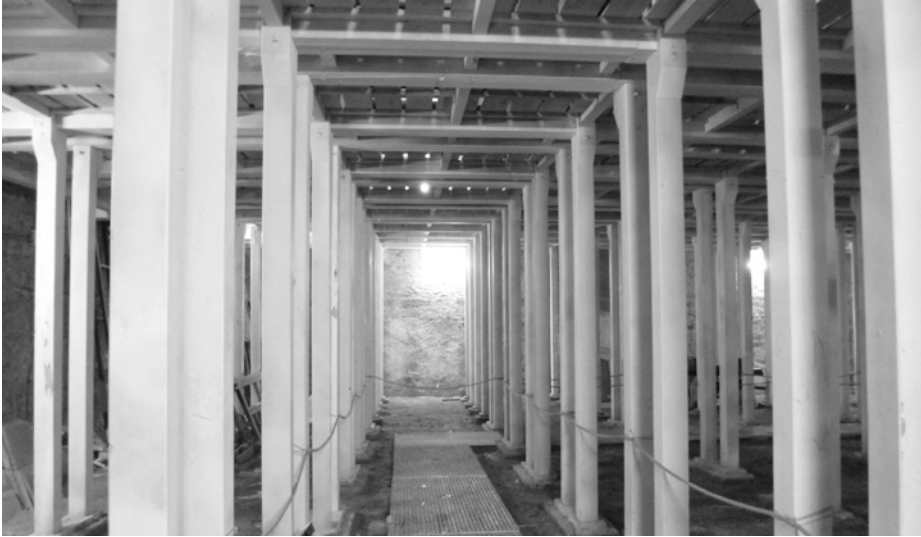
Fig. 1.- Gran Teatro Falla, Cádiz; segunda planta de foso. Fuente: Francisco del Corral
