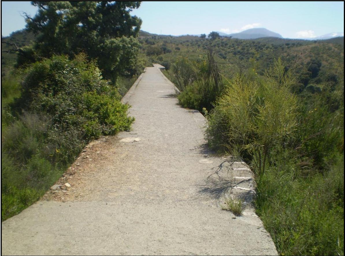
Su método de explotación consistió en desmontar los cerros auríferos con un fuerte chorro de agua. La fuerza del chorro del agua se debía al desnivel existente entre el canal de conducción y la base de la explotación, con 117 m de desnivel.
