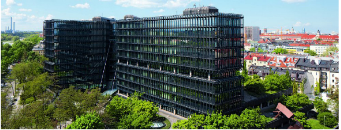
Edificio Isar, sede central de la Oficina Europea de Patentes, situado en Munich (Alemania). Fotografía: anónimo.
