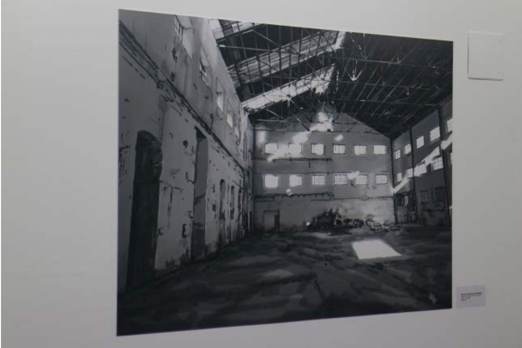
Panel de PVC en la exposición La Memoria del Azúcar , nave industrial de la Azucarera del Guadalfeo (Salobreña); Foto: Aureliano Rodríguez.
