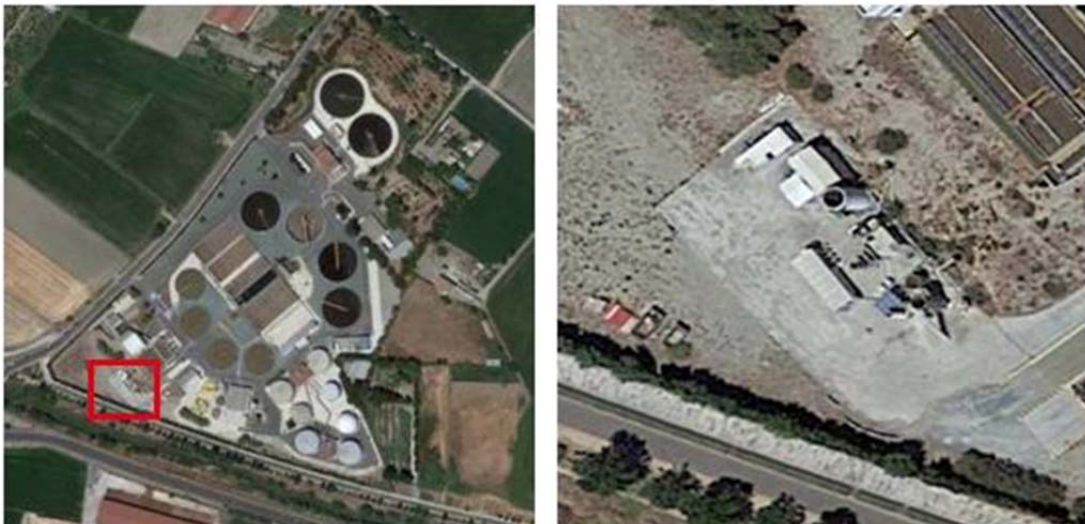
Figura 3.1: EDAR Sur Granada con ubicación de la planta experimental (izquierda) y detalle de la planta experimental (derecha)
