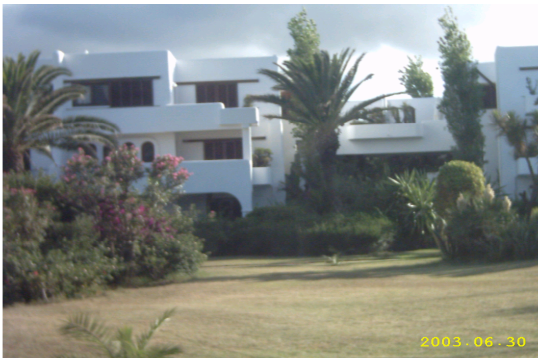
FOTO N°: 10. LOS CHALES DE SEGUNDA GENERACIÓN ( KABILA- MDIQ).
