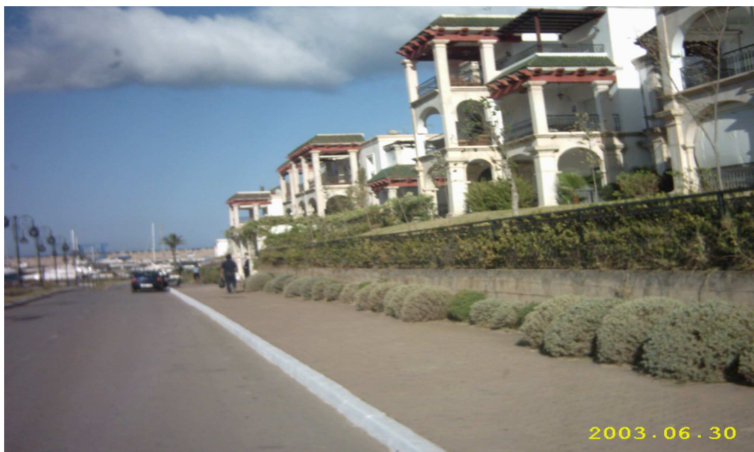
LOS BLOQUES DE APARTAMENTOS DE LA ÚLTIMA GENERACIÓN EN RESTINGA-SMIR.
