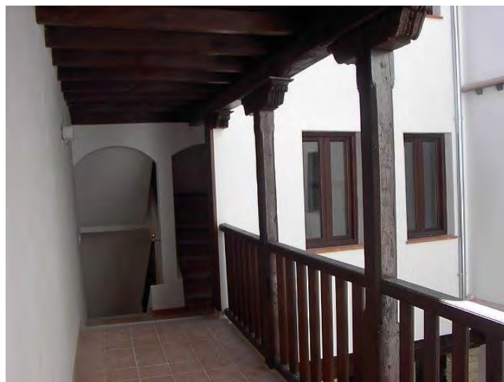
Galería rehabilitada de planta segunda del nº 6
