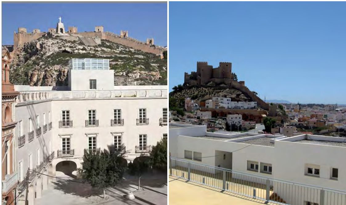
Fig.4.3.02: Izquierda: Rehabilitación y reforma de las Casas Consistoriales y de la Plaza de la Constitución de Almería. Autor José Ramón Sierra_ Arquitecto. Fuente: http://www.ljcarbonell.es/work/almeria/ Fotografías: www.joseramonsierra.es . Fig. 00: Derecha: Viviendas en la Chanca. Fuente: Memoria de Gestión 2009_EPSA.
