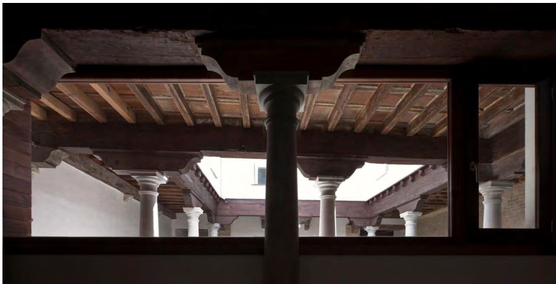
Vista de los capiteles y zapatas del patio desde la crujía de fondo, dormitorio en planta baja de la única vivienda en dúplex.
