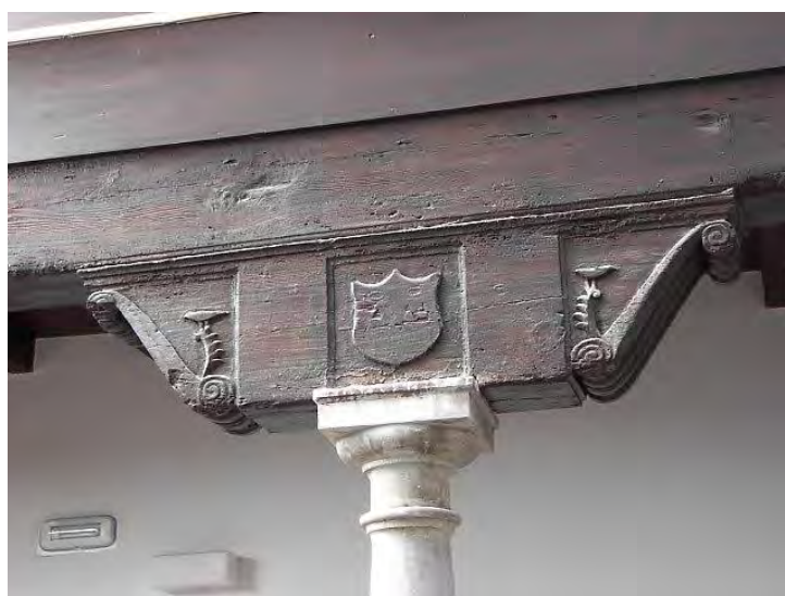
Columna toscana y zapata que apean la galería rehabilitada del nº 6
