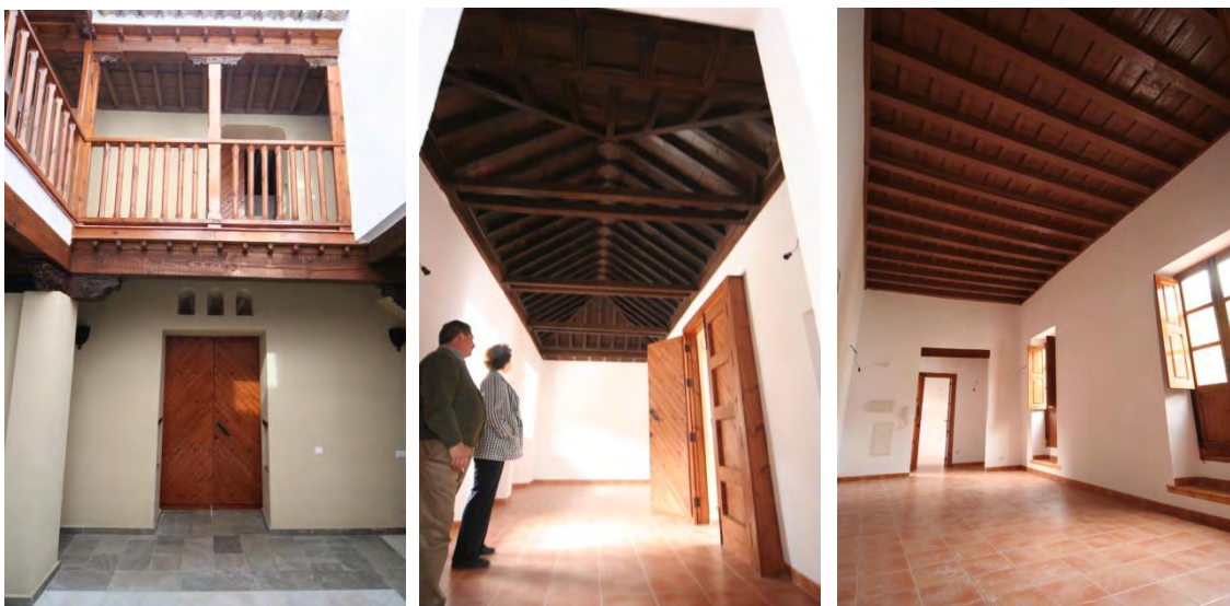
Izquierda: fachada de dos plantas de la casa morisca con sus elementos característicos y de mayor valor patrimonial que han sido recuperados y redescubiertos con la actuación: los dos huecos de acceso con sus tacas y en planta baja se han recuperado las tres ventanitas con arcos de medio punto de las que se han perdido sus celosías de yeso. Centro: sala principal con armadura mudéjar de cuatro paños con tres tirantes dobles de la que se ha reconstruido uno de los paños laterales que había desaparecido. Derecha: crujía a C/ S. Juan de los Reyes.
