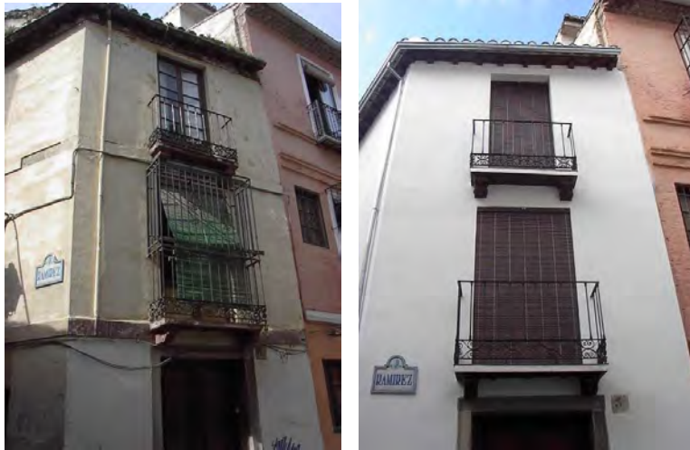
Estado previo de la fachada a Placeta de Ramírez y resultado final después de la rehabilitación
