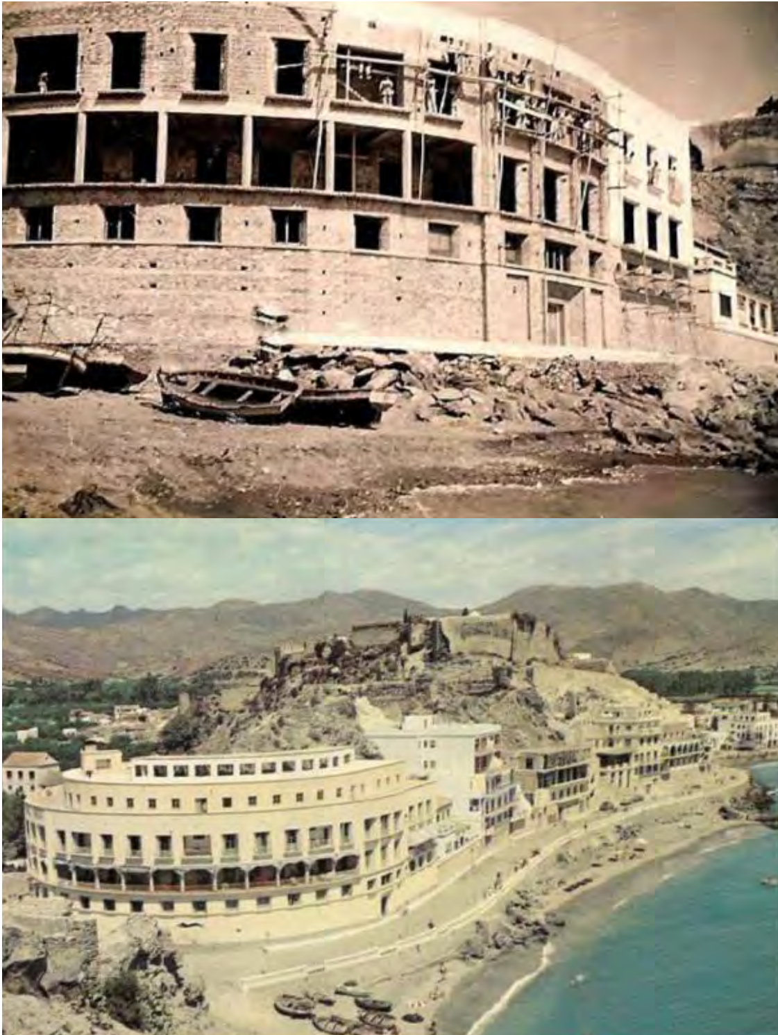
Fig. 2.3.07: Arriba: El Hotel Sexi en construcción 1953. Abajo: El hotel ya construido y detrás el Castillo de S. Miguel desde el Peñón del Santo. Postal turística de los años 60 del siglo XX.
