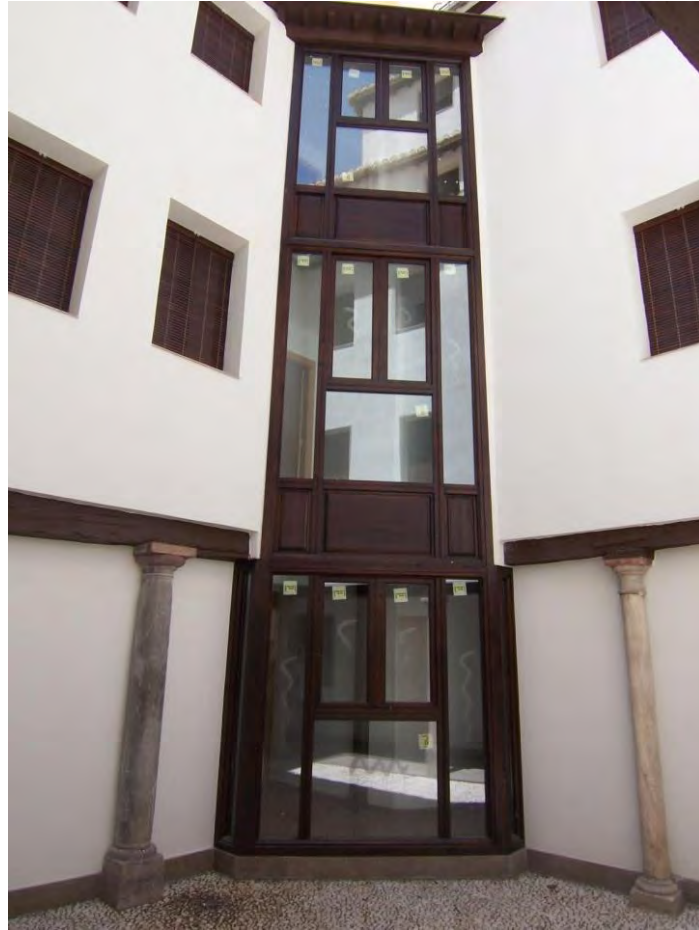
Detalle del cierre en vidrio y madera que resuelve el estrecho paso entre crujeas y que achafana el espacio del patio
