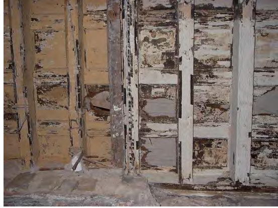
Labores de limpieza de alfarjes de la crujía morisca. La buena calidad de las piezas que lo forman ha permitido su mantenimiento con la reposición de algún elemento como la tocadura desaparecida o la sustitución de alguna vigueta en mal estado.
