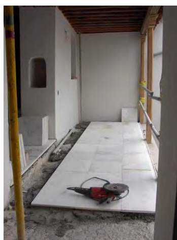
Proceso de recuperación de la planta segunda de la galería morisca: 1) Demoliciones previas y atirantado, 2) una vez reconstruida la cubierta y redirigidas las cargas se restaura su alfarje y se inician los revestimientos, 3) estado final antes de colocar los balaustres y las carpinterías
