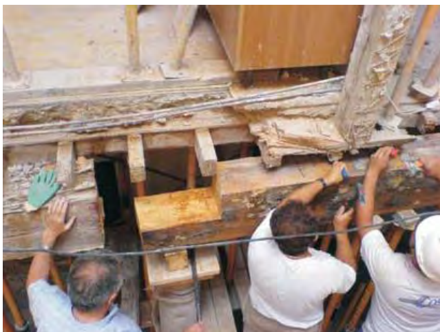
Sustitución de viga en mal estado, previo apeo de galería y protección de columna, por otra viga de similares características, y resultado final
