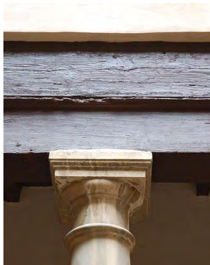
Sustitución de viga en mal estado, previo apeo de galería y protección de columna, por otra viga de similares características, y resultado final
