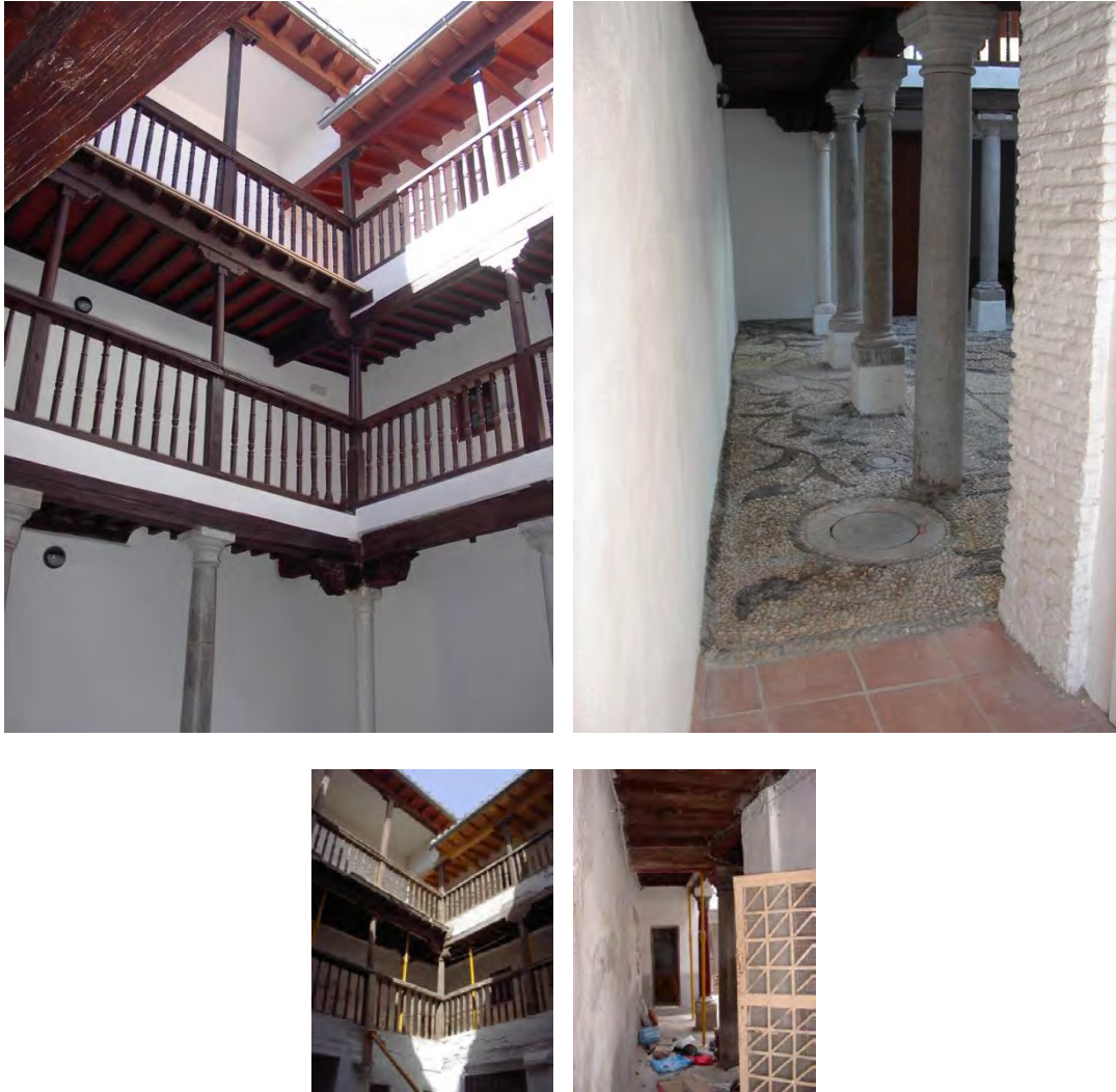
Abajo: estado previo de las galerías con ocupación de las de planta baja. Arriba resultado final una vez liberadas as galerías y reforzados o sustituidos los elementos de la estructura de madera que los precisaban y restauración del dibujo perdido del empedrado del patio
