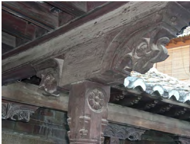
Galería original de las casa morisca (1). Galería lateral reconstruida en el s XX (2). Detalle de zapata morisca de la galería original (3)
