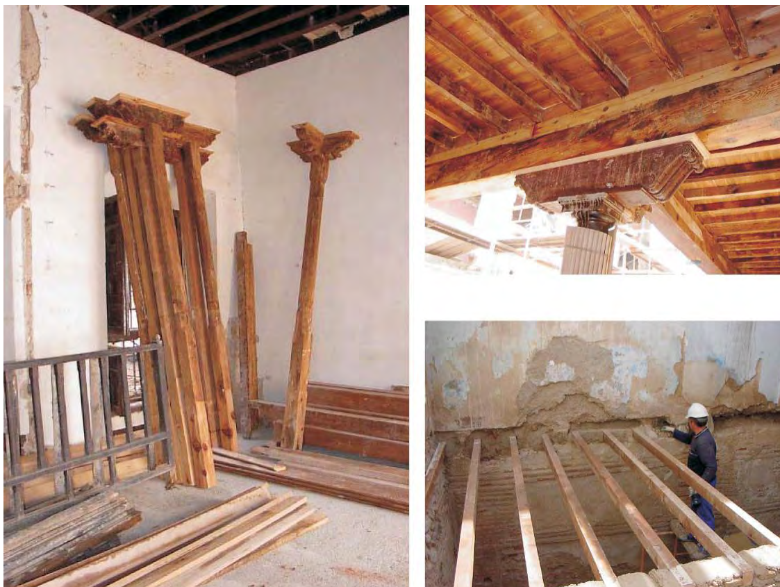
Fig. 05.07. Trabajos de rehabilitación para la obtención de 9 viviendas en los edificios de C/ Zafra 6-8 durante los años 2007-2008. ARC Albaicín. Fuente: elaboración propia.
