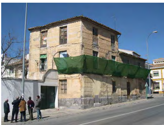
Fachada del nº 45 a la Carretera de Murcia y detalle del mal estado de sus revestimientos, carpinterías y alero.
