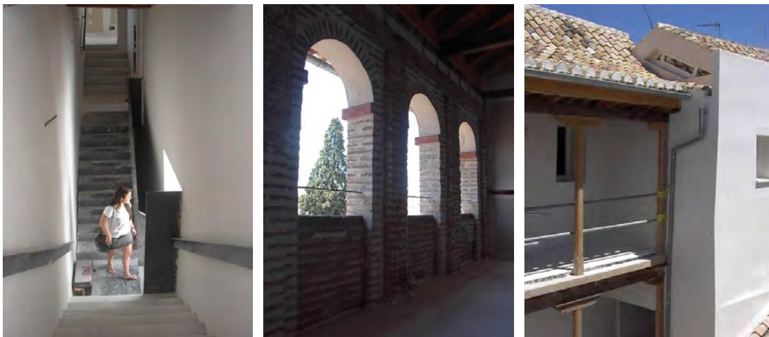
Derecha: Crujía Este, con la escalera de dos tramos, uno sustituido por zanca de acero plegado y otro rehabilitado. Centro: Torreón de la crujía Sur abierto a la Cuesta de S Gregorio y vistas a la Alhambra. Derecha: crujía Norte, galería morisca en rehabilitación con su cubierta reconstruida
