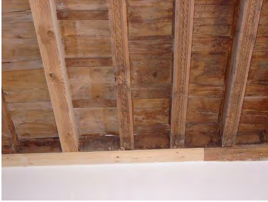
Labores de limpieza de alfarjes de la crujía morisca. La buena calidad de las piezas que lo forman ha permitido su mantenimiento con la reposición de algún elemento como la tocadura desaparecida o la sustitución de alguna vigueta en mal estado.
