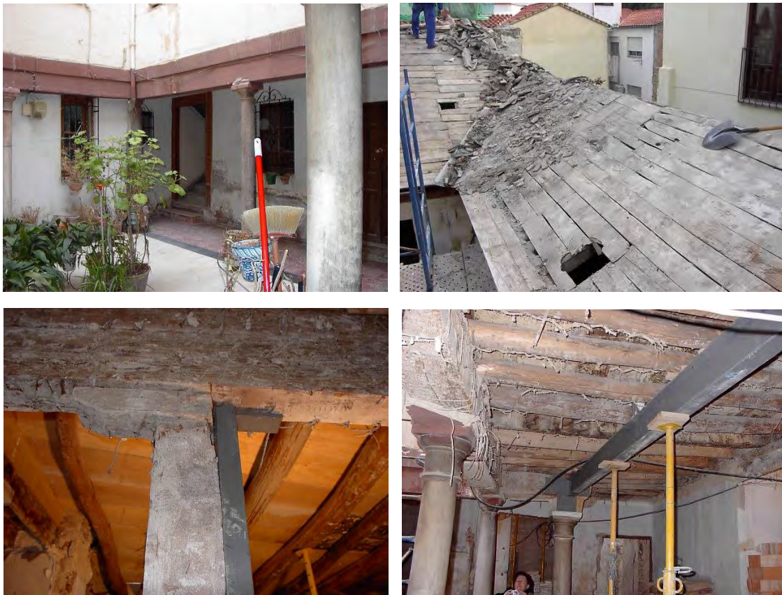
Arriba, izquierda: Patio en su estado previo a la rehabilitación. Arriba, derecha: trabajos de desmontaje de la teja y reposición d tablazón dañada. Abajo: refuerzos estructurales bajo los forjados de rolizo mediante perfilería metálica. El nulo valor patrimonial de estos permite que el refuerzo tenga una función estrictamente estructural y finalmente sea ocultado por un falso techo de escayola.
