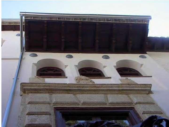
Remate de la fachada del nº 8 en el que un gran tejazoz cubre los tres huecos con arco de medio punto y protege la portada blasonada
