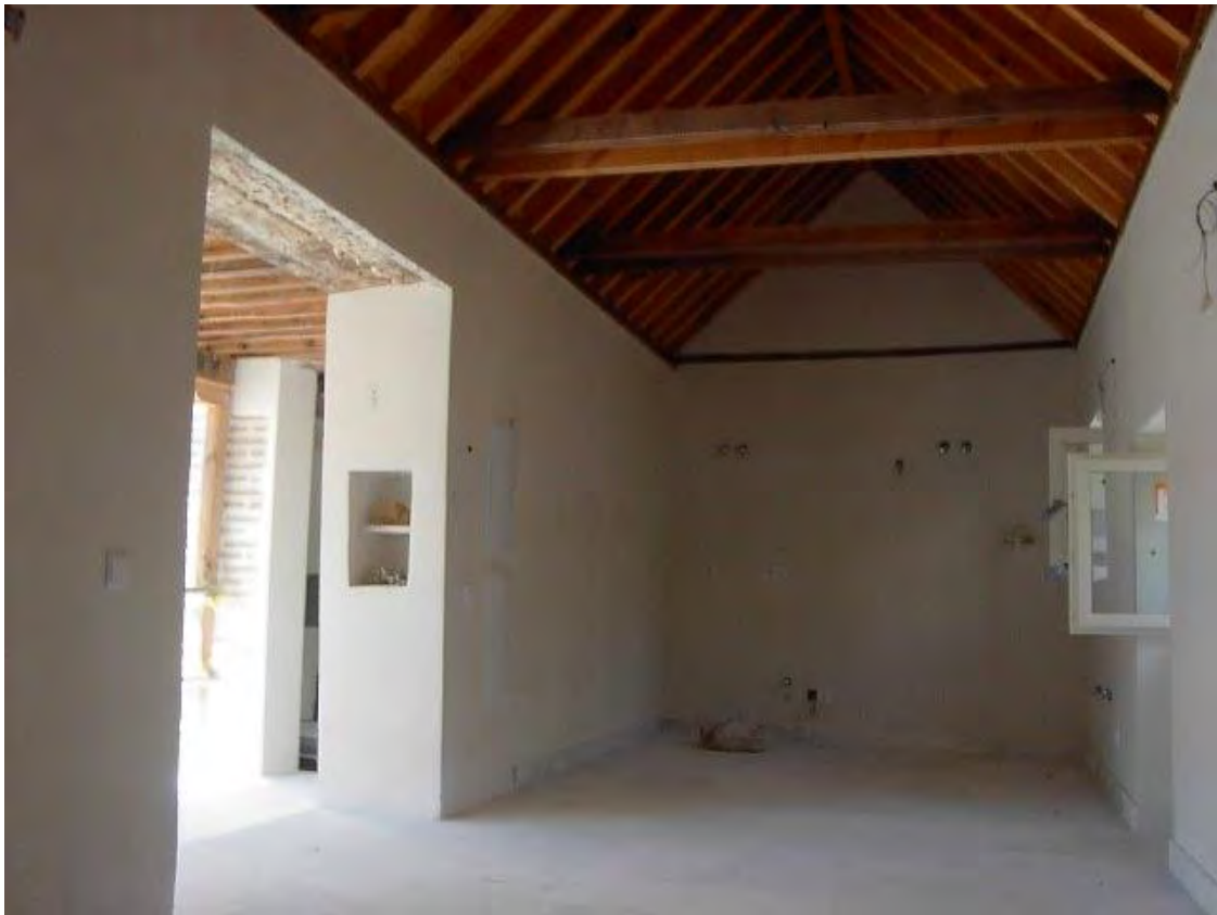
Sala morisca de la planta segunda con su cubierta reconstruida correctamente con los pares apoyando sobre los durmientes de los muros de carga y los tirantes, que se conservaban, trabajando de nuevo a tracción.
