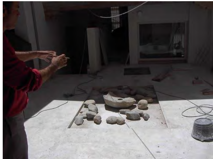
La intervención arqueológica descubrió la casa nazari sobre la que se edificó el cuerpo morisco y para dejar constancia de la situación de los restos de la cimentación de la alberca conservados bajo el nivel del patio, se ha decidido señalarlos mediante un pequeño rebaje en la solería de mármol manteniendo aproximadamente la geometría de aquella.
