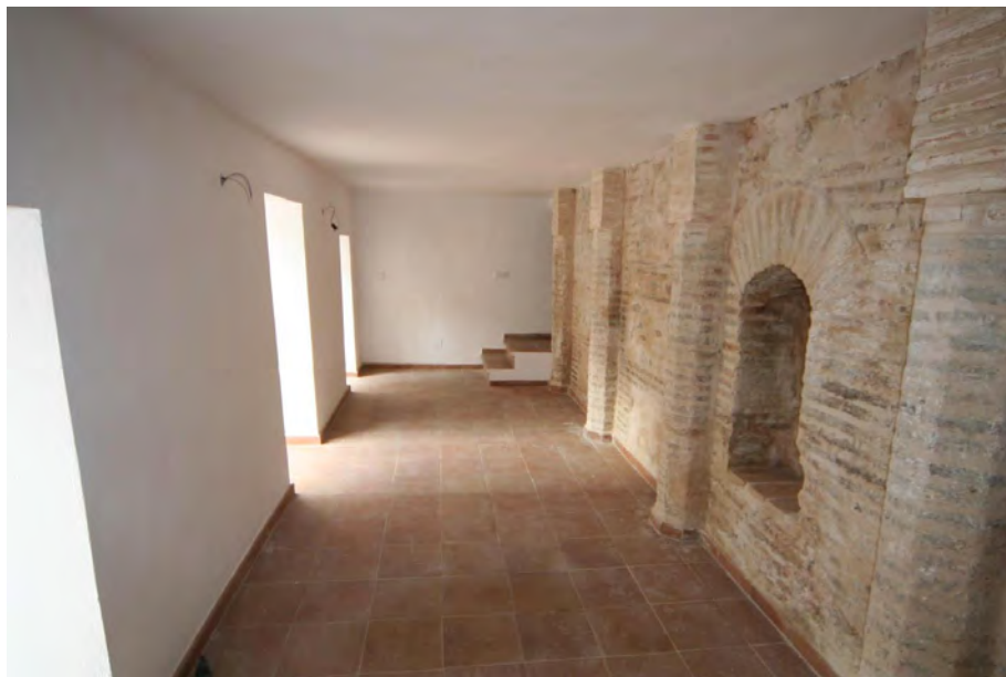
La acequia de S. Juan de los Reyes condiciona buena parte de las casas de la calle y en este caso se han puesto en valor algunos elementos relacionados con ella, unos en el patio y otros en la planta semisótano como la que aparece en la fotografía.
