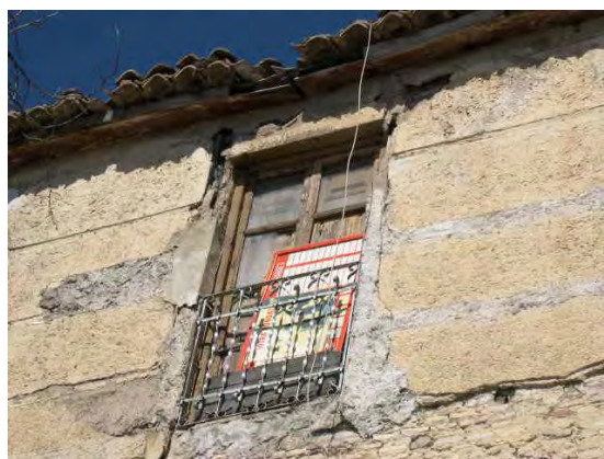
Fachada del nº 45 a la Carretera de Murcia y detalle del mal estado de sus revestimientos, carpinterías y alero.
