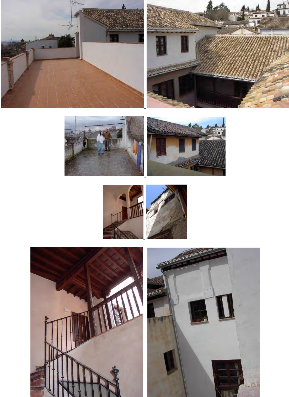
Arriba, resultado de la intervención en cubiertas (tejado de teja árabe y terraza) comparado con su estado previo. Abajo, caja de escalera y fachada del patio lateral (estado previo y resultado de la intervención): en coherencia con la intervención en la gallería, también en el ámbito de la escalera se descubren, refuerzan y protegen para dejarlos vistos sus sencillos alfarjes de madera.
