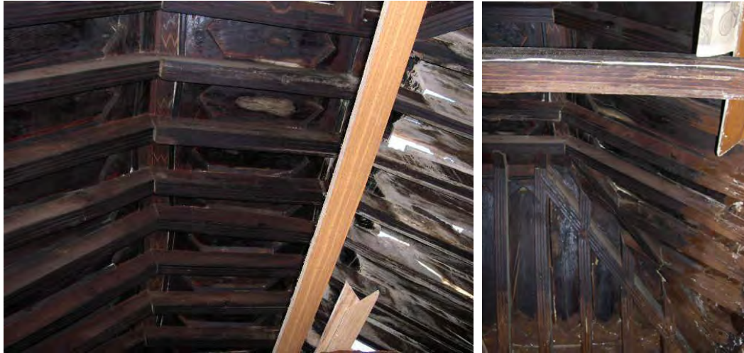
Estado actual de la armadura, a la derecha, el almizate con policromías y a la derecha, tirante y una de las limas moamares.
