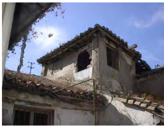
Estado previo (Elaboración propia).
