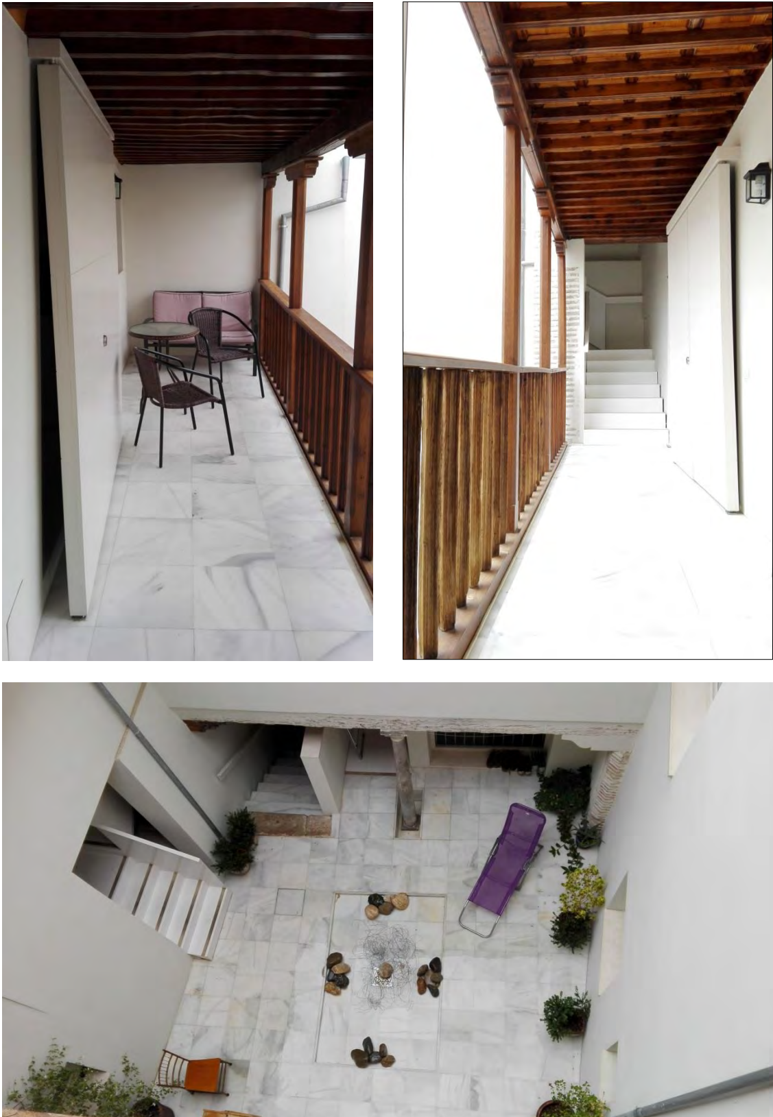
Fig. 4.1.03: Cuesta de San Gregorio 13. Arriba izquierda: Galería de planta segunda de la parte nazarí tras su rehabilitación. Arriba derecha: Galería de planta primera de la parte nazarí tras su rehabilitación. En ambas se ha contrastado el blanco del suelo, de los paramentos y de las abstractas carpinterías blancas que hacen de puertas abatibles con un contemporáneo sistema de quicaleras-gorroneas. Abajo izquierda: Vista cenital del patio con la alberca nazarí insinuada con un leve rehundido del pavimento de mármol, unida al resto de la rica complejidad del inmueble: Los elementos del s. XIV-XV, los castellanos del s XVIII y los del s XXI. Fuente elaboración propia (2016).
