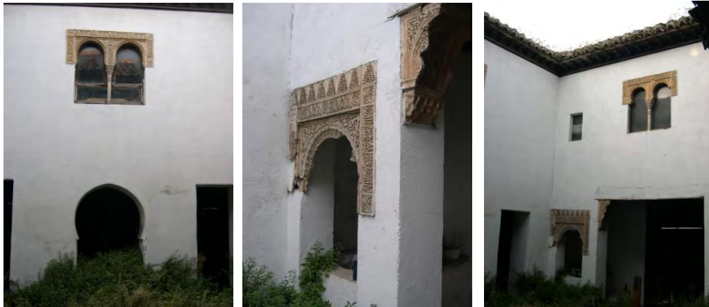
Vista de las cubiertas y del patio de la casa morisca con detalle de la decoración de los huecos que abren a éste
