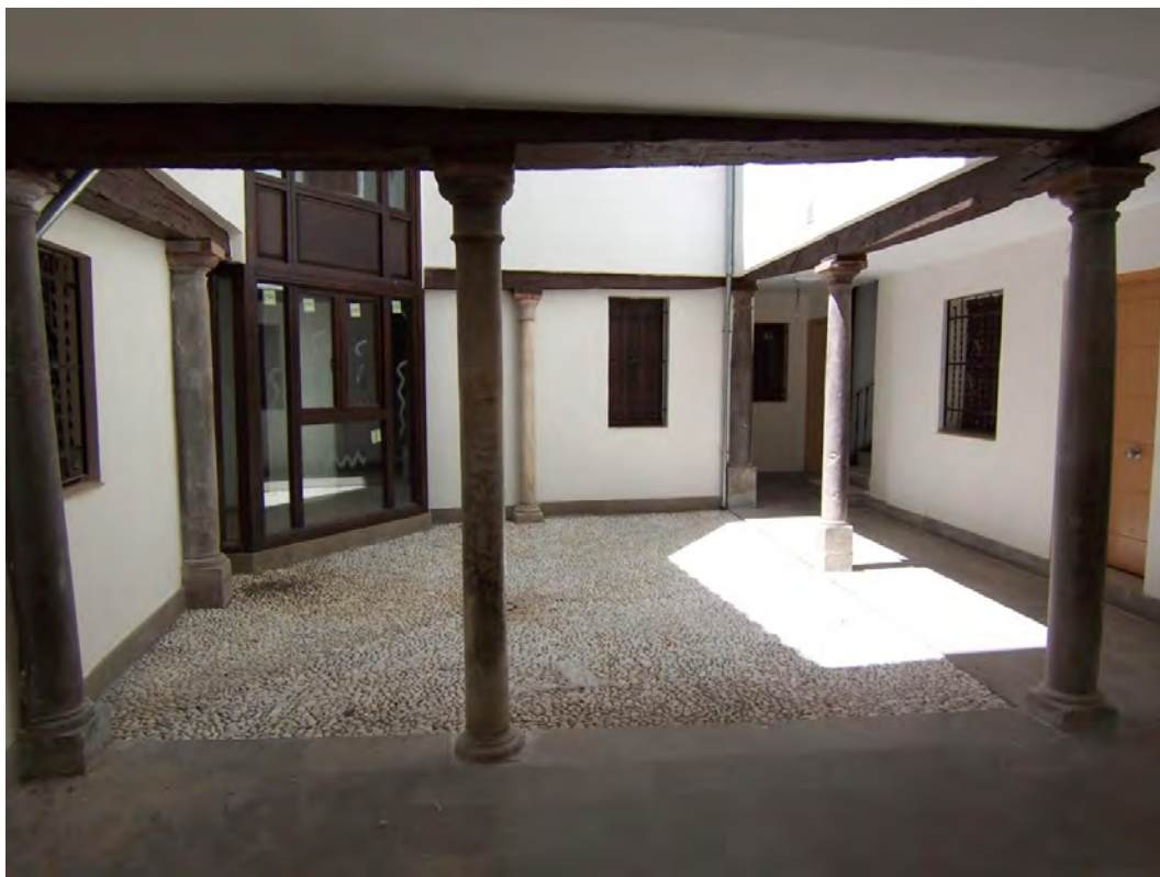
Resultado final de la rehabilitación del patio en el que destaca la sencillez en los acabados apropiada a la sobriedad de esta casa patio
