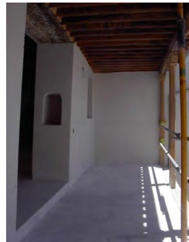
Proceso de recuperación de la planta segunda de la galería morisca: 1) Demoliciones previas y atirantado, 2) una vez reconstruida la cubierta y redirigidas las cargas se restaura su alfarje y se inician los revestimientos, 3) estado final antes de colocar los balaustres y las carpinterías
