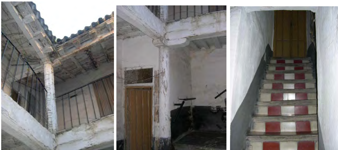
Izquierda, Galería superior del nº 45. Centro pie derecho y zapatas a nivel de patio. Derecha, escañera de subida la vivienda de planta segunda.
