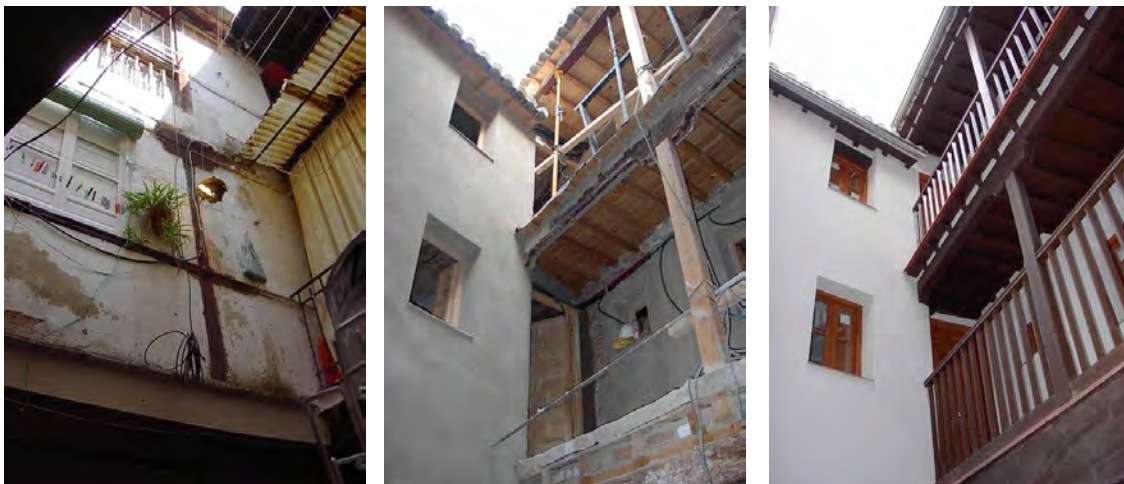
Izquierda, estado previo de las galerías de plantas primera y segunda ocupadas por usos privados y cerradas con materiales inapropiados. Centro, proceso de obra de rehabilitación de galerías con sustitución de algunos elementos deteriorados de la estructura de madera. Derecha, Resultado final de la rehabilitación
