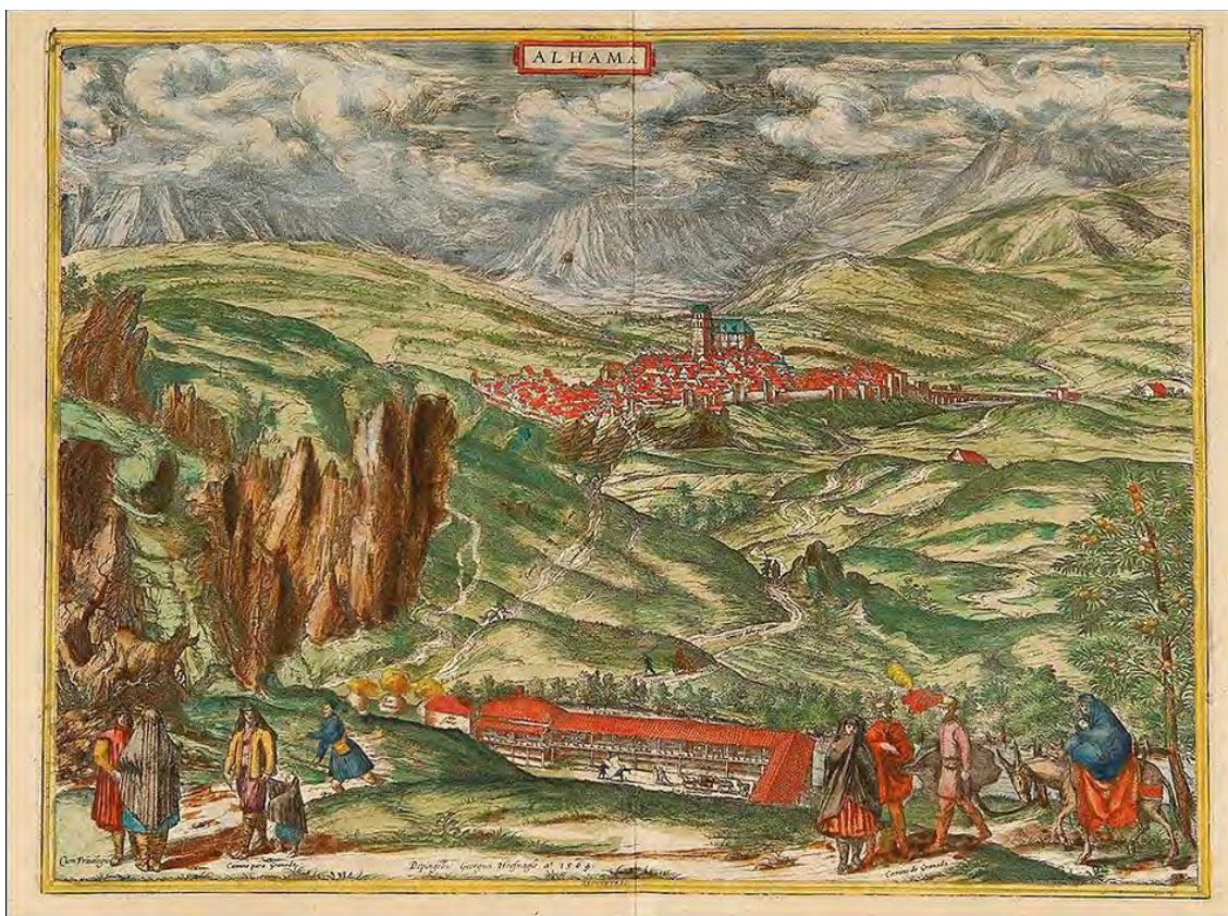
Fig. 3.2.04: Vista idealizada de Alhama de Granada desde el Baño: Grabado coloreado a partir del original “Alhama” realizado en 1535 por J. Hoefnagle
