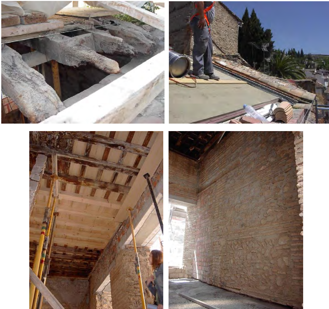
Obras de emergencia en la primera crujía, tras la paralización municipal. Arriba izquierda cabezas podridas en el alfarje plano de cubierta que ha sido rehabilitado. Arriba derecha, faldón de cubierta en reconstrucción. Abajo izquierda, alfarje rehabilitado pendiente de acabados. Abajo derecha, fábrica de cajones de mampostería y verdugadas de ladrillo rehabilitada.
