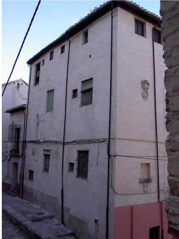
Fachada trasera a calle Santa Ana. Estado actual.
