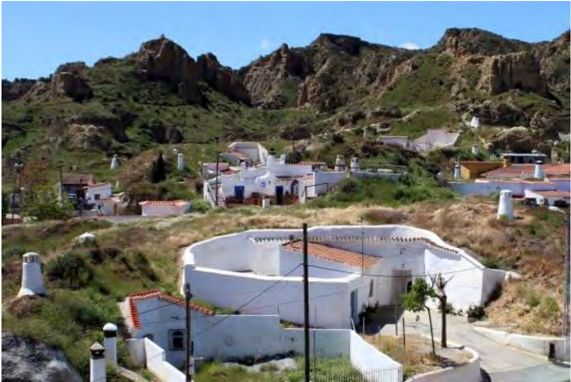
Fig. 3.3.17: Casas-Cueva en el borde sur del Conjunto Histórico de Guadix, dentro del Área Homogénea o, según la Innovación del PGOU-2002, dentro del Sector de Cuevas. Fuente: Elaboración propia
