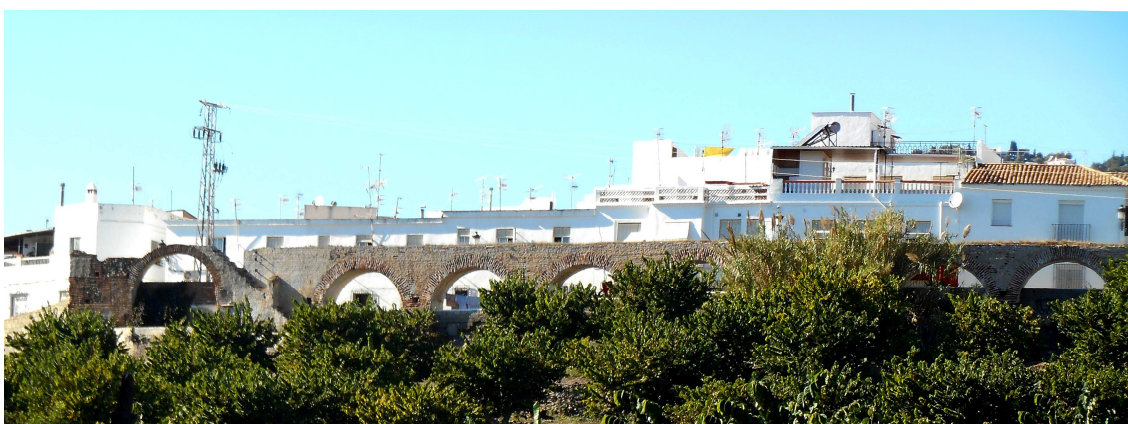
Fig. 6.8 Acueducto del Ingenio del Agua de Almuñécar 1178 .
