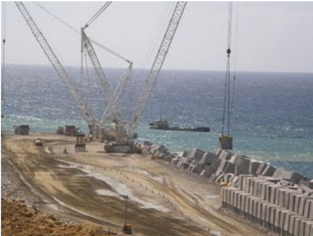
Figura 4.6: Colocación de piezas con grúa.
