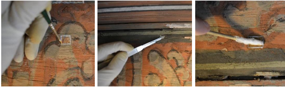
Figura 37. Izq. Señalización de la zona de cata con acuarela blanca. Centro. Realización de cata de forma mecánica empleando bisturí. Drch. Realización de cata mediante soluciones químicas aplicadas con hisopo.
