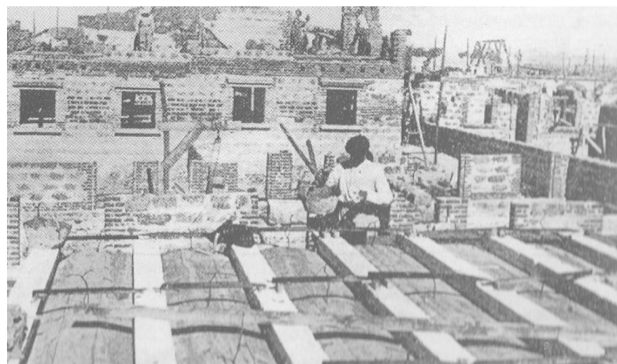
Figura 12. Bovedillas fabricadas in situ. (Ministerio de la Gobernación 1940 - 1953 . Reconstrucción. Dirección General de Regiones Devastadas y reparaciones).
