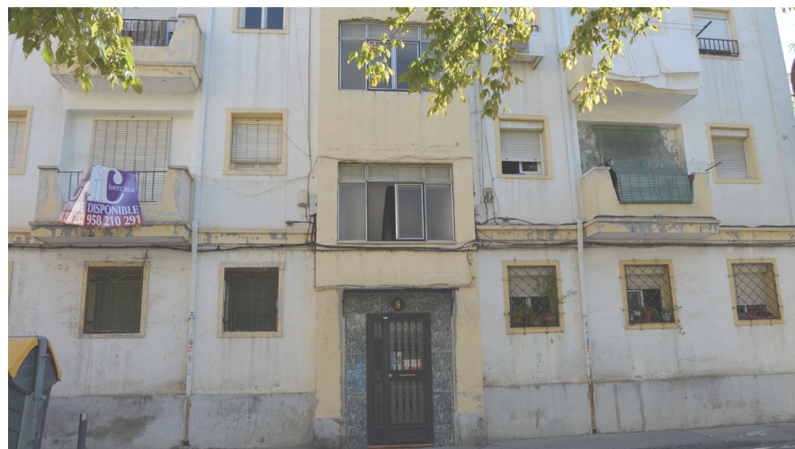
Figura 15. Fachada principal. Vivienda social barriada de La Chana.(Foto Propia).
