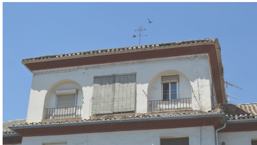
Figura 19. Torreón de núcleo de comunicación vertical. Viviendas sociales en Bajo de Cartuja. (Foto Propia).
