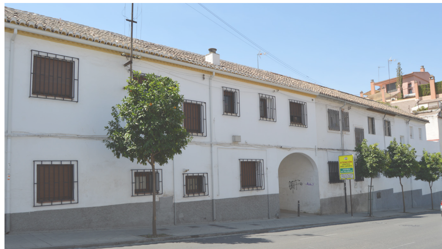
Figura 18. Fachada principal. Viviendas sociales en Bajo de Cartuja. (Foto Propia).
