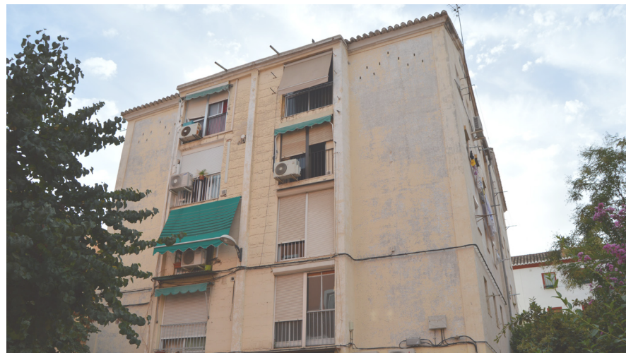
Figura 24. Fachada trasera. Vivienda social barriada del Zaidín. ( Foto Propia ).
