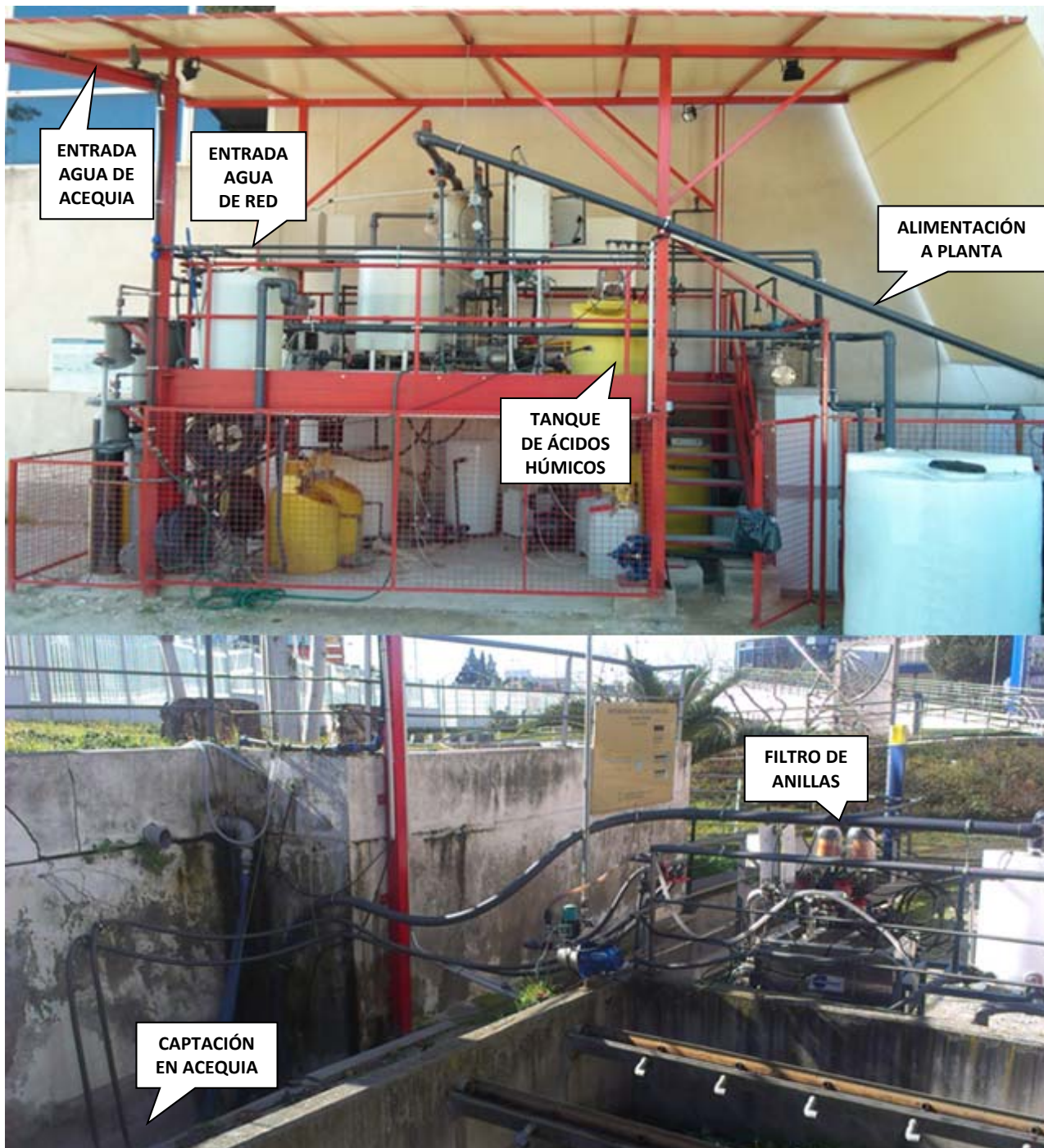
Figura 11. Vista general de la planta piloto con detalle del sistema de alimentación de agua.
