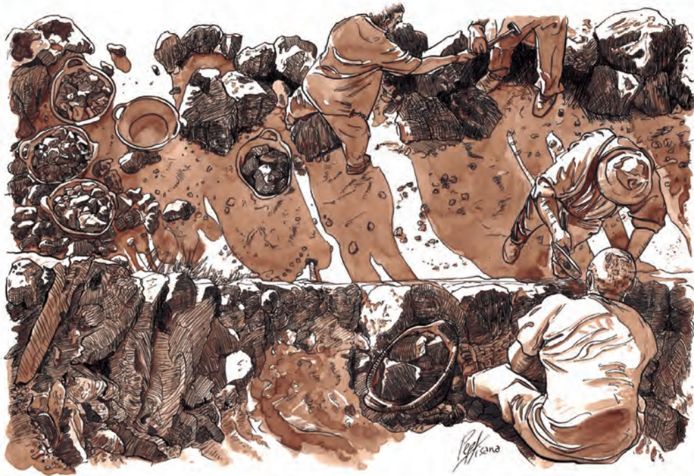
Fig. 303. (Avaria, Margenadores: campesinos constructores, 2017, pág.2).
